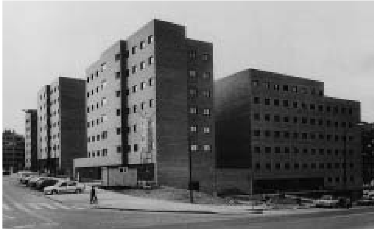
Vista general SE
