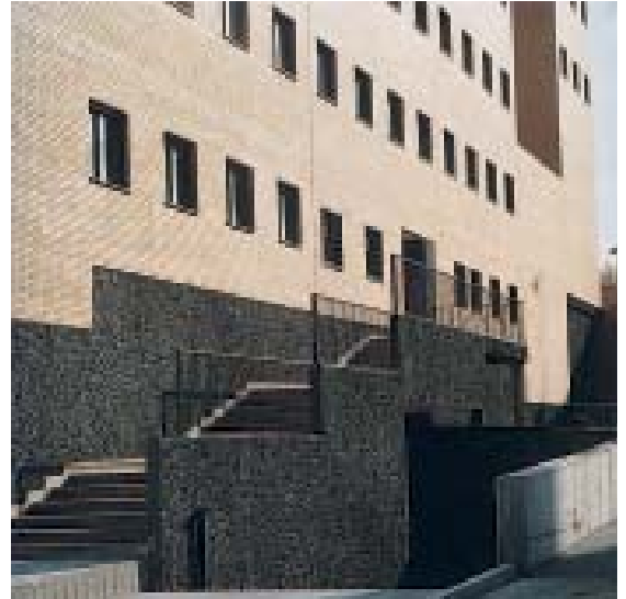
Vista del basamento del edificio
