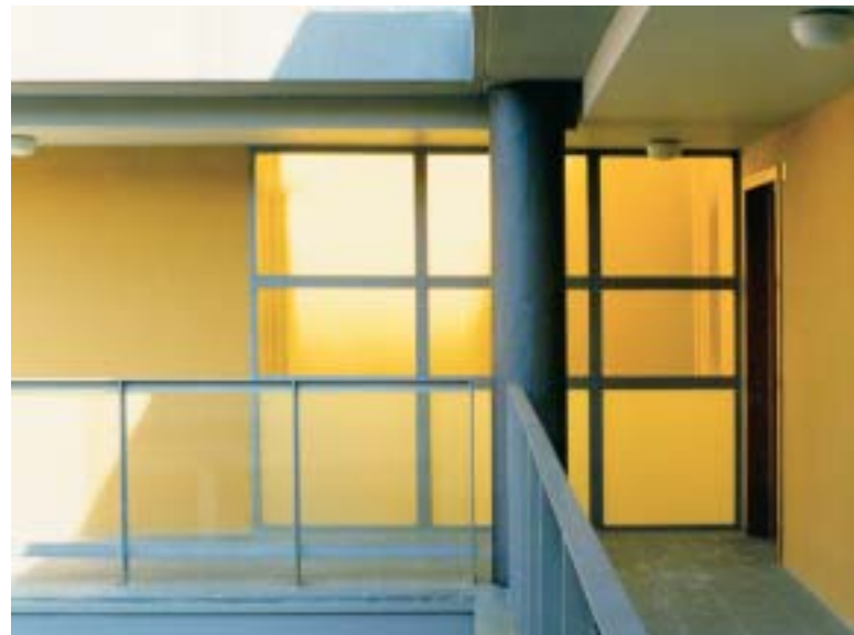
Vista de los paneles de separación entre el patio interior común y los patios de vivienda
