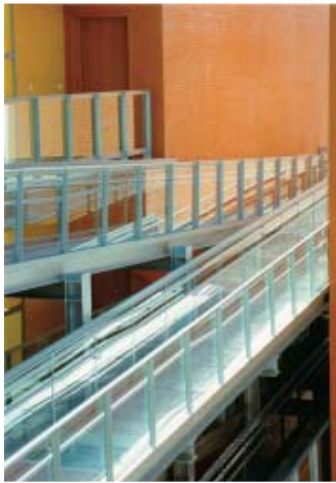
Situación de la rampa entre las fachadas
