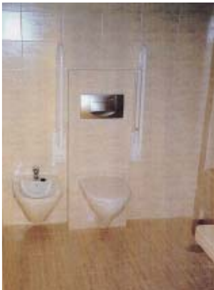
Colocación de barras auxiliares en aparatos
