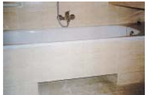
Cajeado en la parte inferior de la bañera para la instalación de grúa
