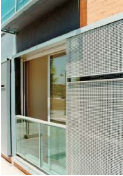
Cerramiento de los huecos
