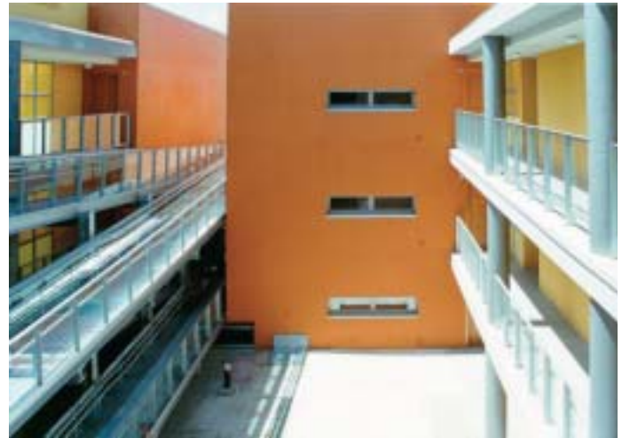
Vista interior del patio desde el NE
