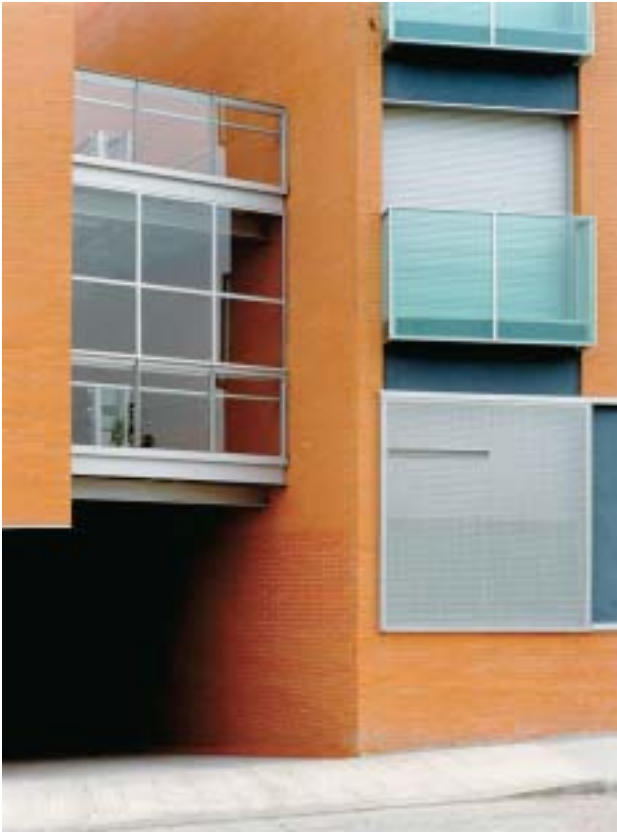
Vista del acceso al edificio. Fachada NE
