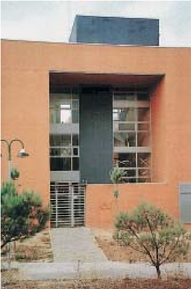
Vista de la rampa en la fachada SO
