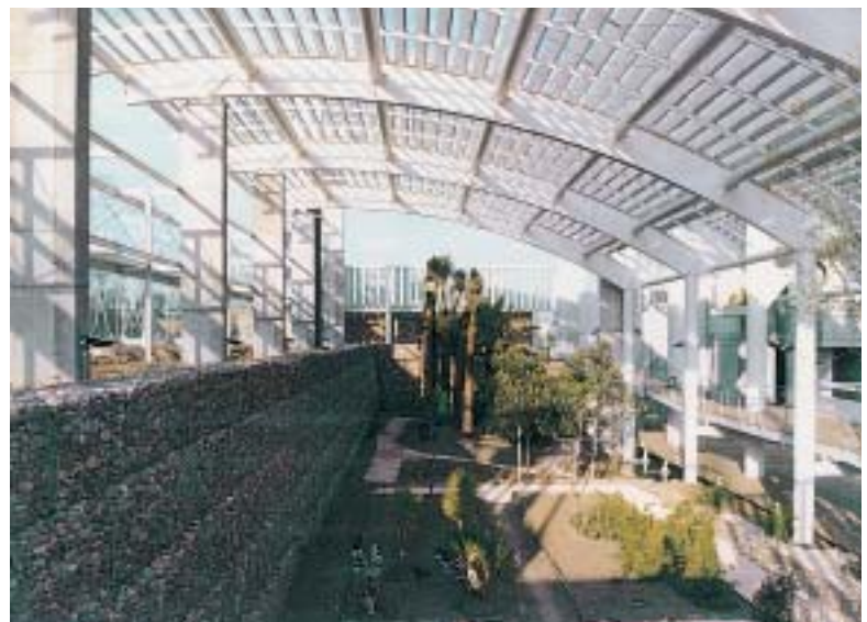
Vista interior de la zona de los umbráculos
