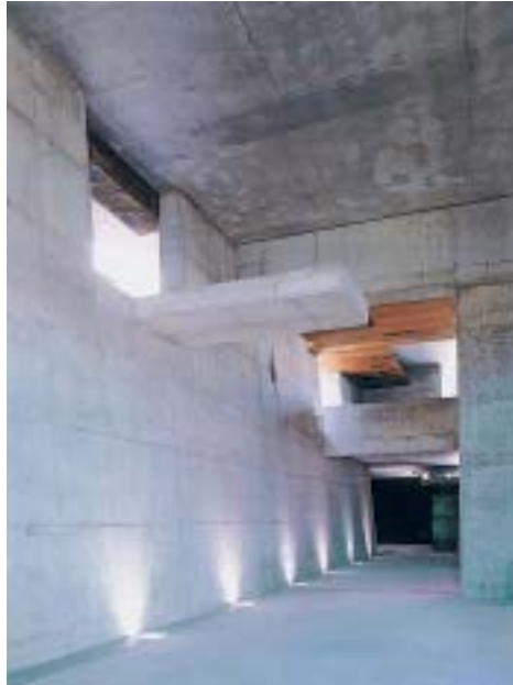
Vista interior de los huecos en el muro S del área de exposiciones
