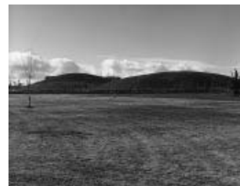
Reutilización de la capa vegetal y tierras procedentes de los desmontes
