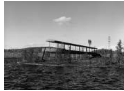
Detalle de la pasarela del estanque
