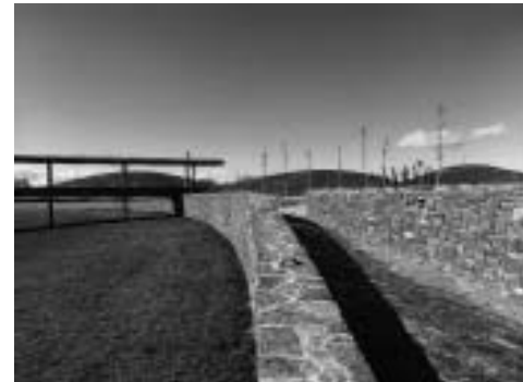
Vista del muro
