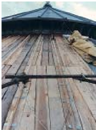
Colocación de las piezas de cubierta
