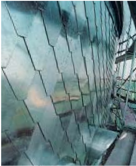
Vista de la colocación en cubierta de la tejas de zinc
