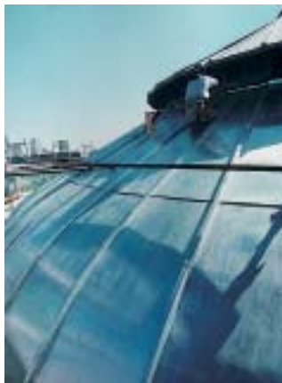
Vista del proceso de remate del primer tramo de cubierta
