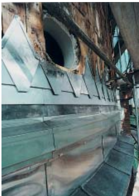
Proceso de colocación de las distintas piezas de zinc
