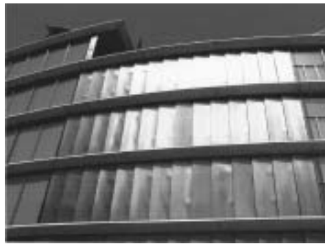
Vista de fachada ciega transventilada.
