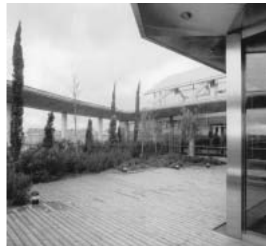
Vista de terraza aislante ajardinada.
