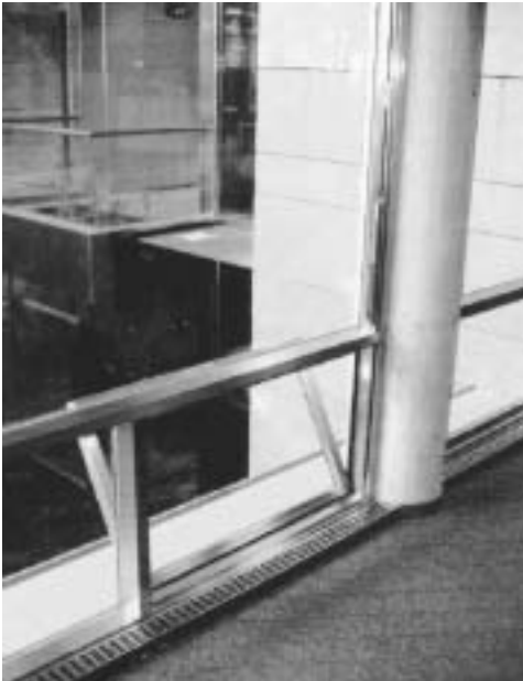
Detalle apertura manual de las ventanas de oficinas.
