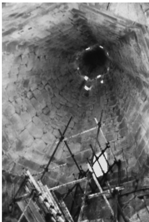
Vista del andamio - escalera, antes de las obras.
