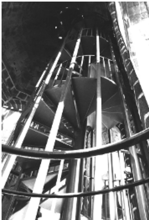
Vista general de la escalera.
