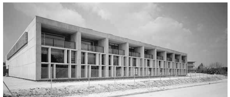
Vista de la fachada E.
