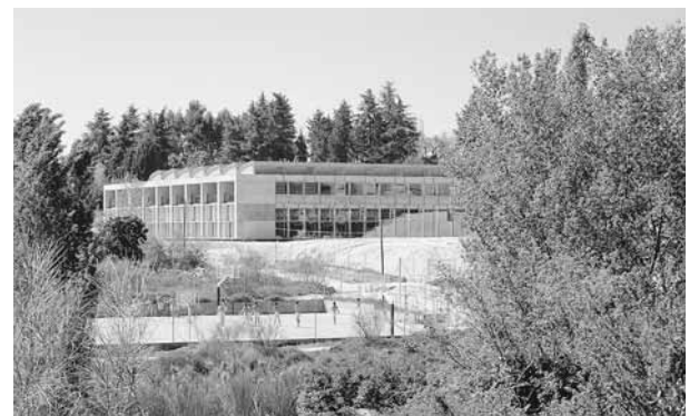
Vista general NE.
