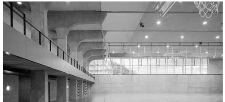
Vista del polideportivo.
