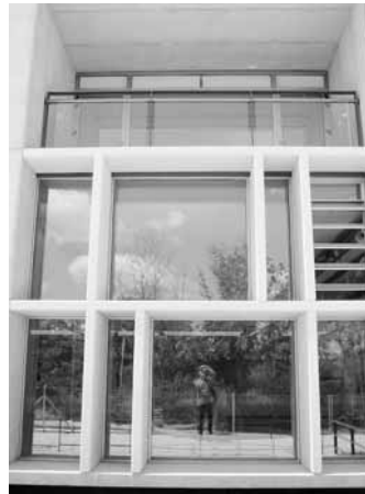
Vista de la fachada E.
