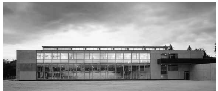
Vista de la fachada N.
