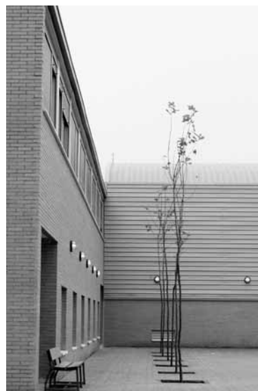
Encuentro del volumen del gimnasio con el resto del edificio.
