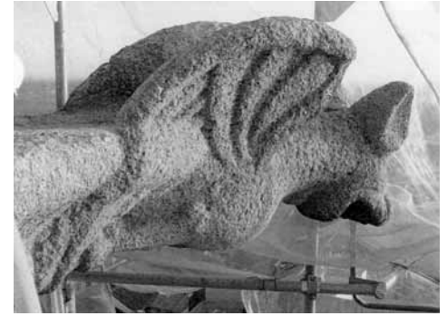
Detalle de gárgola restaurada.
