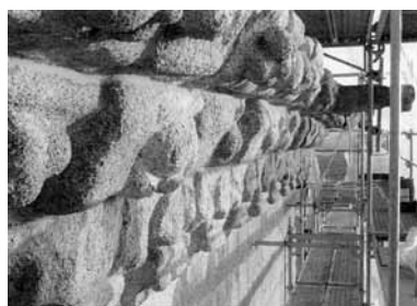
Detalle de la cornisa del cuerpo de campanas restaurada.
