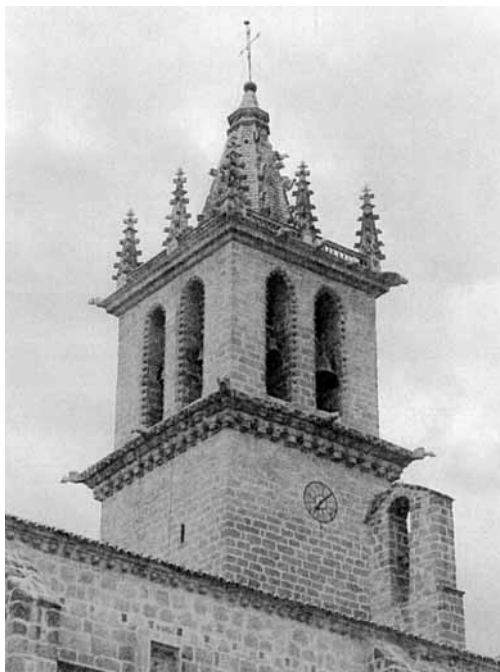
Vista NE de la torre restaurada.
