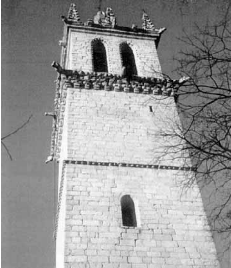
Alzado S, antes de la restauración.
