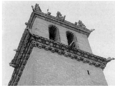
Vista de las cornisas de fachada E restauradas.
