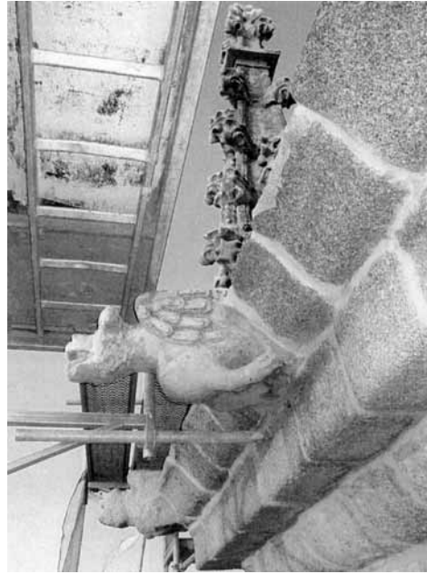
Vista general de cornisa superior.
