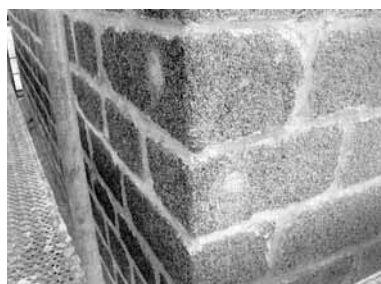
Vista de dos taladros finalizados y tapados con mortero.
