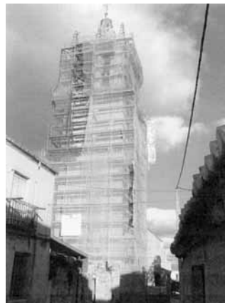
Vista del andamio de la torre.
