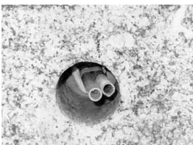
Detalle de taladro y tubos de inyección.
