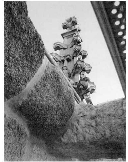
Detalle de la cornisa del chapitel restaurada.
