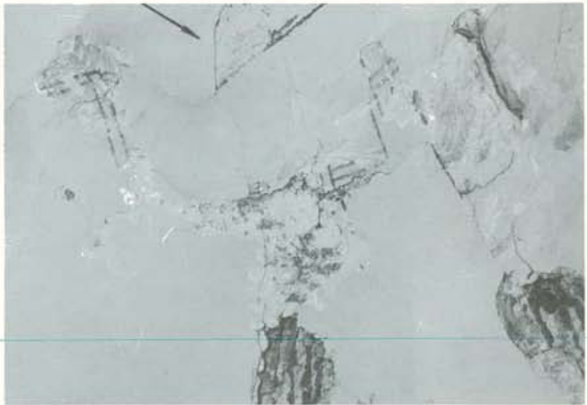
(Lám. 17). Se observa en la parte superior de la foto el rebaje producido en el muro y la inclusión de una viga de madera.
