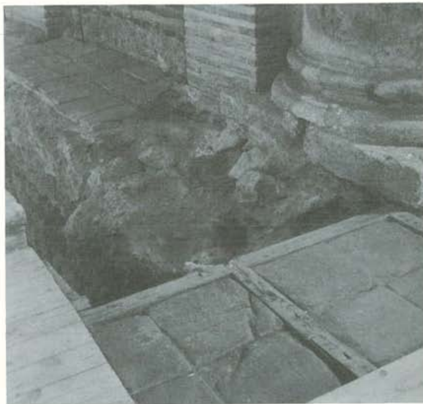
2. Detalle del suelo de losetas de ladrillo con entramado de madera en el arranque de la nave central, junto al pilar delantero derecho.
