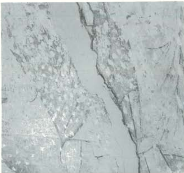
(Lám. 17). Se observa en la parte superior de la foto el rebaje producido en el muro y la inclusión de una viga de madera.
