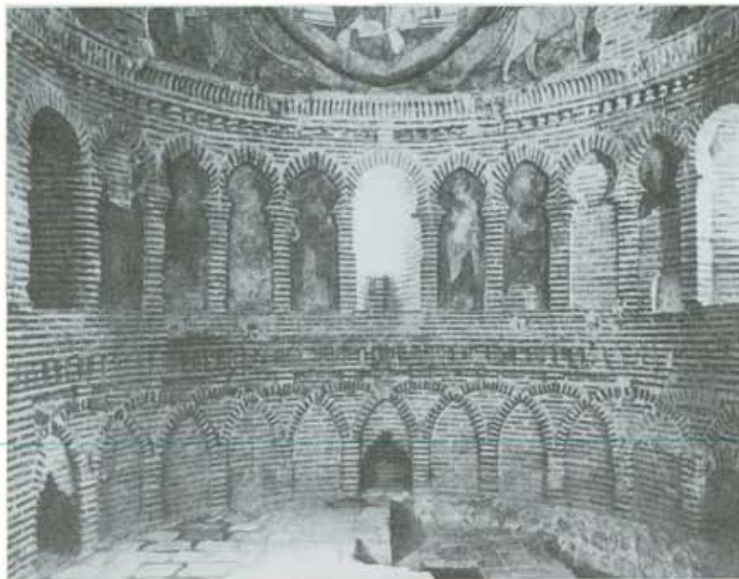
Lámina 6. Aspecto general de los dos registros inferiores del interior del hemiciclo del ábside.
