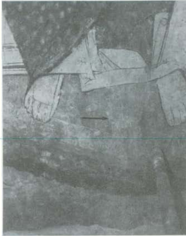
(Lám. 27 b). Grieta transversal al "tratteggio".
