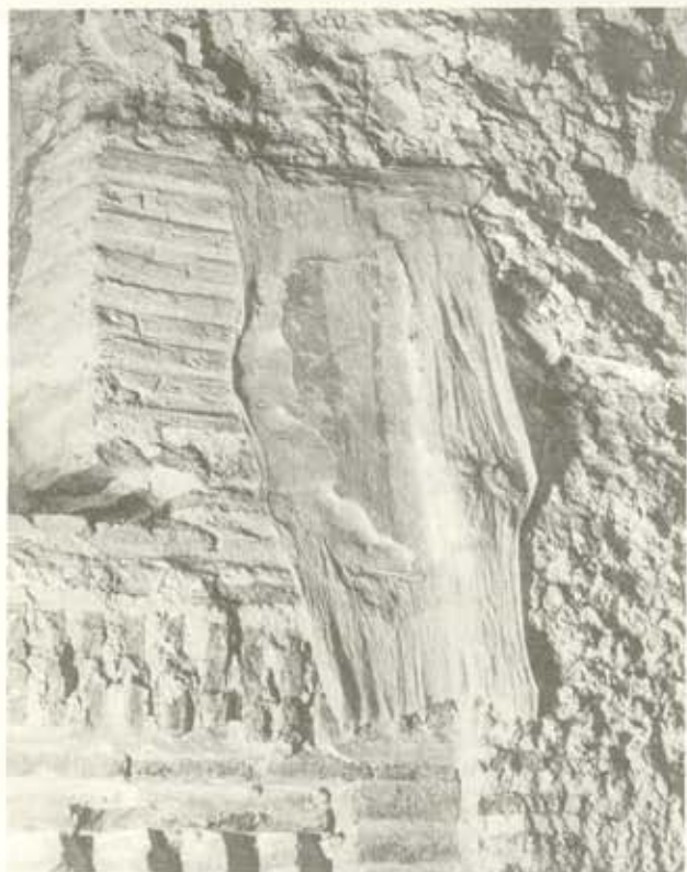
(Lám. 15). Fragmento de la parte superior izquierda sujeto al muro por la gasa.
