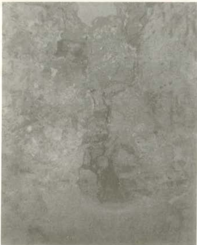
(Lám. 23). Aspecto de la grieta parcialmente rellena y restaurada.
