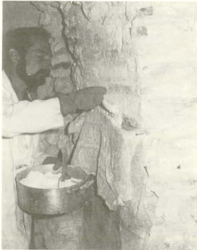
(Lám. 21). Operación de relleno con caseinato cálcico. Cuando éste queda adherido se retira la tela de sujeción.
