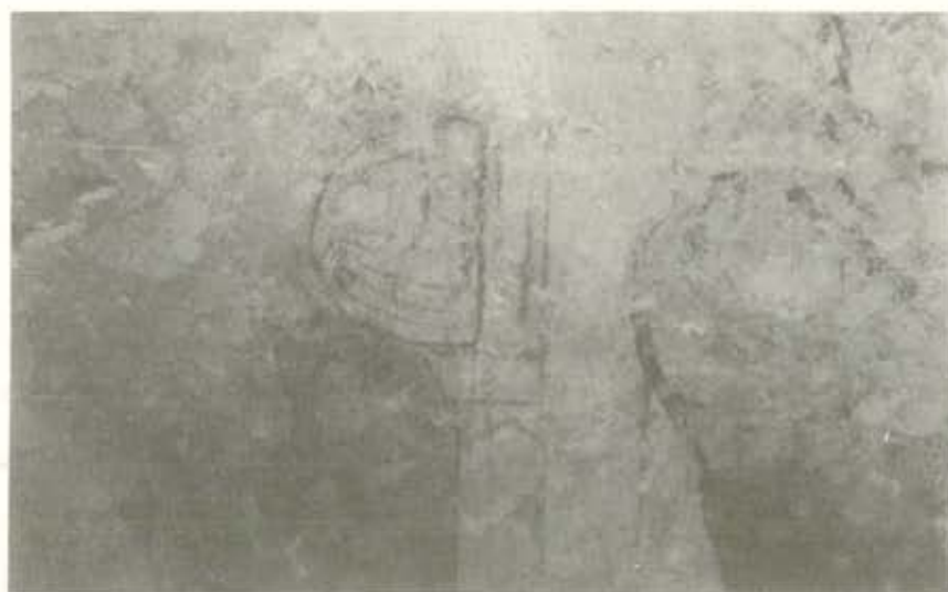
(Lám. 31). La zona mostrada anteriormente ya restaurada.
