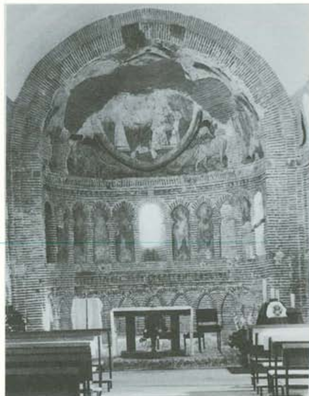
(Lám. 33). Vista general del interior del ábside ya restaurado. Se observan las grandes lagunas reconstruidas siguiendo la estructura del muro.
