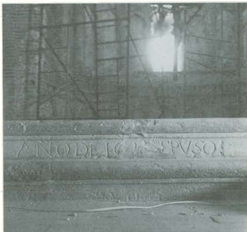
2. Detalle de los peldaños de sillería. Fecha de su instalación.
