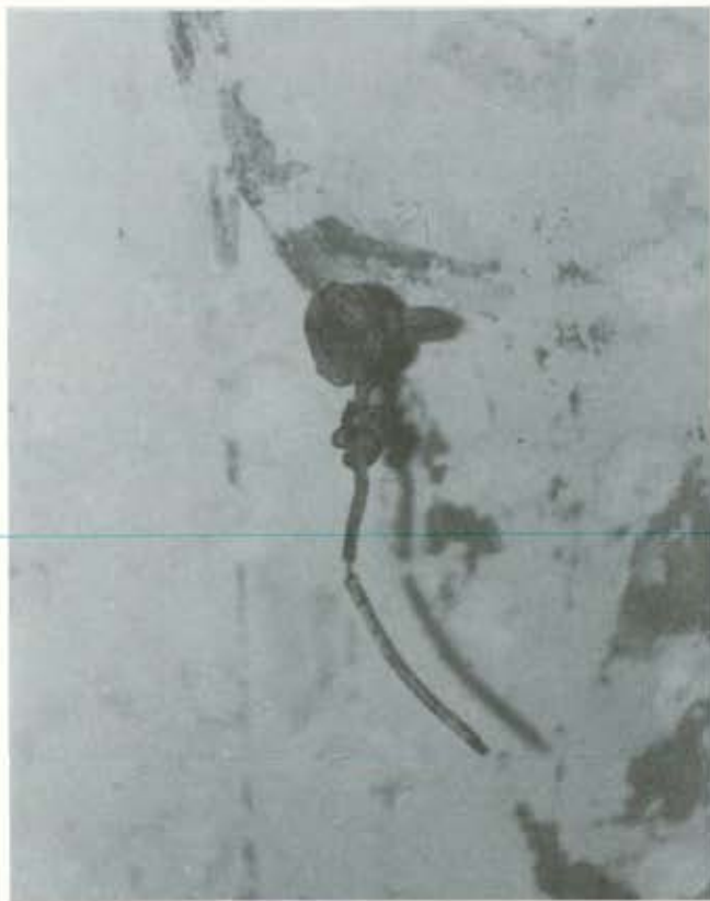
(Lám. 20). Clavo de sujeción incrustado en el muro.
