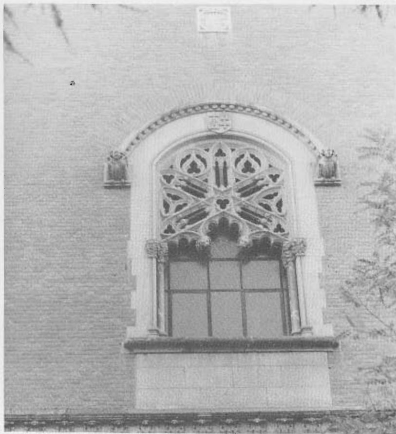
Alcalá de Henares. Palacio Arzobispal.
