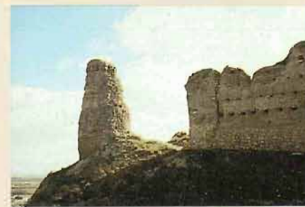
Fachada principal, Torre de Berrio (D) y Torre de Yeso (E). (Fot. 16.)
