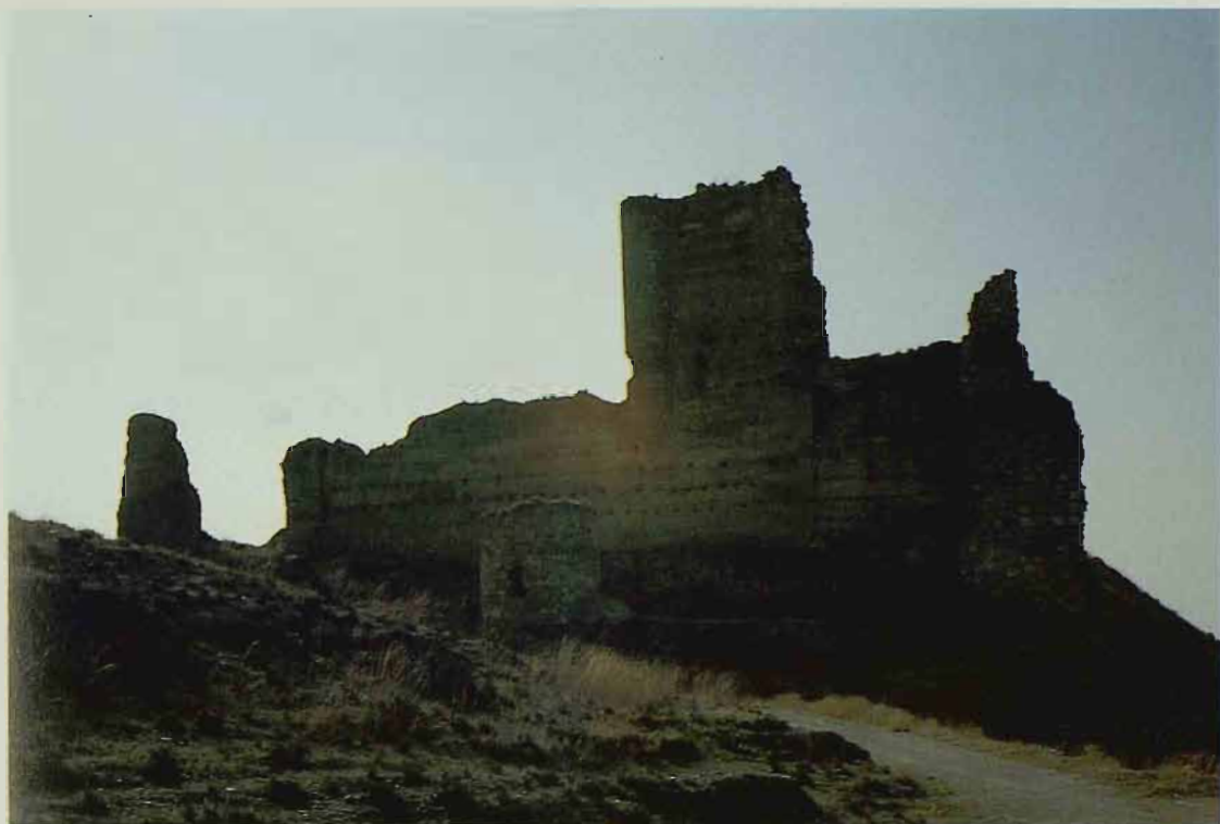
Fachada oeste del castillo de Fuentidueña de Tajo, frente al antiguo foso exterior. (Fot. 23.)
