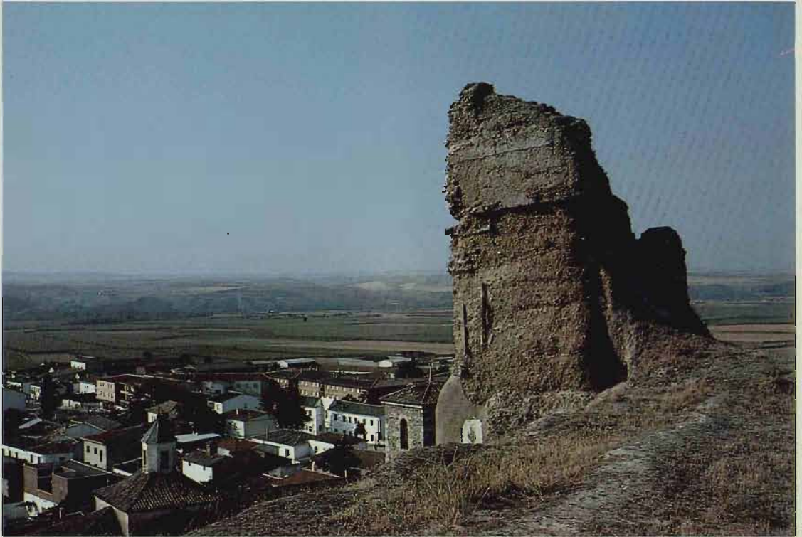
Torre de las Armas de la Rondella (H). (Fot. 21.)
