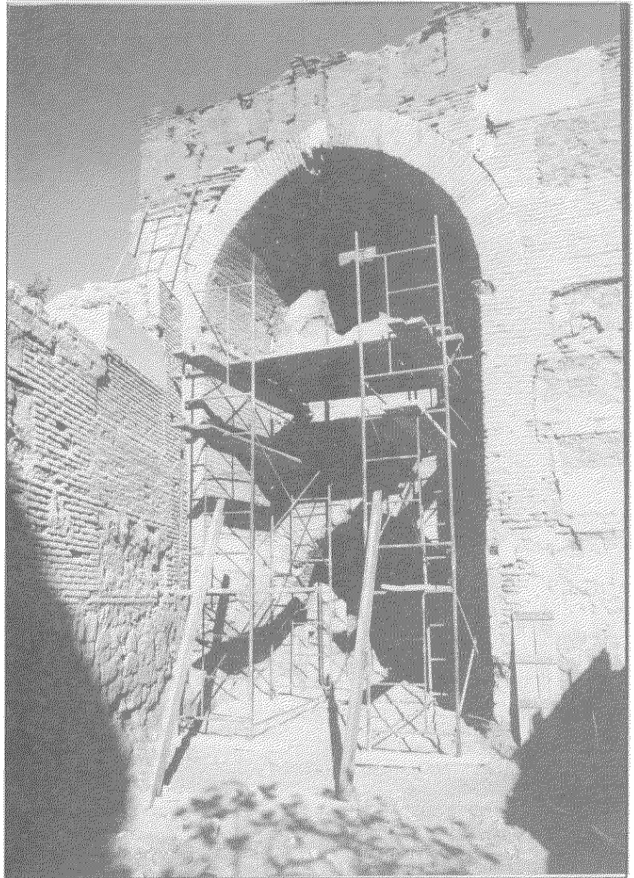
Fig. 11: Trabajos de restauración en la Puerta de Burgos (foto T.E.A.R.).
