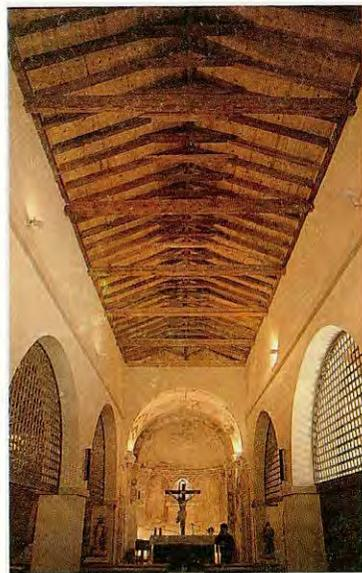
pilastras y estructura de la cubierta tienen las debidas condiciones de resistencia y estabilidad y la cubierta, una vez reparadas y repuestas las tablas ripias y las tejas curvas, tiene las necesarias garantías de estanqueidad.
