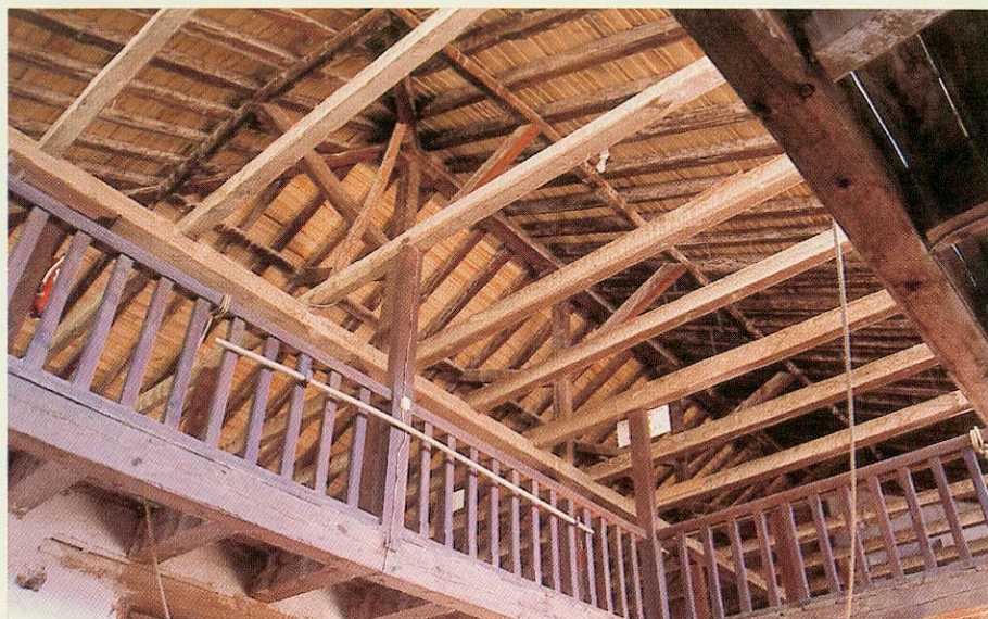
Toriles. Detalle de la cubierta atirantada.
