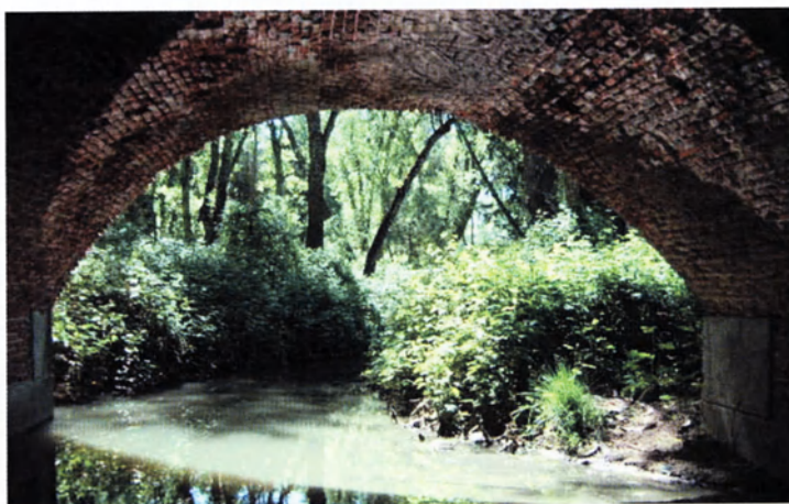
Arroyo de Antequina desde debajo del puente Garrapata.
