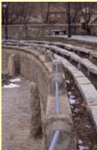
Detalle de las gradas de la plaza
