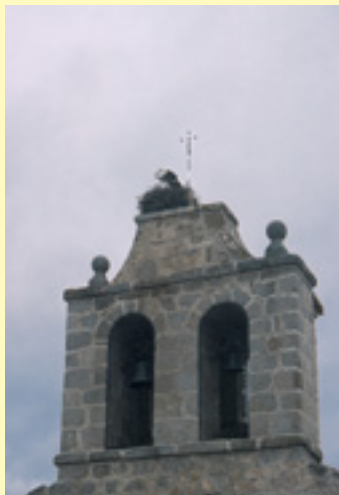
Espadaña de la iglesia
