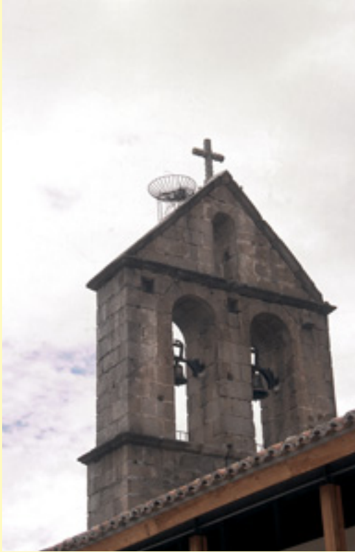
Detalle de la espadana de la iglesia
