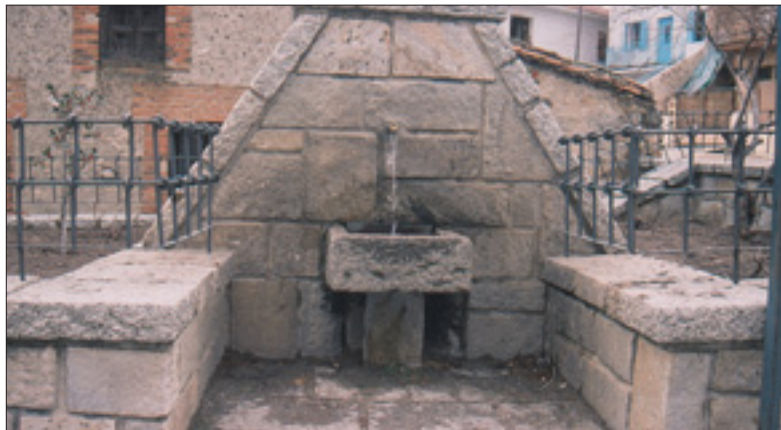
Fuente en la calle Real
