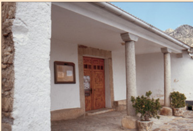
Pórtico de la Iglesia
