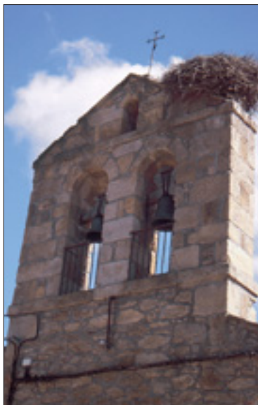
Espadaña de la iglesia
