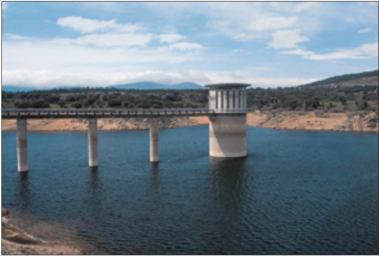
Presa de Puentes Viejas
