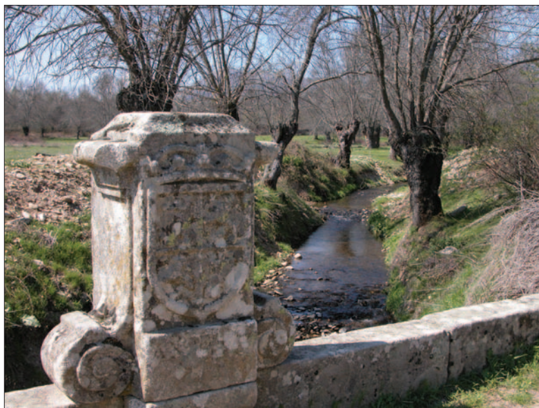
Puente del Rodeo en la Fresneda. 2005
