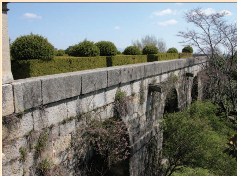
Muro que salva el desnivel entre los jardines del monasterio y la Herrería. 2005
