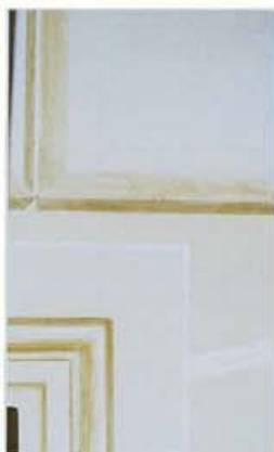
Revocos con pinturas simulando molduras y despieces
