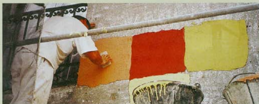
Diferentes momentos durante el proceso de revoco de las fachadas
