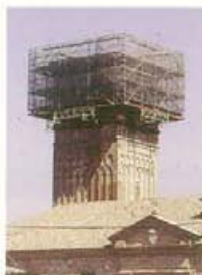
La Torre durante el proceso de reconstrucción del chapitel
