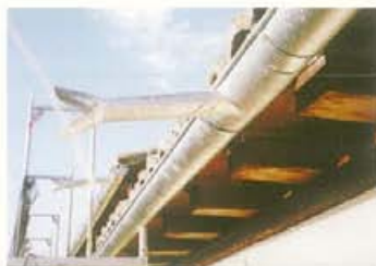
Los alerones antes y después de la intervención
