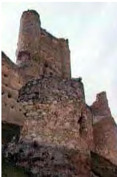
Imagen del castillo de Fuentidueña donde se aprecian bien los “mechinales” en los que se introducían las vigas de madera necesarias para la construcción de estos lienzos de tapial.
