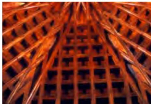
Detalles de los entramados de madera que conforman las armaduras mudéjares, cada una con elementos propios, en los que se aprecia como característica común la presencia esencial del “almizate” o “harneruelo”, es decir, la pieza horizontal, con forma estrellada generalmente, que centraliza todas las piezas del complicado
