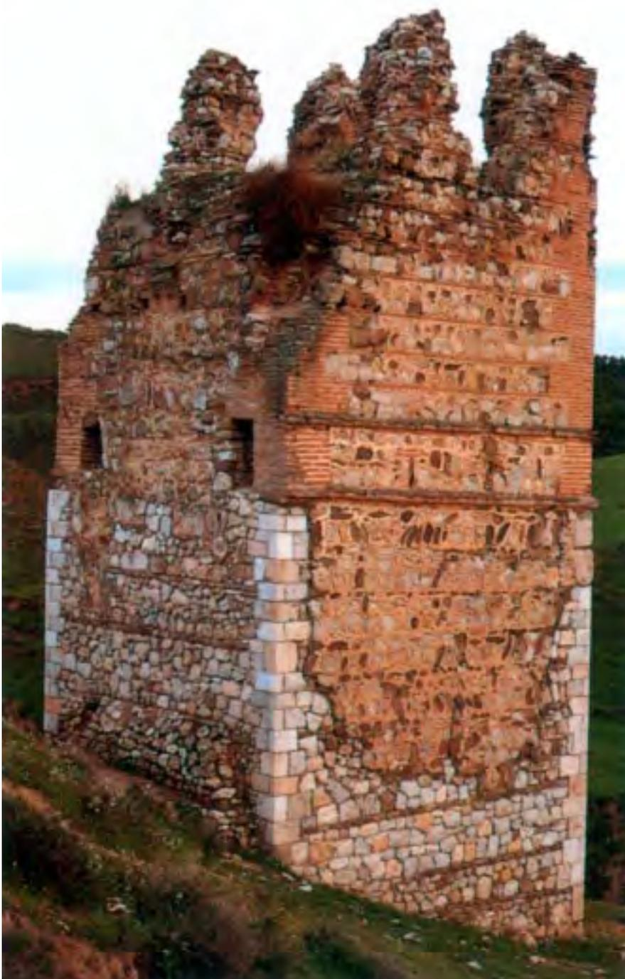
Torre Albarrana de Alcalá la Vieja, construida sobre un zócalo de sillería maciza con sillería concertada y su mitad superior encintada con ladrillo. Las torres albarranas eran construcciones que se adelantaban de la línea de muralla y se unían con ella con un muro o puente. Efectivamente, por encima de esta torre un arco de ladrillo comunicaba ésta con el adarve o paseo perimetral de la muralla.
