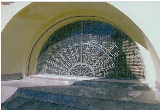
Detalle de la vidriera. Verteaguas del vano localizado en el crucero
