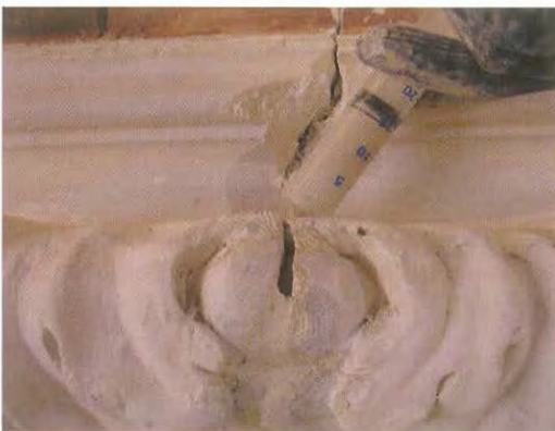
Consolidación de los marcos con una emulsión acrílica no superior al 15%
