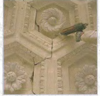
Inyección de resina epoxi
