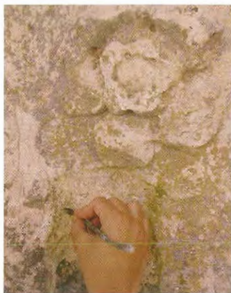
Limpieza mecánica a punta de bisturí
