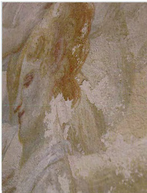
En la imagen se aprecia la pérdida del intonaco, de la policromía y los restos de la sinipie sobre el arriccio
