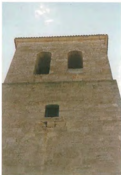
Vista de los cuerpos superiores de la torre antes de la restauración. Alzado norte
