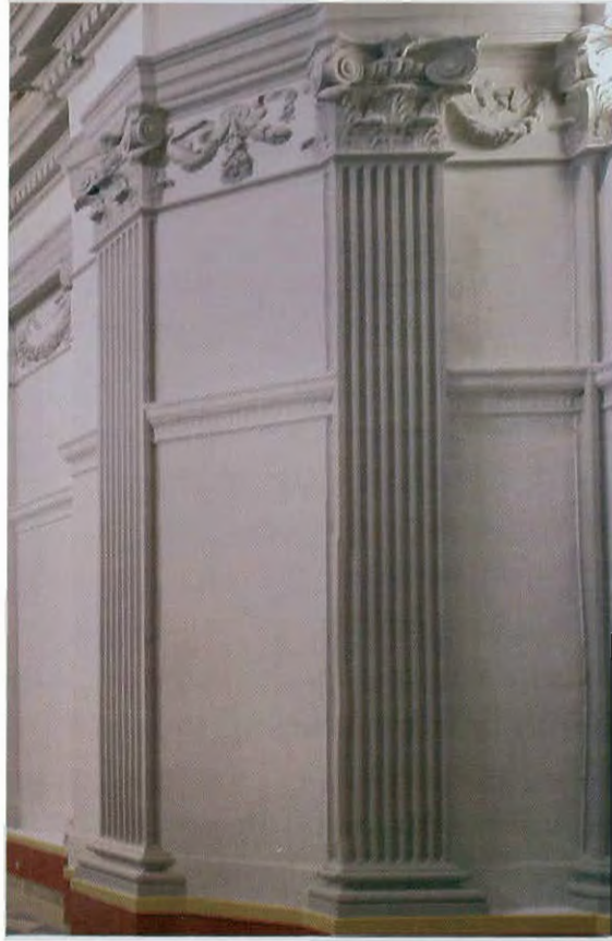
Detalles de pilastras estriadas de capitel compuesto de la nave central
