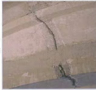
Saneado de grietas
