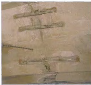
Perforaciones para insertar varillas de fibra de vidrio
