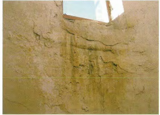
Alteraciones causadas por la humedad en paredes y en la decoración
