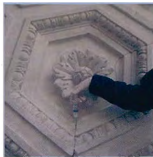
Sellado de las grietas
