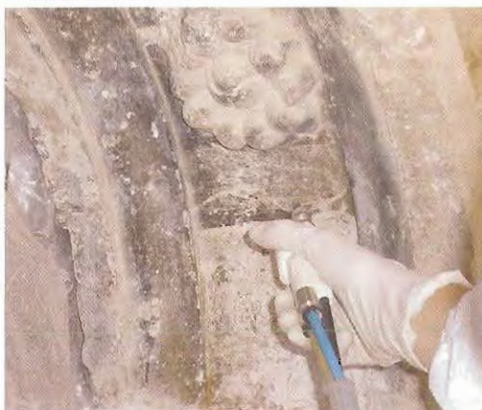
Limpieza mecánica con microabrasamiento
