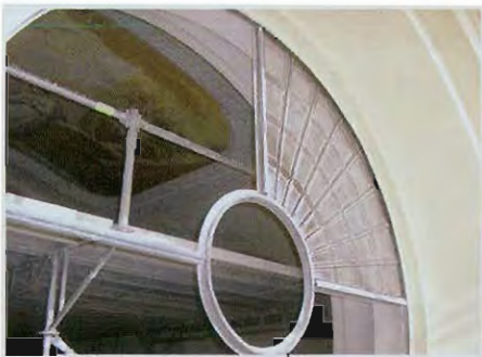
Montaje de la vidriera y estado final del rosetón de la fachada oeste
