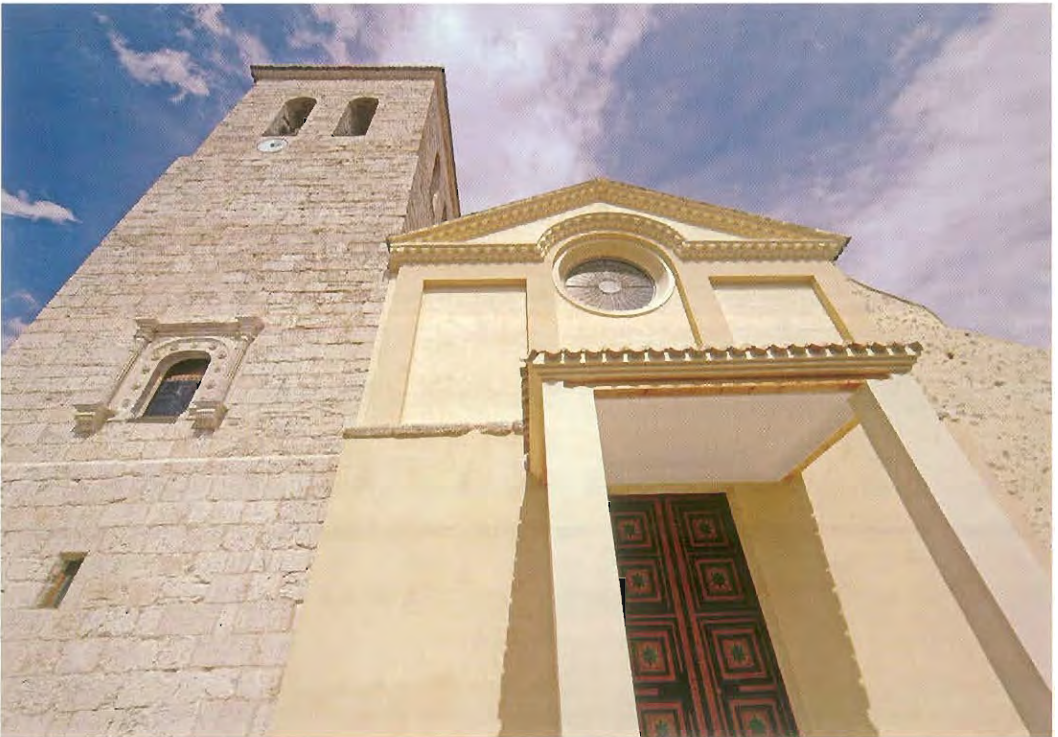
Vista de la torre y la portada tras la restauración
