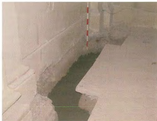
Planteamiento de la zanja de la nave
