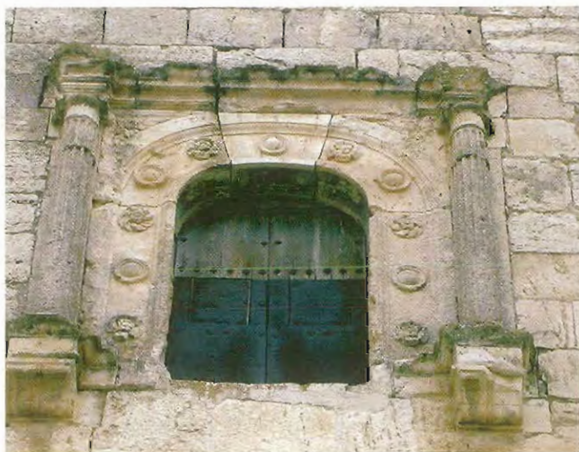
Vista general de la ventana antes de la restauración
