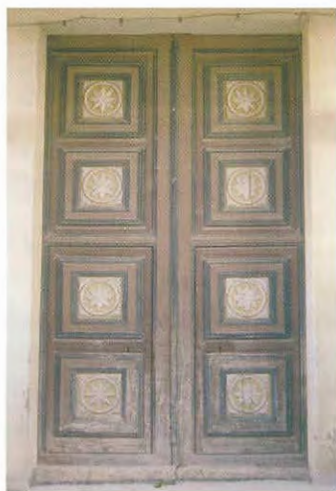
Puerta oeste. Estado inicial y final
