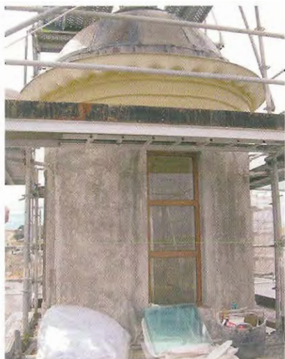
Proceso de restauración de la linterna y estado final
