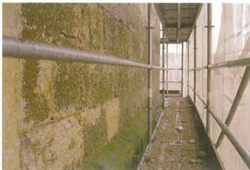
Estado inicial y final de la fachada norte
