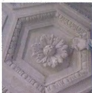
Sellado de las grietas
