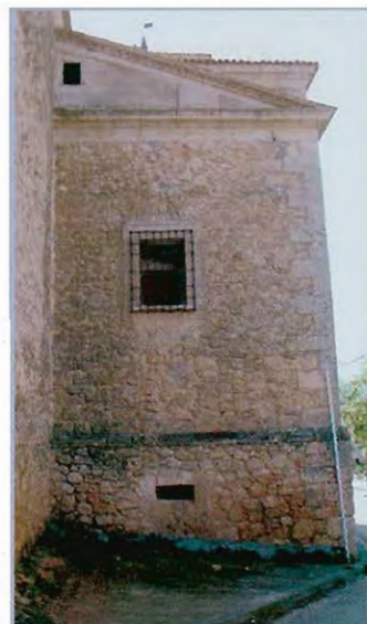
Fachada este de la Capilla del Rosario
