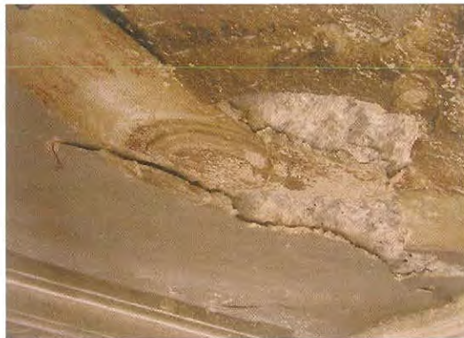
Levantamiento de las capas que componen el fresco por la presencia de criptoeflorescencias localizadas en la pechina de San Agustín
