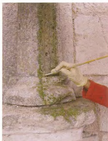
Limpieza biocida y eliminación de biodepósitos
