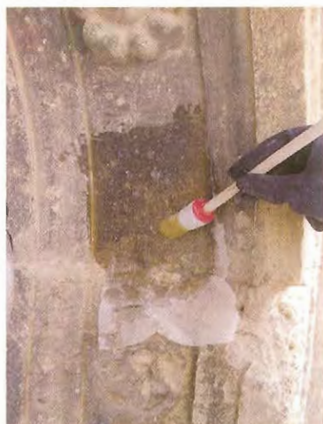
Limpieza química con papetas
