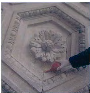
Limpieza de la suciedad adherida
