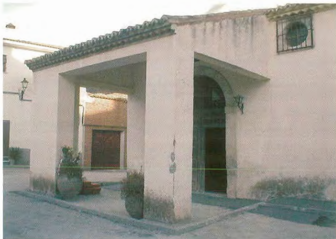
Pórtico sur antes y después de la restauración
