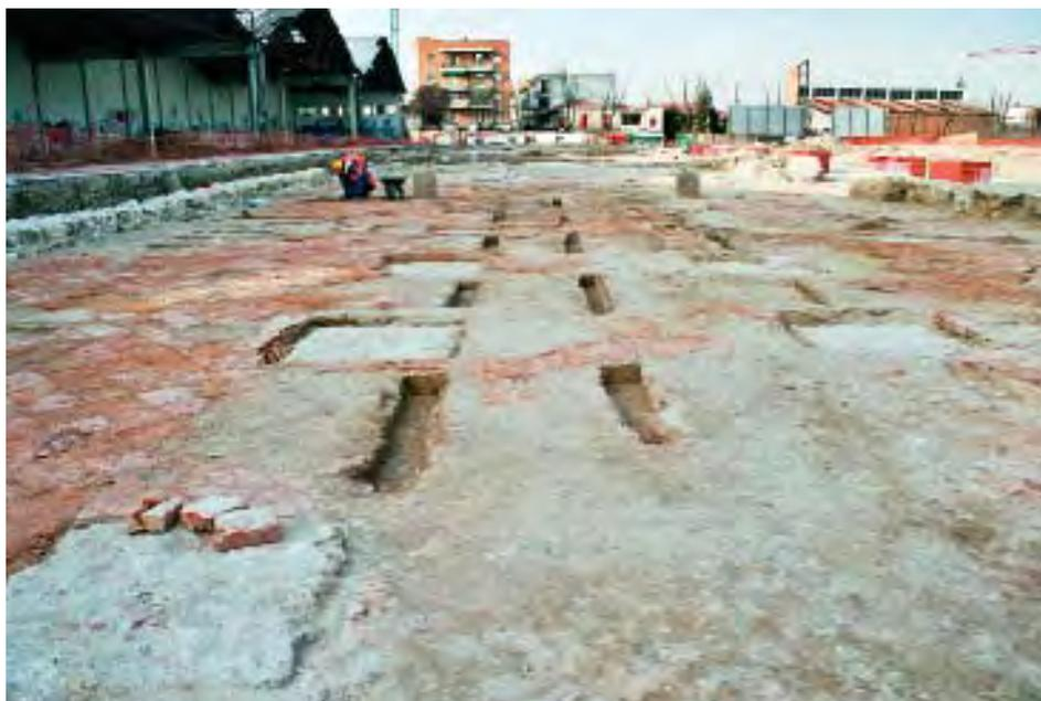
Figura 4. Pilares de sustentación de las bóvedas de la nave Oeste.
