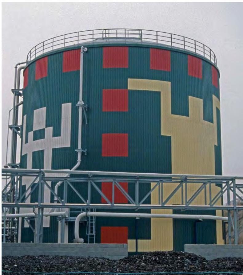
Digestor de la Planta de Biometanización y Compostaje de Pinto. El biogás obtenido en el digestor es utilizado para la obtención de energía eléctrica
