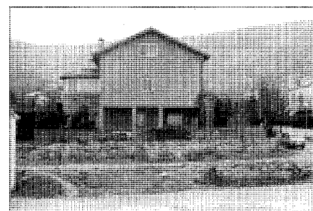
Vivienda unifamiliar aislada con la cubierta a dos aguas posterior a la reforma
