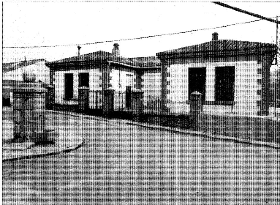
Escuelas. Fachada principal
