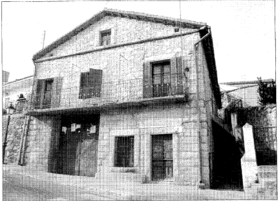
Vivienda en la calle Mayor, 45
