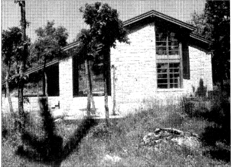
Vista de la fachada principal
