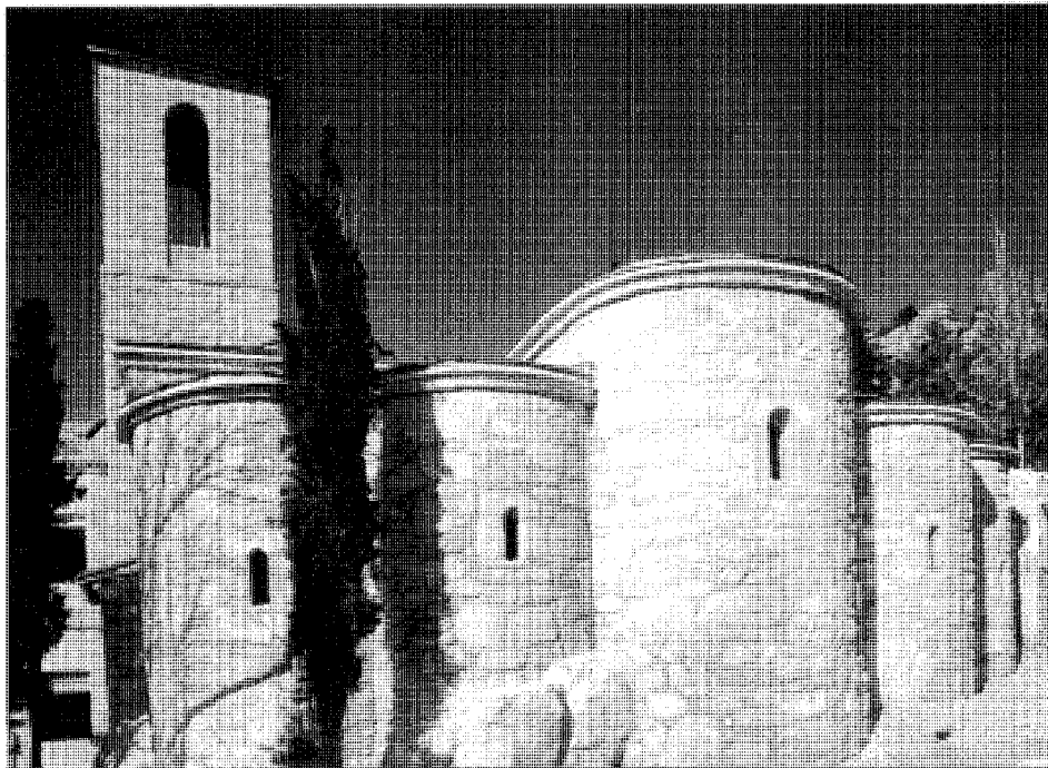
Absides y torre de la iglesia tras la reciente rehabilitación
