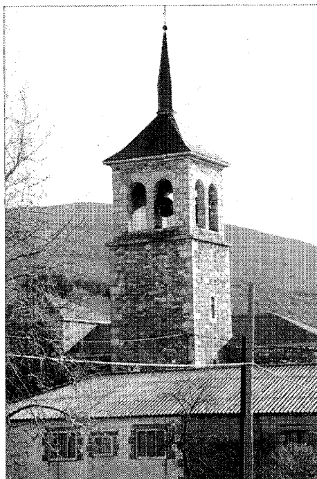
Vista de la torre
