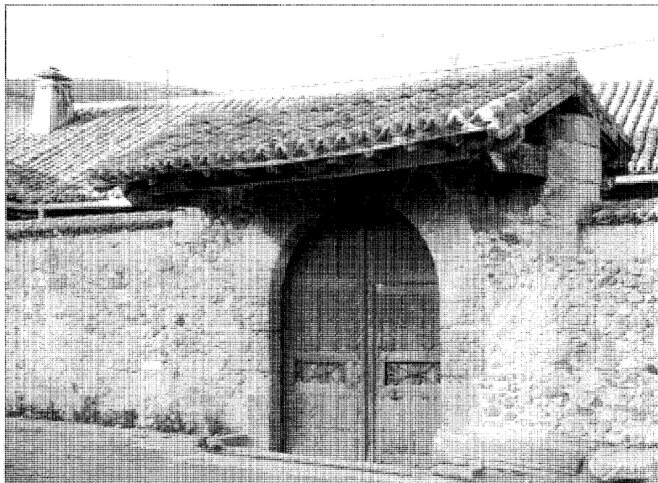
Detalle del portón de acceso visto desde la calle
