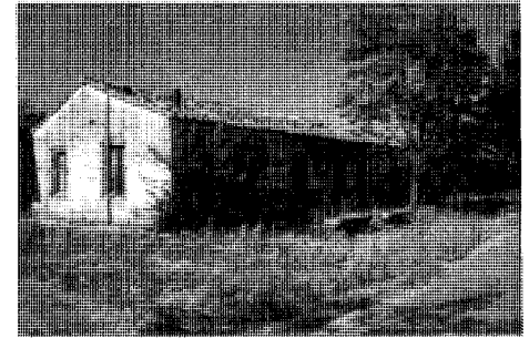
Pabellón de alojamiento colectivo en el margen izquierdo de la carretera
