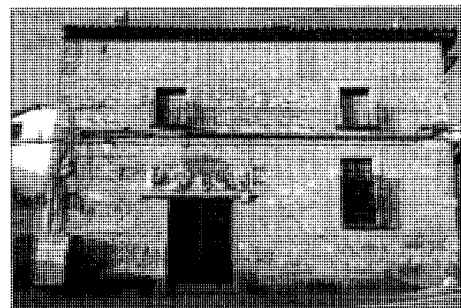
Calle Burgos, 3 c/v Montera. Fachada principal
