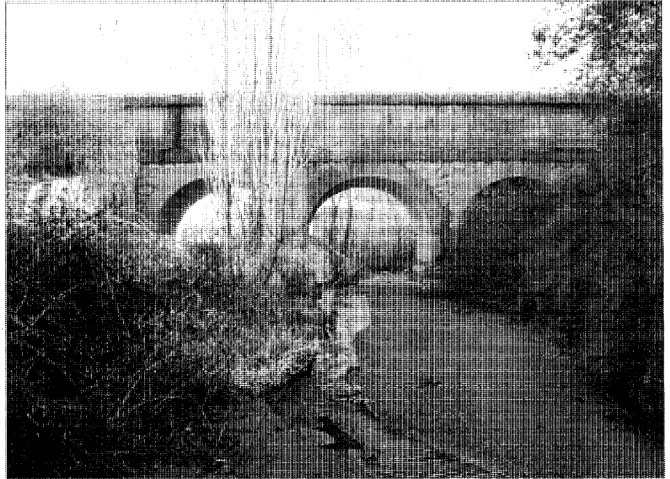
Acueducto del sifón del arroyo Sacedón. Vista general
