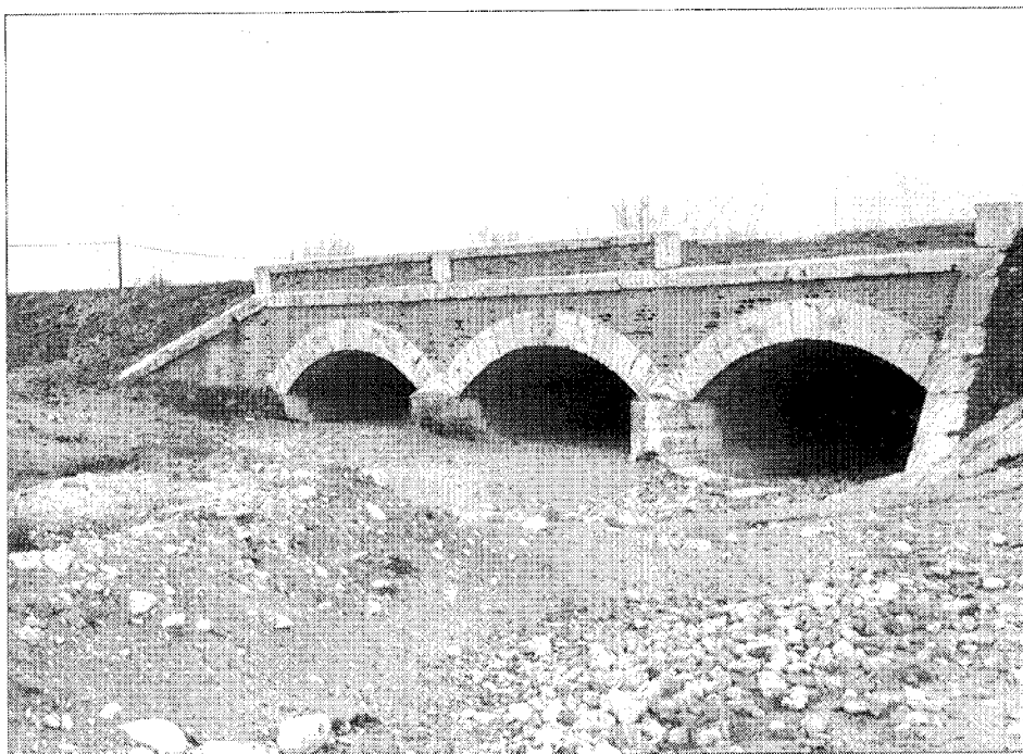
Puente de la carretera de Torrelaguna
