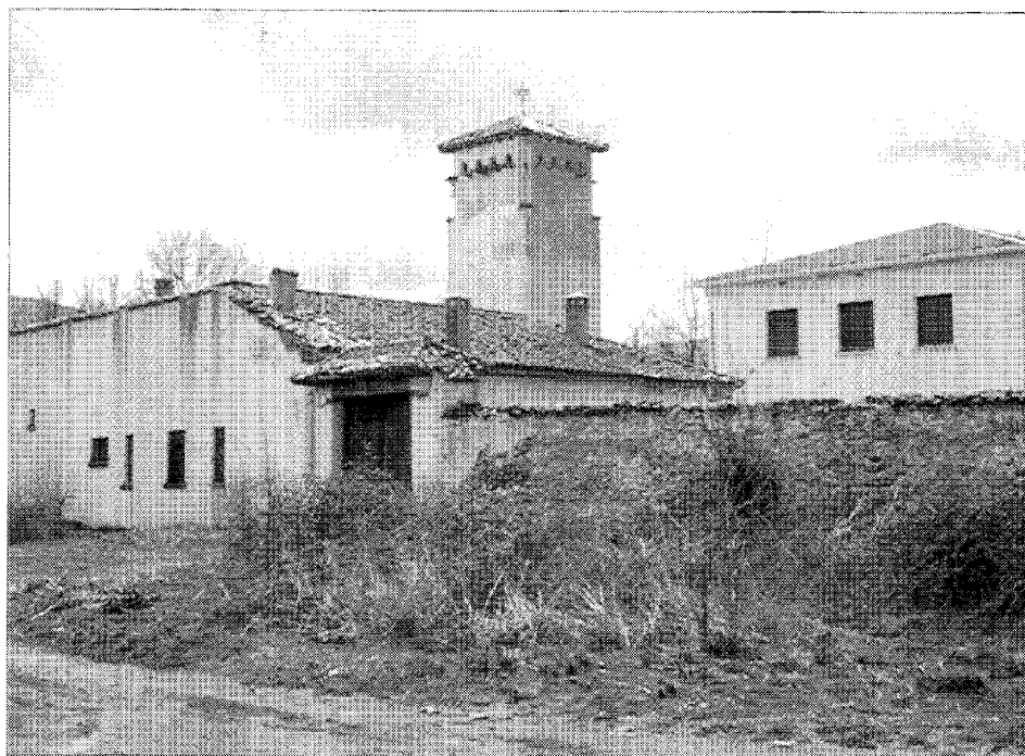
Vista general del conjunto
