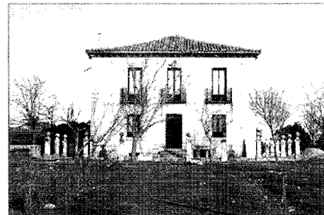
Fachada lateral de la casa de labor
