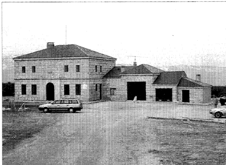
Albergue de la Morcuera. Fachada principal
