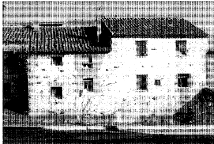
Traseras de la avenida de El Paular al arroyo Artiñuelo en Rascafría
