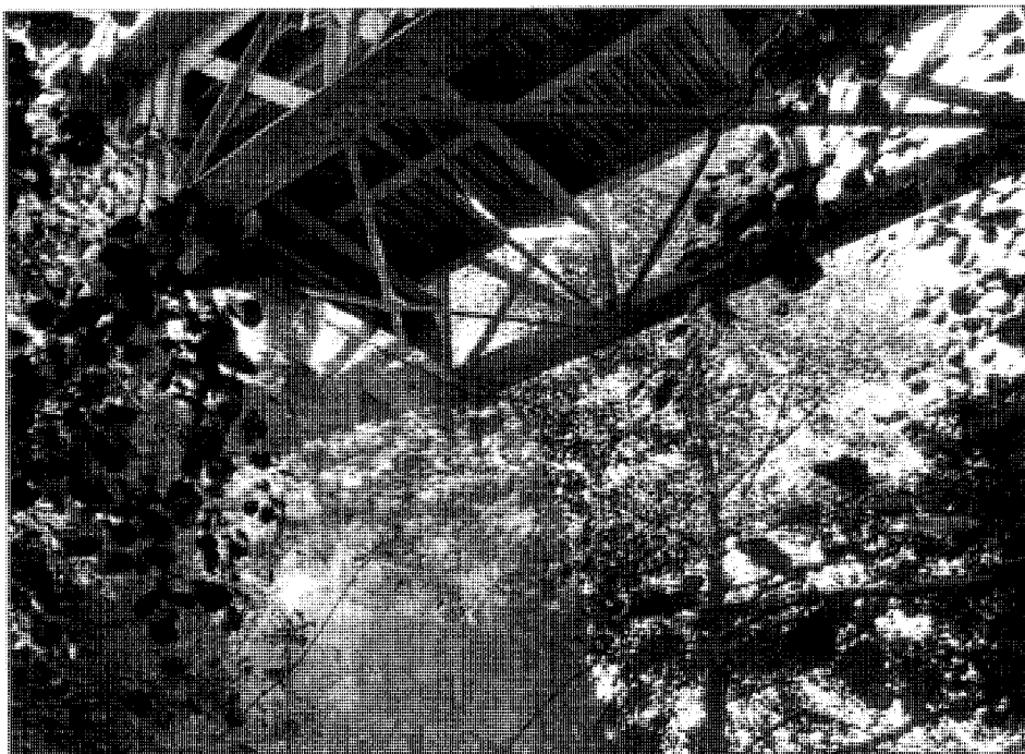
Vista inferior del arriostramiento y la estructura del tablero
