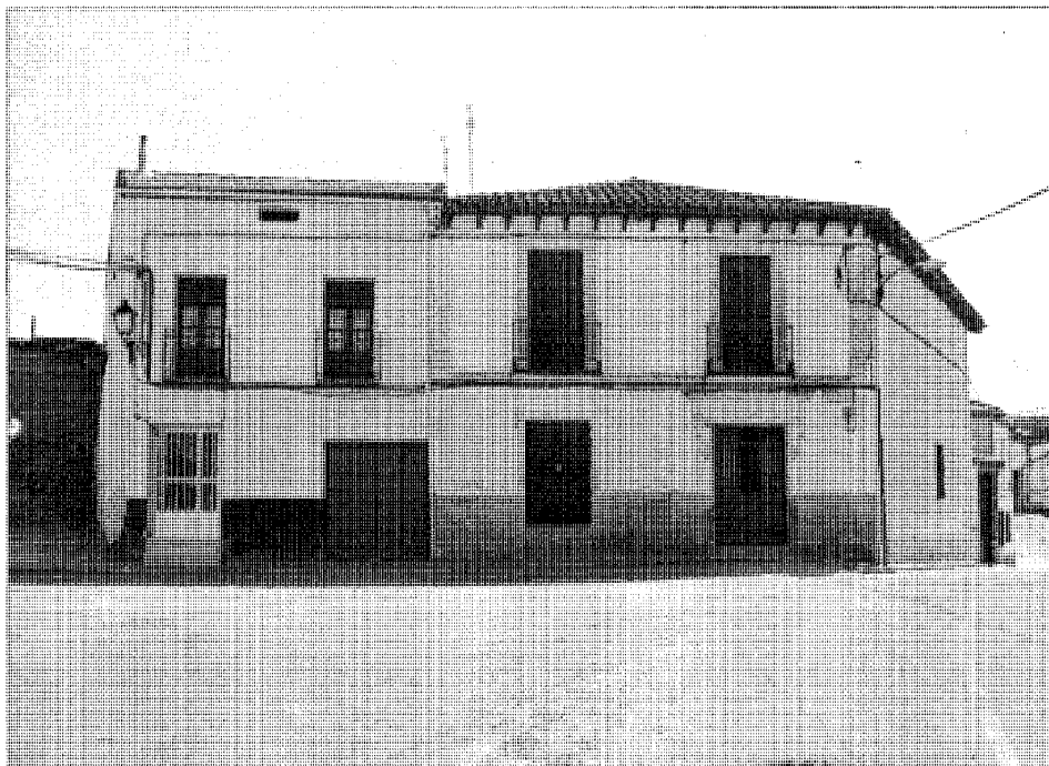
Vivienda situada en la plaza del General Franco
