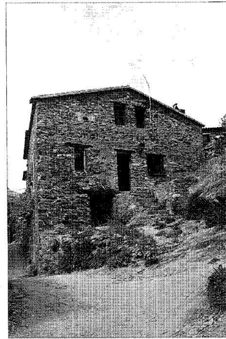
Edificación aislada, con cubierta a dos aguas
