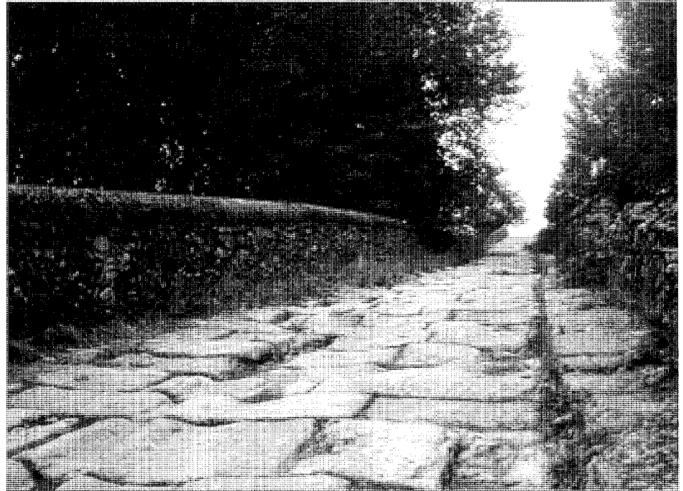
Vista del tablero
