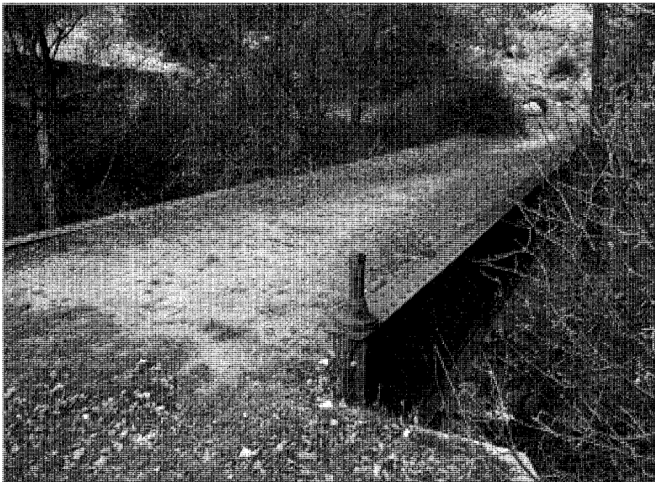
Puente de hierro sobre el rio Guadalix. Vista general
