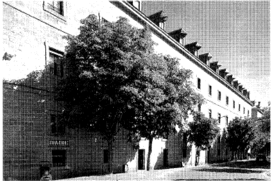
Fachada a la Lonja.. Fot. José Rodríguez Ablanedo.
