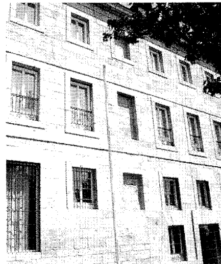
Detalle de la fachada en el encuentro de la fábrica original y la ampliación. Fot. Miguel Lasso de la Vega.
