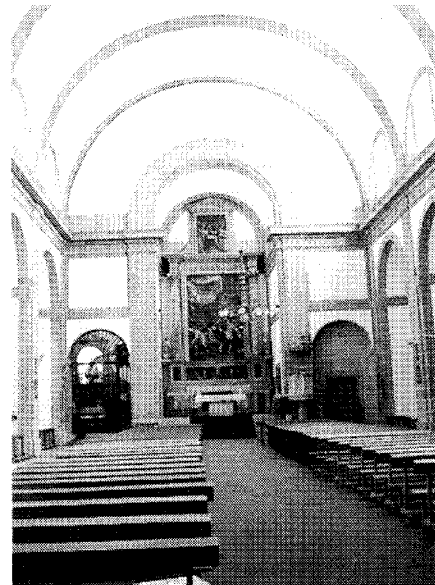
Interior desde los pies. Fot. Pilar Martín-Serrano.
