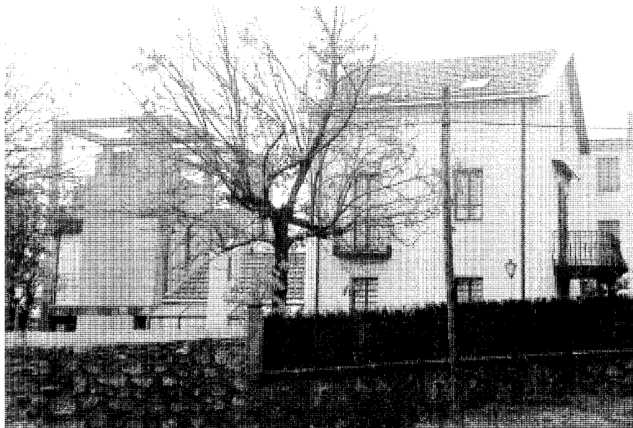
Vista general del Edificio. Fot. de los autores.
