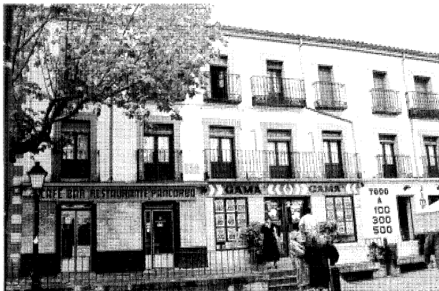
Manzana de vivienda urbana en la plaza Maximino Heras Cotillo. Fot. Pilar Martín-Serrano.
