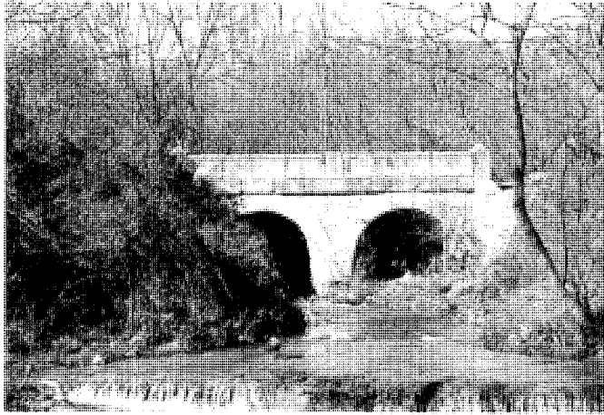
Puente siglo XIX (reconstruido). Fot. Pilar Martín-Serrano.
