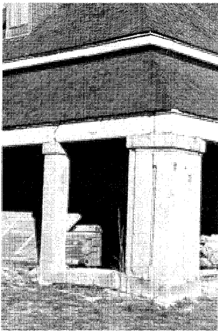
Detalle de la resolución de la esquina. Fot. Pilar Martín-Serrano.
