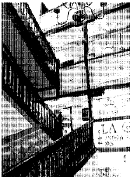
Detalle de escalera. Fot. Miguel Lasso de la Vega.
