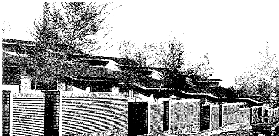
Vista de conjunto. Fot. Revista Arquitectura.
