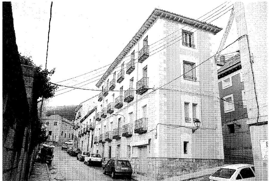
Casa en C/ Gobernador, nº 5. Fot. OCRE.
