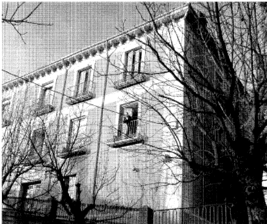
Detalle de fachada a la c/ Floridablanca. Fot. José Alberto Burgués.
