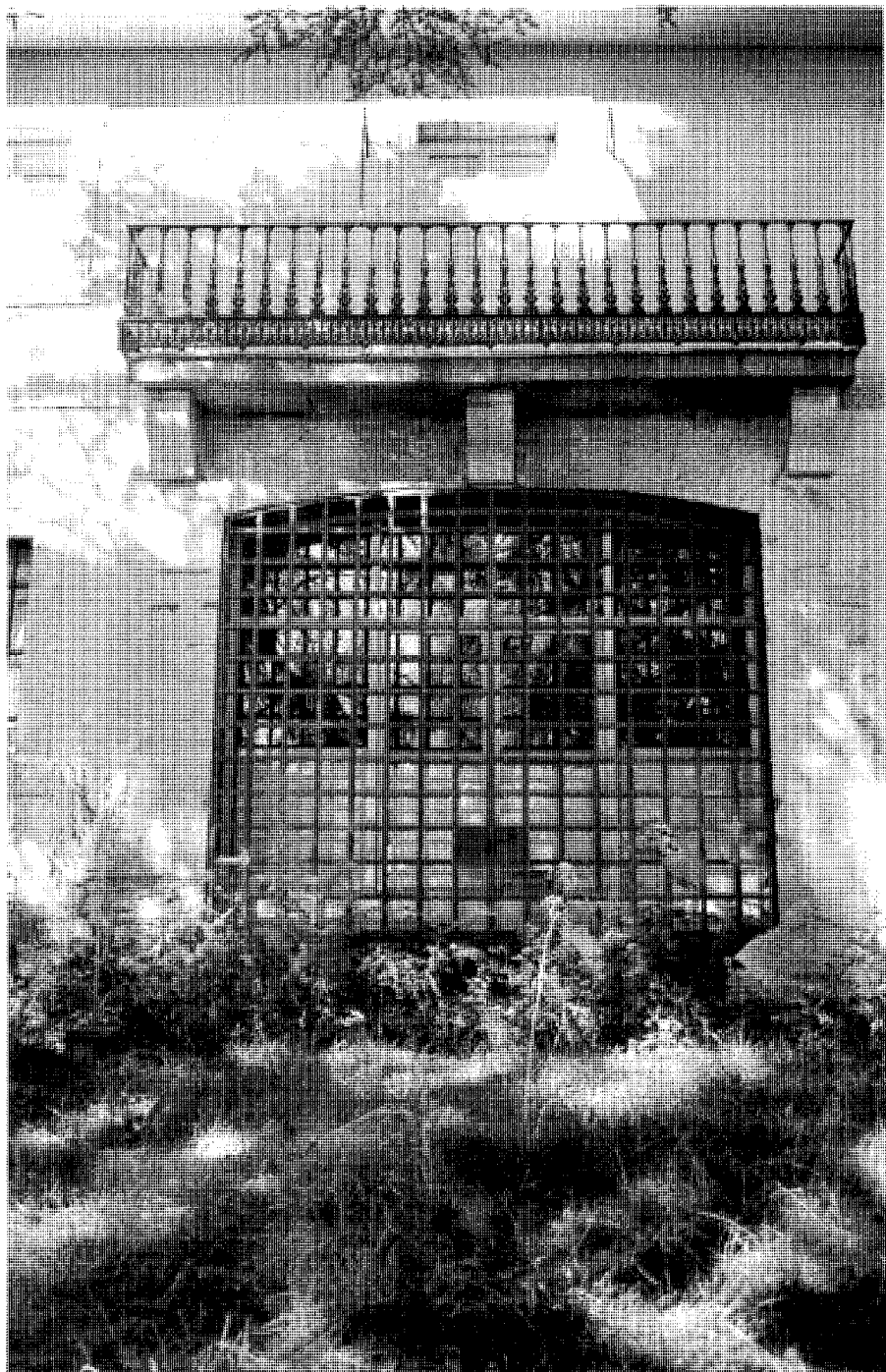
Detalle de acceso. Fot. José Alberto Burgués.
