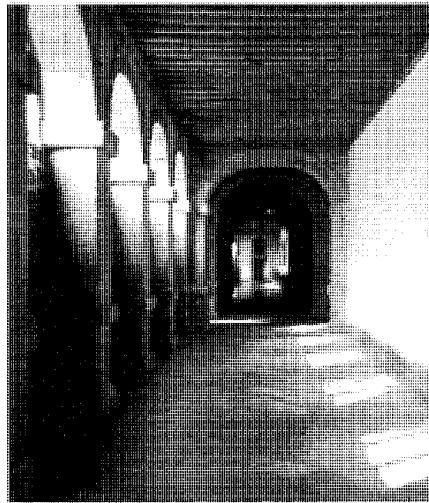
Claustro menor del convento. Piso superior. Fot. Pilar Martín-Serrano.
