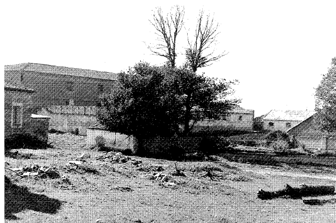
Finca de Zarzuela del Monte, recogida por las Relaciones de Felipe II. Fotos, Jose Ablanado s/ Información... de edificios y elementos del medio rural en el ámbito de la Comunidad de Madrid, 1986.
