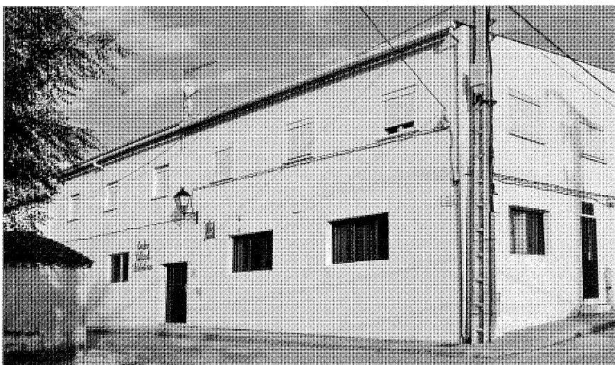
Nuevos equipamientos en Valdeolmos. Depósito de agua y Casa de la Cultura. Fotos, Jose Ablanedo, 2007 y Félix Cabrero, 2005.
