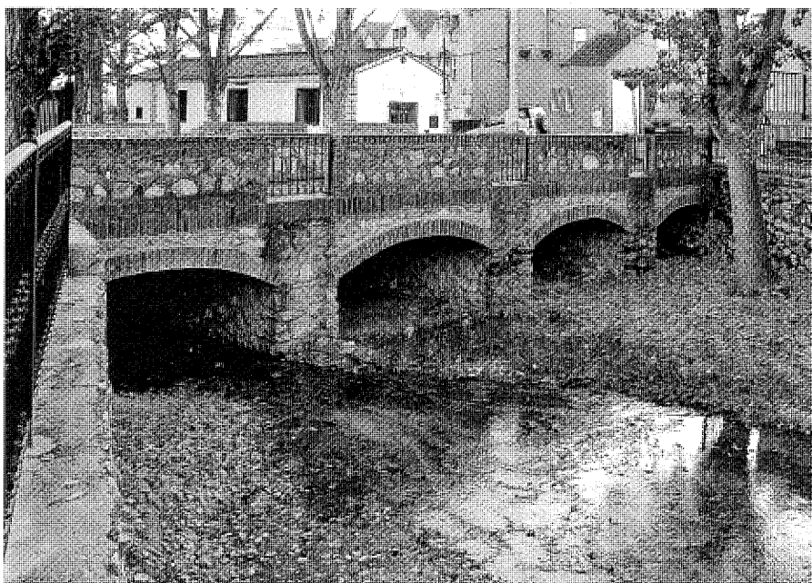
Puente del arroyo de la Vega, alzado septentrional. Foto Vicente Patón.
