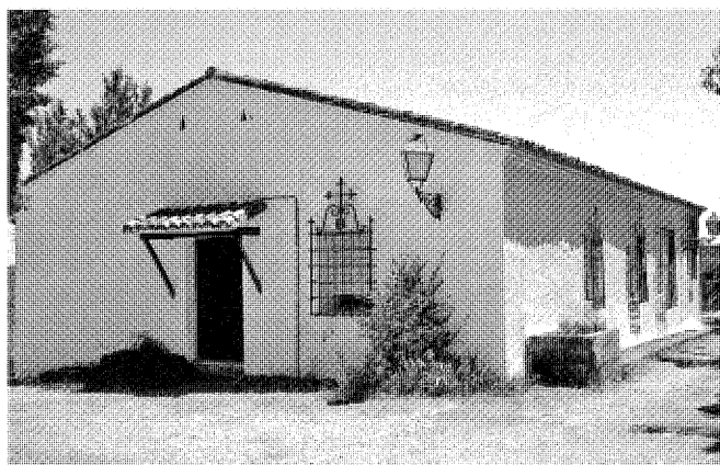
Casas de las Escaleras. Foto Gonzalo López-Muñiz.
