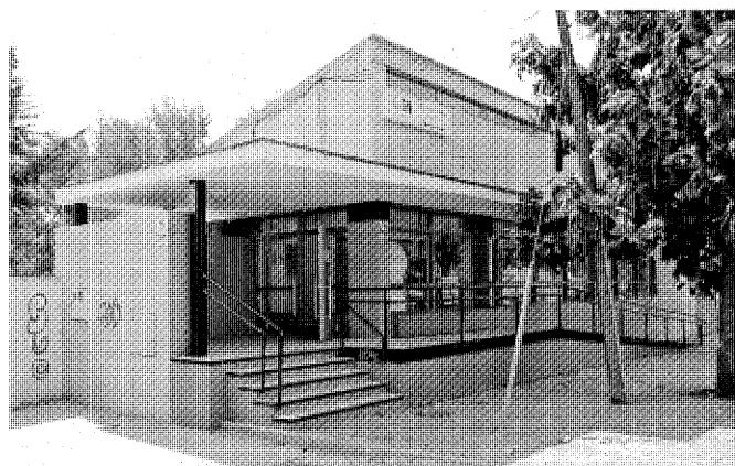
Consultorio de Alalpardo. Detalle de la fachada a la carretera. Foto, Jose Ablanedo, 2007.
