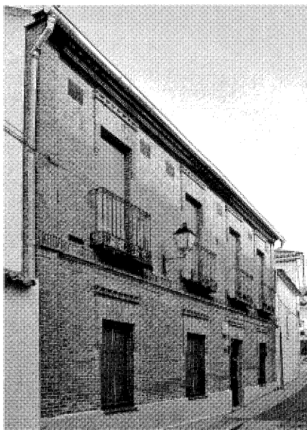
Vivienda urbana en la calle de Alcalá, nº 2. Foto Vicente Patón.
