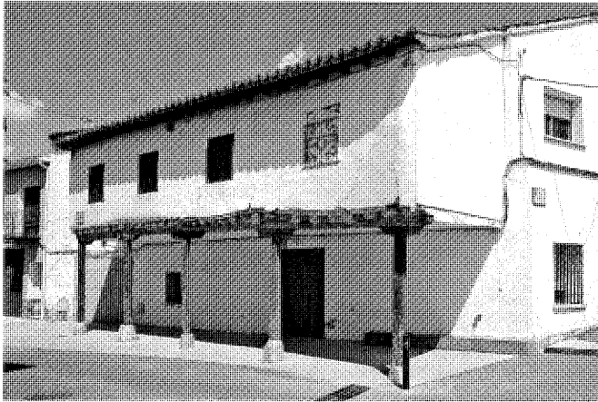
Vivienda de la calle Antonio González, 3. Foto Actividades y Servicios Fotográficos.
