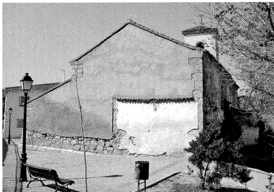
Vista del ábside tras la demolición. Foto Enrique Krahe.
