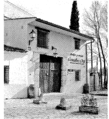
Bodega-enoteca junto a la Fuente Nueva, 2007. Foto Enrique Krahe.
