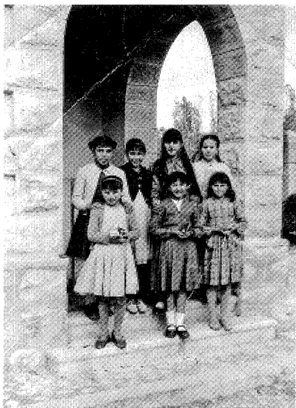
Detalle de soportal de acceso a las casas de maestros, 1955. http://www.villardelolmo.es
