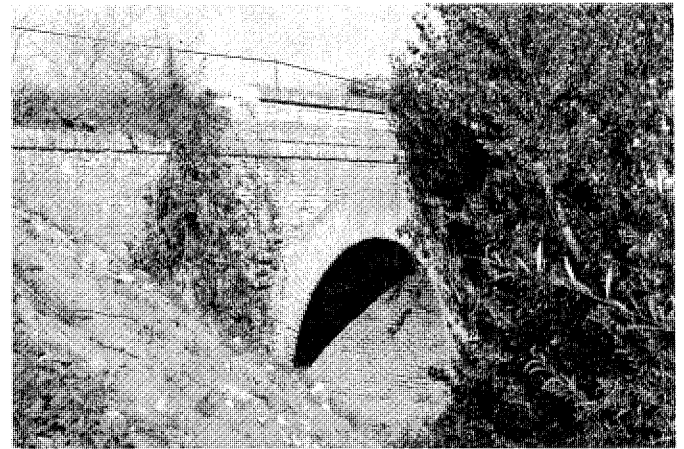
Puente de ladrillo sobre el arroyo del Casar. Foto, Jose Ablanedo s/ Información... del medio rural en el ámbito de la Comunidad de Madrid, 1986.
