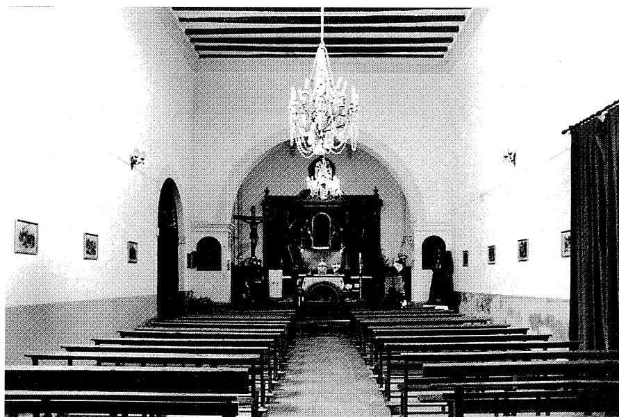
La nave antes de la restauración, 1997. Foto Vicente Patón.
