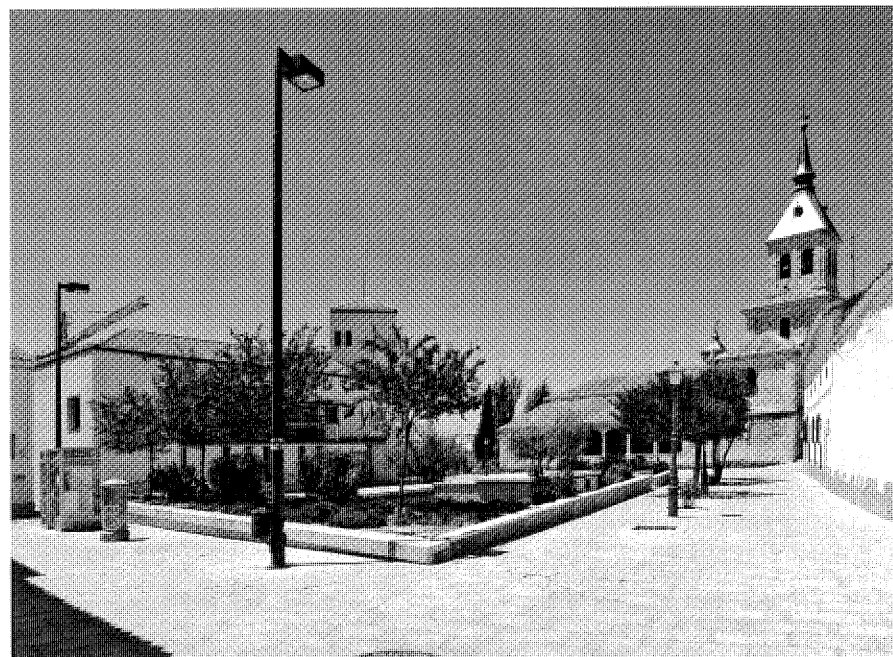
Vista de la plaza del Sol hacia la iglesia y ayuntamiento.
