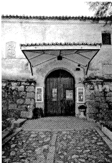
Vista del acceso.
