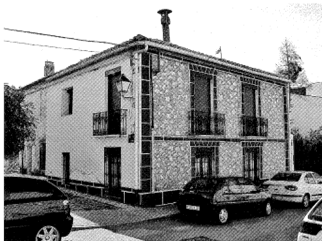
Vivienda urbano-rural en la calle de Alcalá, nº 39. Foto Vicente Patón.
