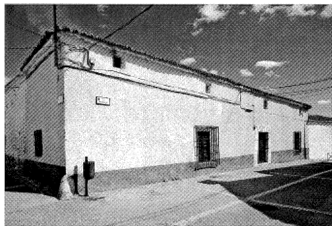
Vivienda en la c/ Peñuelas, 14.
