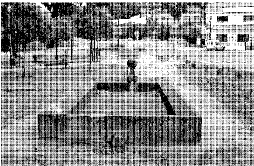
El lavadero con la fuente-abrevadero al fondo, 2007. Foto Enrique Krahe.
