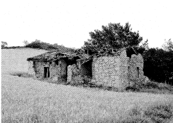
Vivienda con cubrición. Lote 8. Foto Enrique Krahe.
