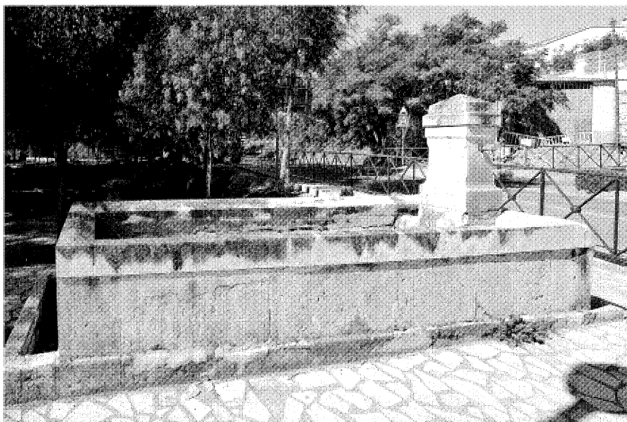
La fuente-lavadero en su entorno.
