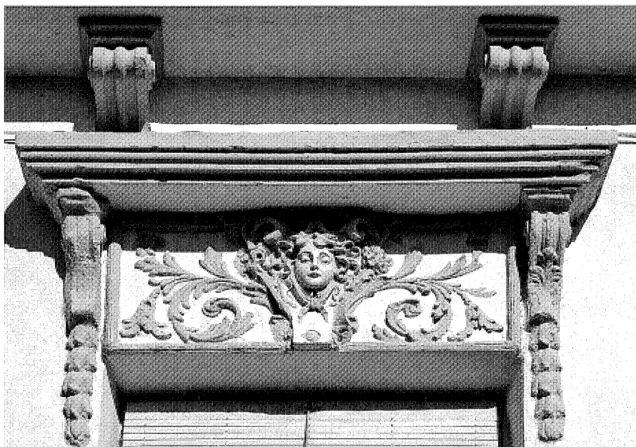
Detalle de las ventanas superiores en la calle Antonio González, 8. Foto Gonzalo López-Muñiz.
