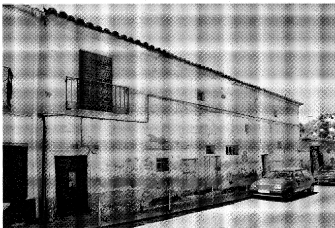
Vivienda en calle Real, 5.
