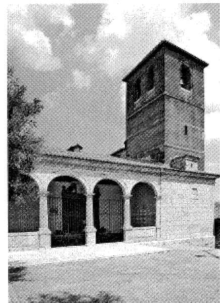
Vista general. Alzado Sur. Foto Actividades y Servicios Fotográficos.
