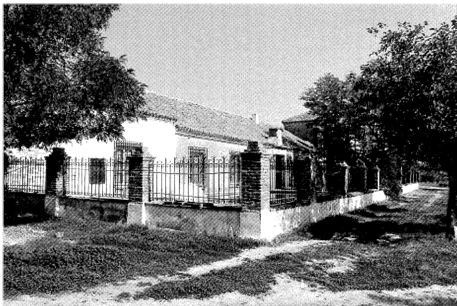
Casa Palacio. Fachada de acceso. Foto, Jose Ablanado s/ Información, clasificación y normativas de edificios y elementos del medio rural en el ámbito de la Comunidad de Madrid, 1986.
