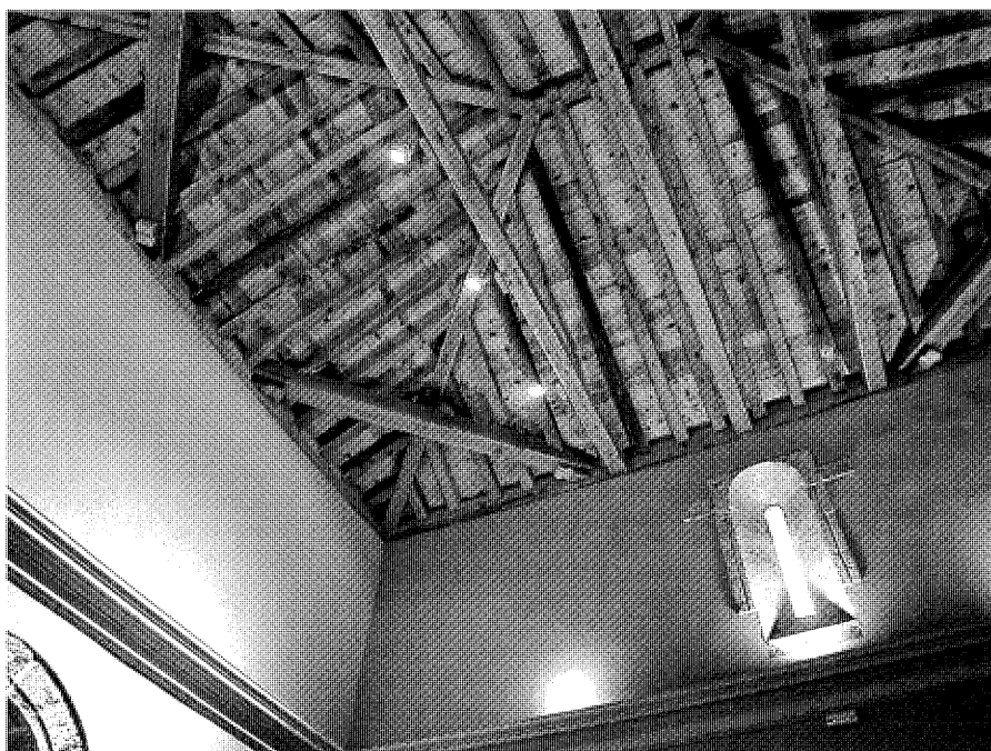
Interior. Foto Dirección General de Arquitectura y Rehabilitación, Consejería de Vivienda.
