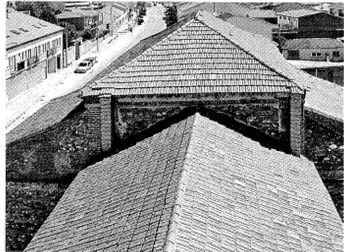
Detalle de cubiertas en el encuentro de la nave con el crucero tras la restauración. Foto cedida por el Arzobispado de Madrid-Alcalá, 2004.
