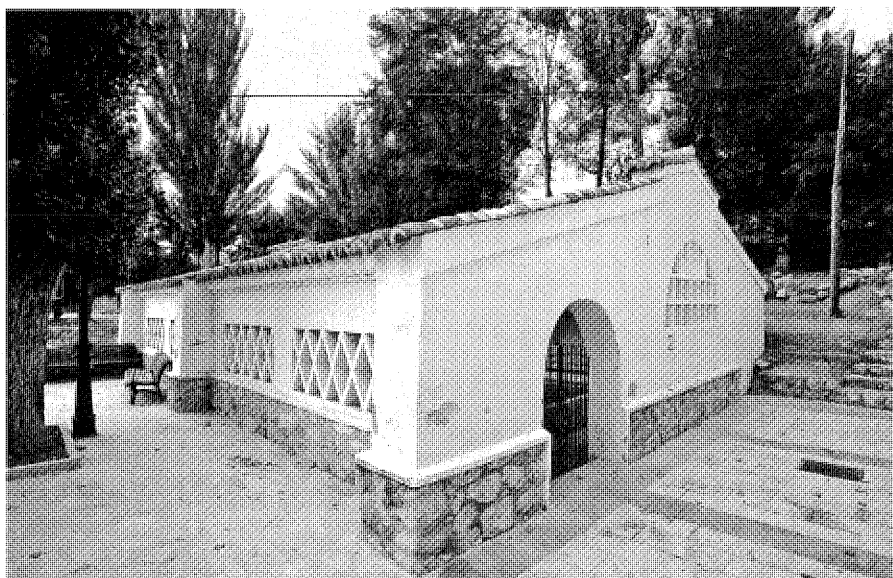
Acceso al lavadero a través del paramento sur.
