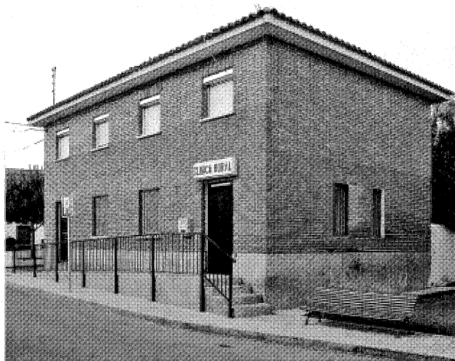
La Clínica Rural de 1966 en la calle de la Fuente. Foto Vicente Patón.
