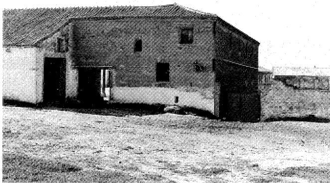
Conjunto principal. Dependencias de servicio. Foto, Jose Ablanado s/ Información... del medio rural en el ámbito de la Comunidad de Madrid, 1986.
