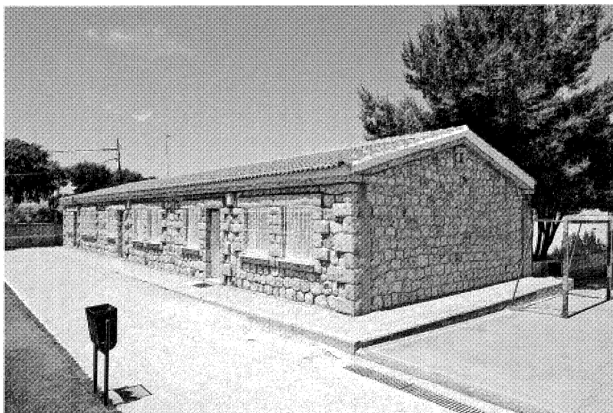
Pabellón de viviendas.
