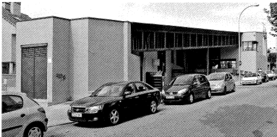
Fachada principal a la calle Alcalá. Foto, Jose Ablanedo, 2007.
