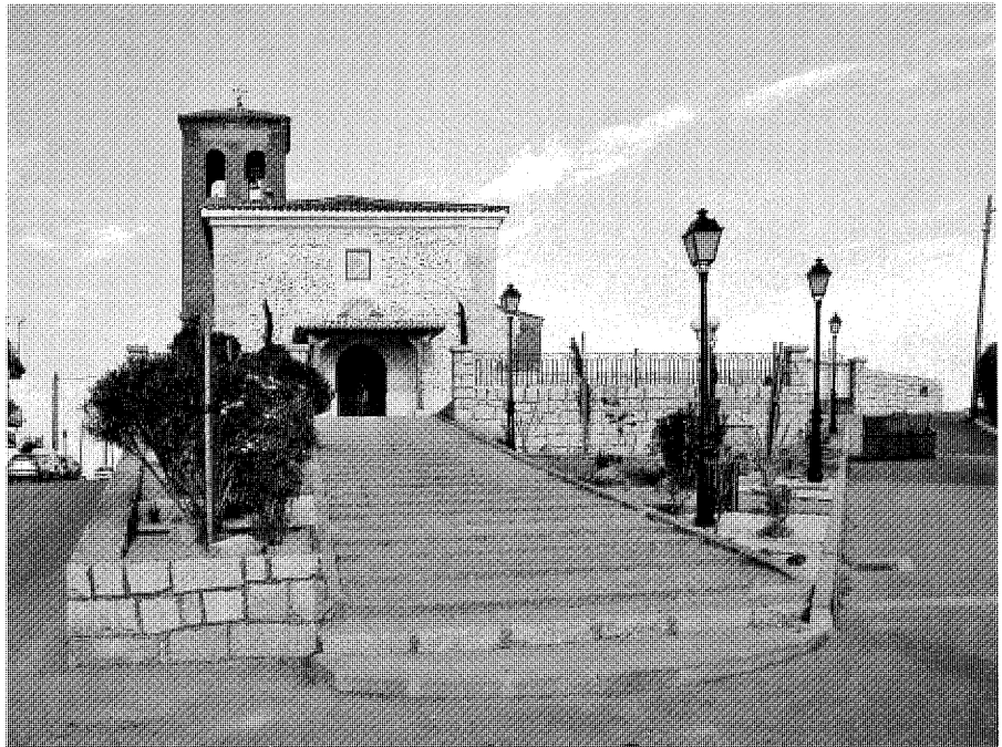
Vista frontal de la iglesia de Valdeolmos y su acceso principal. Foto, Félix Cabrero, 2005.
