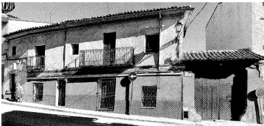
Vivienda en la calle Mayor, nºs 7 y 9. Foto Vicente Patón.
