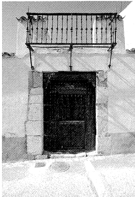
Detalle de portal en la c/ Peñuelas, 11.
