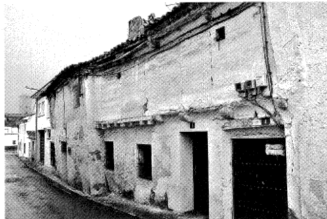
Viviendas en calle Carnicería, 6 y 8. Foto Gonzalo López-Muñiz.
