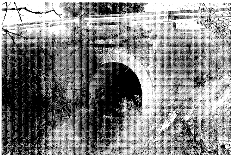
Puente del arroyo de la Cueva, alzado meridional. Foto Actividades y Servicios Fotográficos, S.A.
