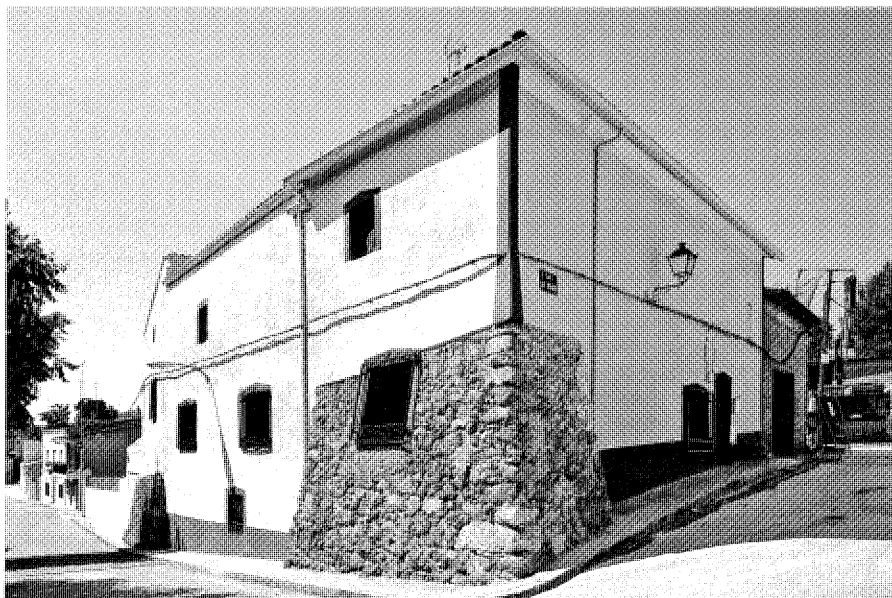
Calle Tercia c/v calle de la Fuente.
