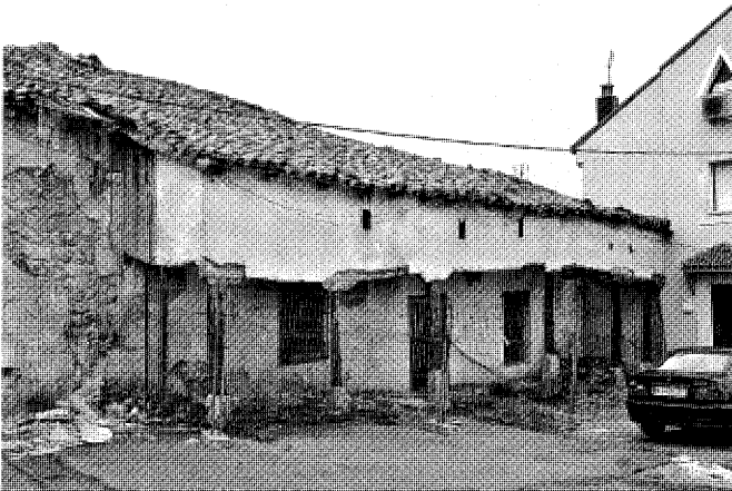
Vivienda de la Plaza de la Cruz del Pradillo, 4 (derruida). Foto Gonzalo López-Muñiz.
