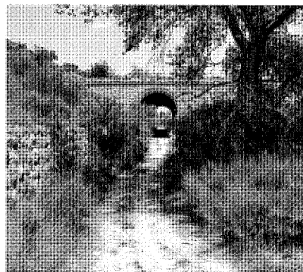
Túnel del Quemado 2. Foto Enrique Krahe.
