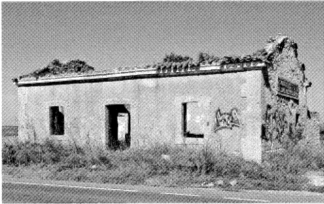
Casa de peones camineros en el km 13,400 de la M-209.
