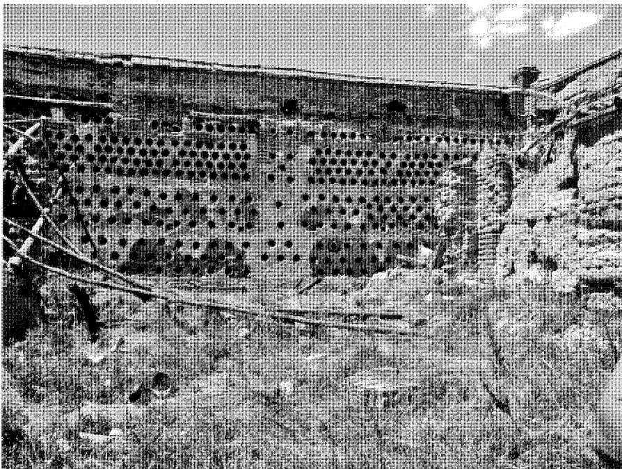
Detalle del patio oriental con los nidales cilíndricos de arcilla. Foto Vicente Patón.
