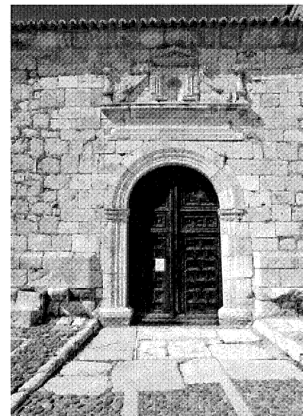
Portada en el muro meridional.
