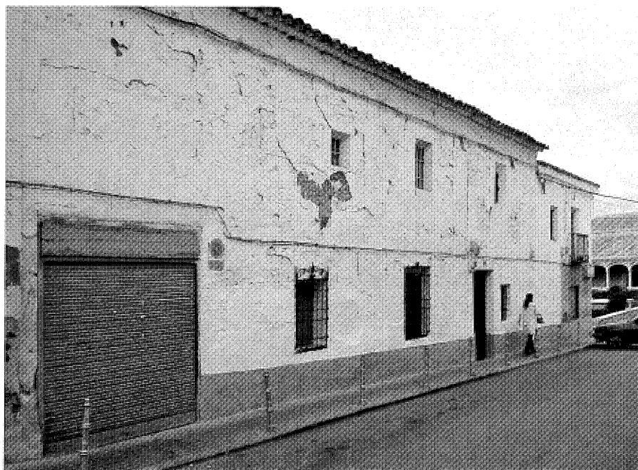
Vivienda en la calle Mayor, 2. Foto Ángel Cordero.
