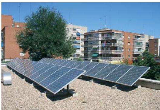
En ambos edificios, la orientación de los paneles fotovoltaicos es 20° SO que, aunque no maximiza la radiación solar incidente, sí permite una mejor integración de la instalación en el edificio.
