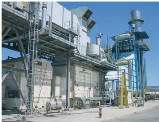
Además, esta producción se hace asegurando el máximo aprovechamiento eléctrico y térmico, puesto que se ha seleccionado la turbina de mayor rendimiento dentro de su gama de potencias, se han elegido las mejores condiciones posibles para el ciclo de vapor, se produce agua caliente con calor de cola de caldera para sustituir consumos de vapor de la fábrica y se ha producido frío con el calor excedente.
