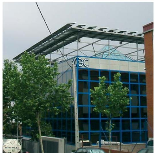
Los paneles fotovoltaicos, con 15° de inclinación y orientados al sur, están situados en la pérgola del edificio y la estructura de soporte es de acero galvanizado.
