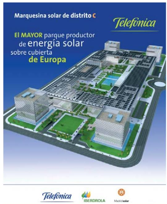
El parque se dotará con más de 16.600 paneles solares fotovoltaicos que se situarán sobre la marquesina que recorrerá todo el complejo de oficinas por encima de la cubierta de los edificios. Con más de un kilómetro de longitud, la marquesina tendrá una superficie de más de 57.000 metros cuadrados, de los que 21.000 estarán ocupados por paneles solares.
