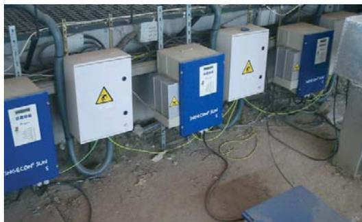
Se han utilizado inversores, modelo Ingecom 5, para transformar la corriente continua (DC) producida por los paneles en alterna (AC), que es enviada a la red eléctrica.
