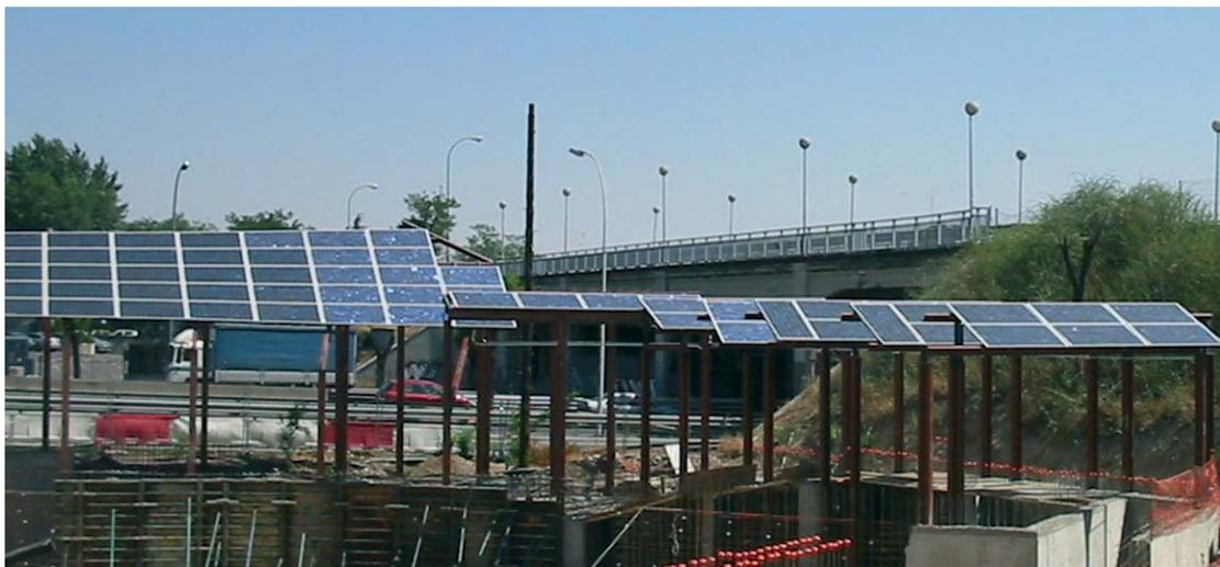
La climatización de la piscina se realiza a través de 6 colectores con una superficie total de captación de 12 m<sup>2</sup>. Estos colectores están situados en la misma pérgola en la que se encuentran los módulos fotovoltaicos.
