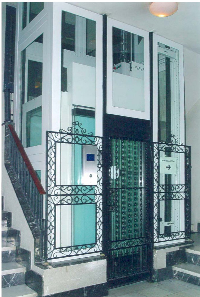
Foto 3. Ascensor remodelado, en el que se aprecia la incorporación de puertas en la cabina.
