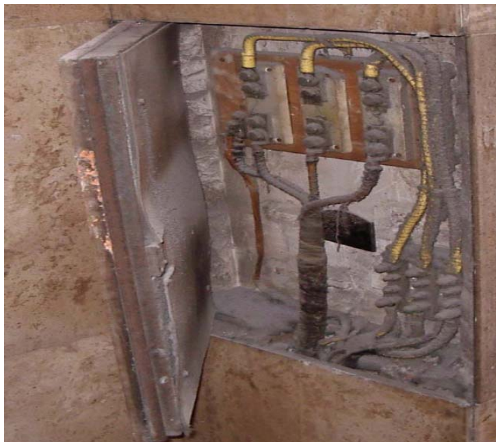
Figura 4. Línea general de alimentación.
