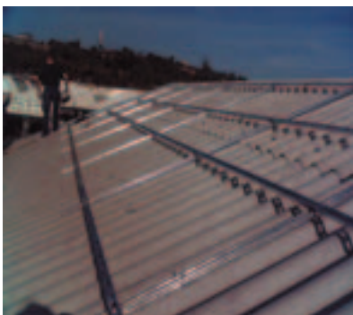
Foto 4. Estructura sobre tejado inclinado de uralita.
