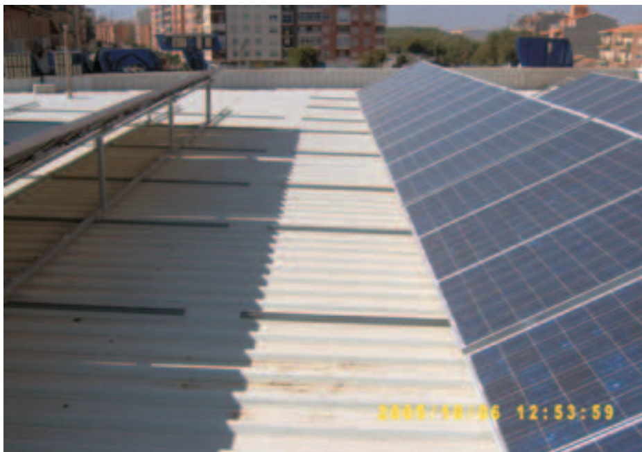
Foto 5. Estructura sobre tejado plano de uralita.
