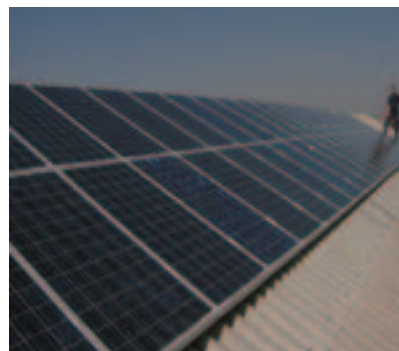
Foto 4. Estructura sobre tejado inclinado de uralita.
