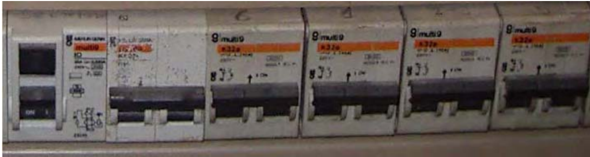
Figura 10. Pequeños interruptores automáticos (PIAs).
