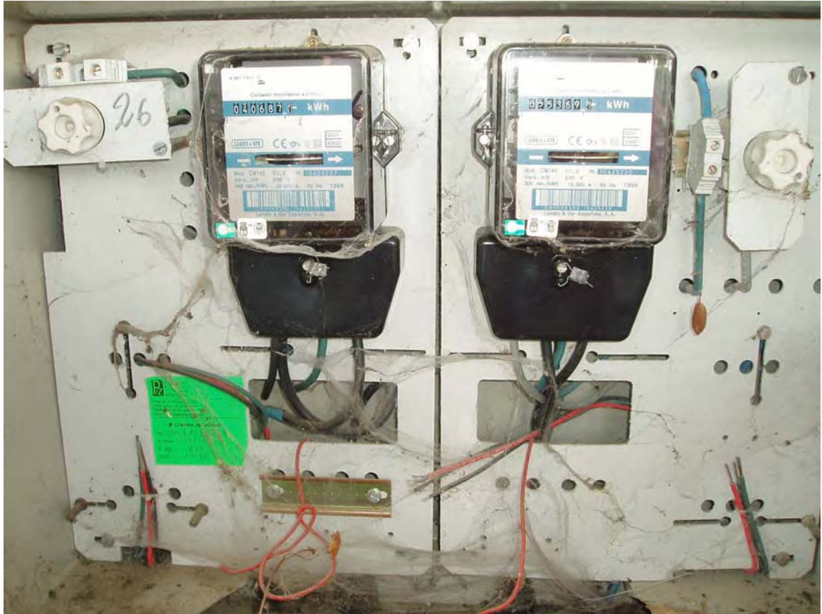
Figura 7. Detalle de contadores de inducción.
