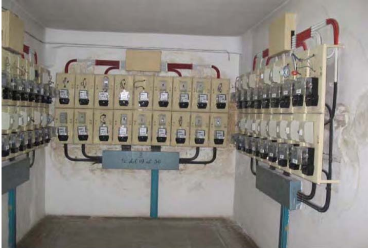
Figura 5. Centralización de contadores.
