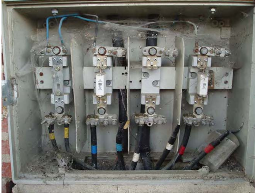
Figura 3. Caja general de protección.
