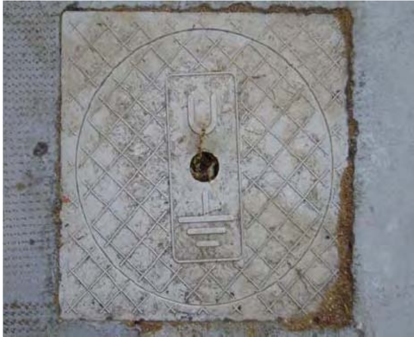
Figura 15. Toma de tierra.
