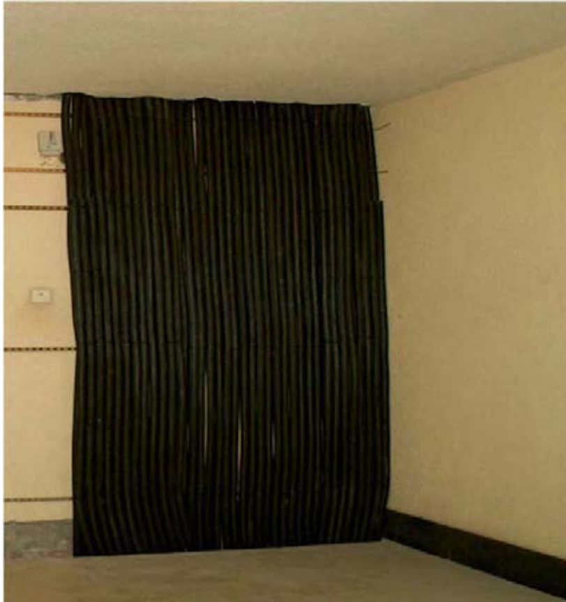
Figura 8. Canalizaciones de derivaciones individuales.
