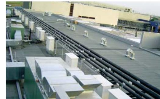
Dadas las características, extensión y tipología de la instalación, la red de distribución está conformada por tubería pre-aislada por las ventajas de ésta frente a tuberías aisladas por el método tradicional.
