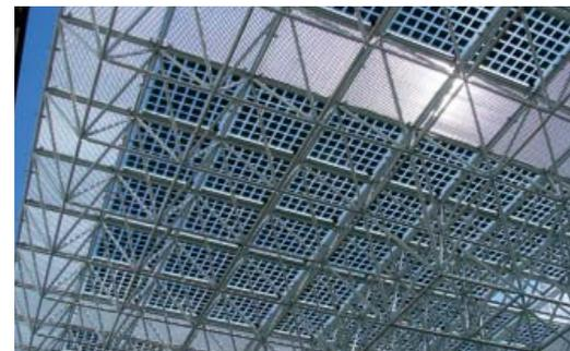
Los módulos fotovoltaicos producen corriente continua que se envía a unos inversores en la planta técnica, que la convierten en alterna antes de verterla a la red.
