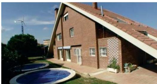
**Instalación de climatización de vivienda unifamiliar con captadores solares térmicos y máquina de absorción ClimateWell 10**
