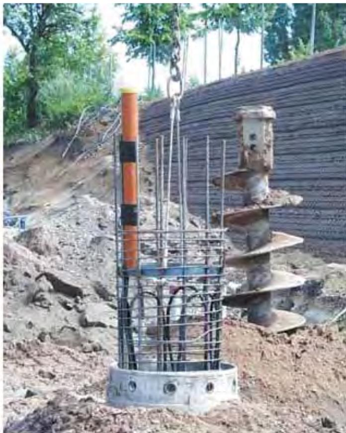
Foto 4.7. Armadura de pilote con captadores antes y después de su colocación.
