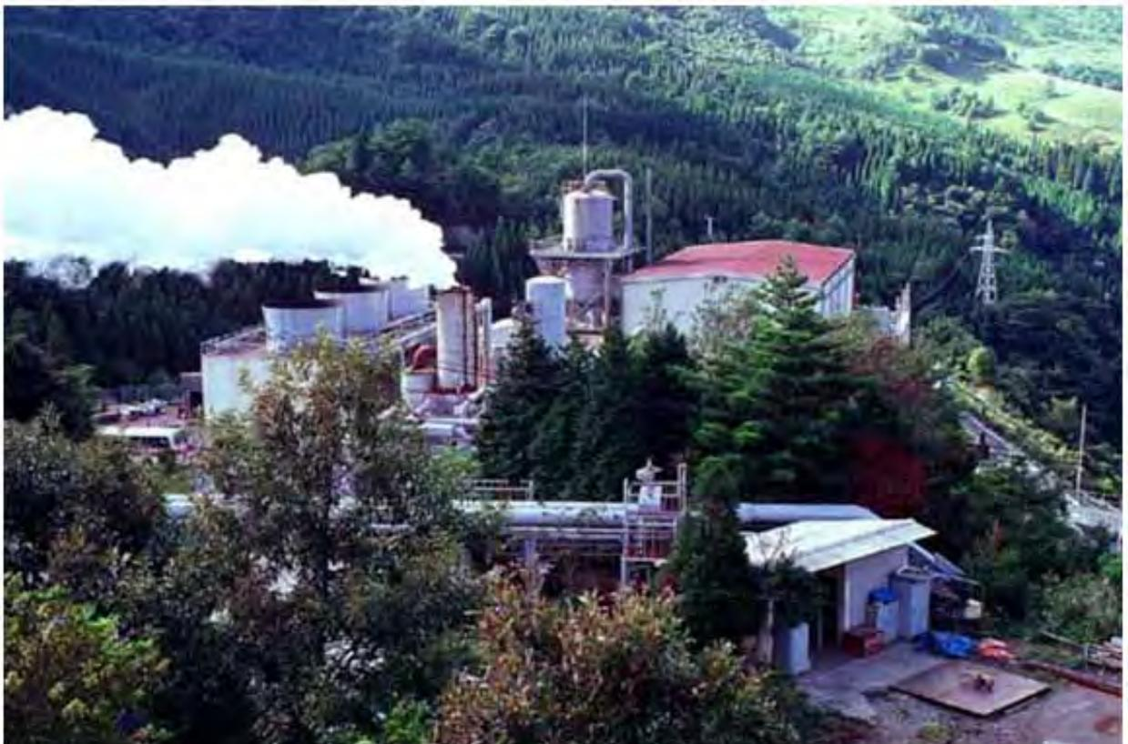
Foto 6.1. Planta de ciclo "flash" en Japón. El agua separada se reinyecta directamente al entorno del acuífero para no rebajar demasiado la temperatura del mismo.
