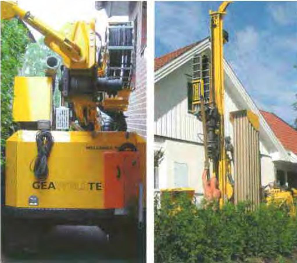
Foto 4.4. Perforación para sonda geotérmica al lado de una edificación.
