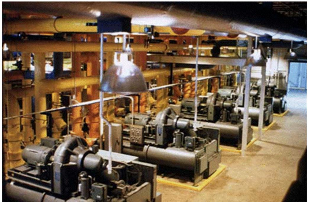
Foto 5.4. Sala de bombas de distribución de agua caliente a los puntos finales de entrega de calor. (Fuente: @2000 Geothermal Education Office).
