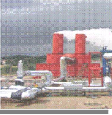
nados más arriba, se inyecta en la turbina en dos fases, al principio y en un punto intermedio, se obtendrá lo que se conoce como una central de doble "flash".
