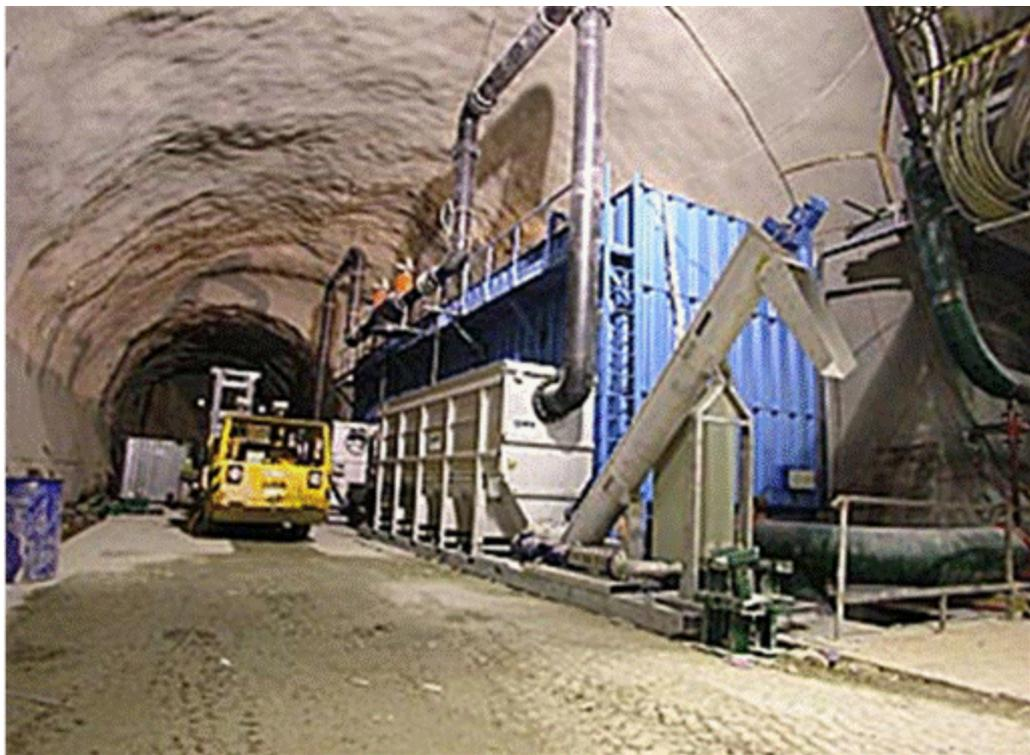
Foto 4.9. Galería con decantador y depósito para el agua subterránea drenada por el túnel de Gotthard (Suiza). (Fuente: *Site Geothermie-Perspectives de l'ADEME et du BRGM*).
