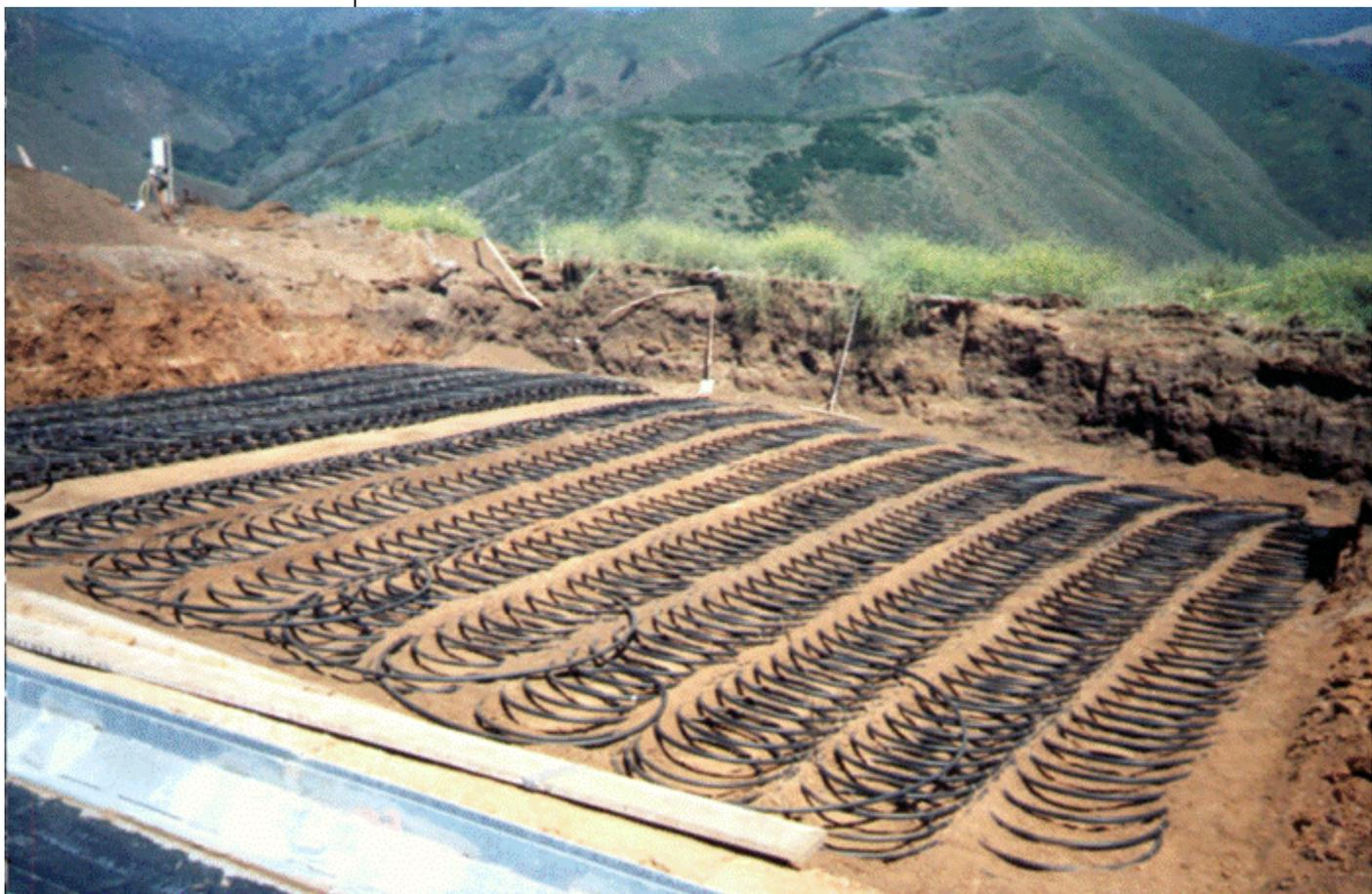
Foto 4.3. Tendido en espirales de tubos captadores horizontales. (Fuente: *Geothermal Heat Pump Consortium*).
