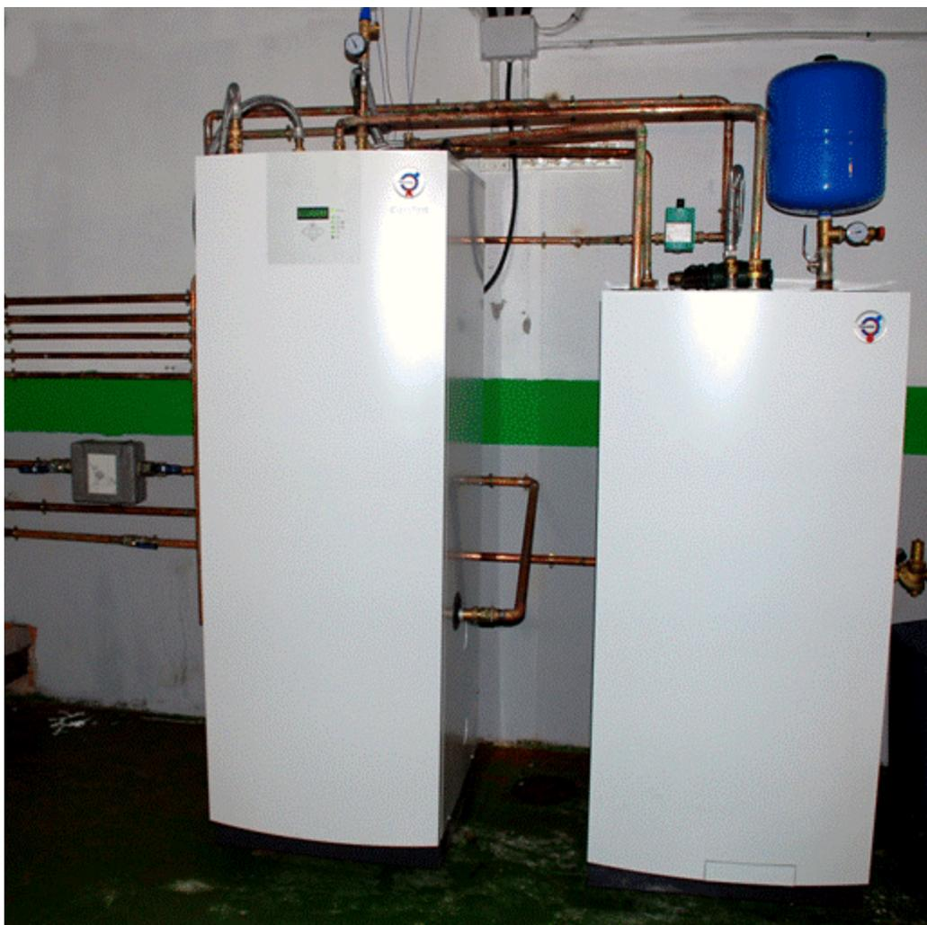
Foto 4.6. Conexión de tubos captadores a bomba de calor geotérmica en la sala de calderas de una vivienda. Salida de tuberías de cobre a aparatos distribuidores. (Fuente: *Girod Geotermia*).
