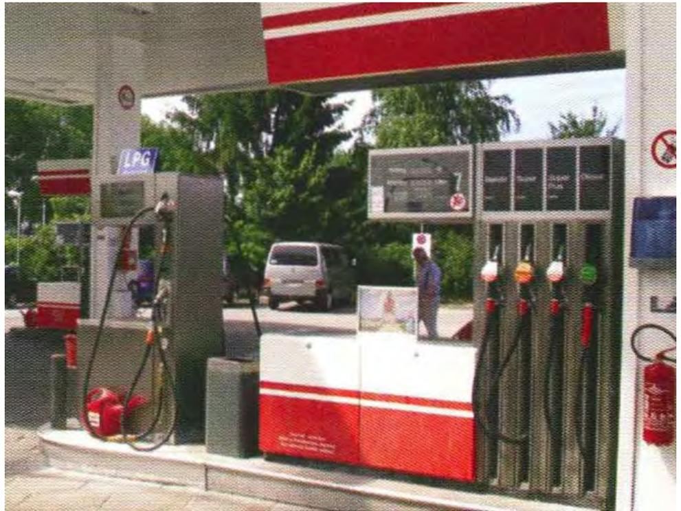
Foto 6.7. Surtidores de GLP y de otros combustibles en una estación de servicio.
