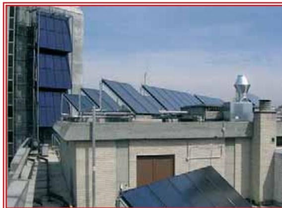
Foto 2: Instalación solar térmica para ACS.
