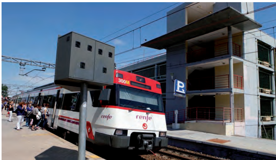
Aparcamiento de disuasión de pago en la estación de Majadahonda
