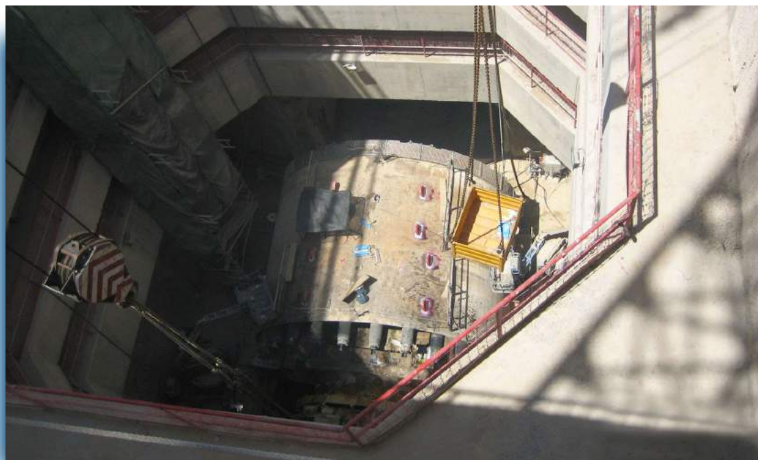
▲ Desmontaje y extracción tuneladora.
