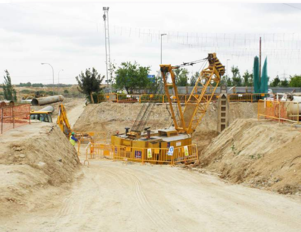
▲ Área delimitada para ejecución de pantallas bajo línea eléctrica aérea.
