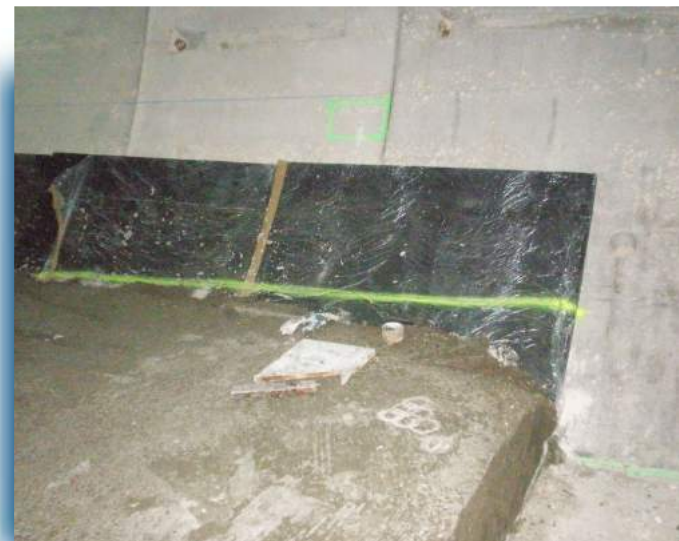
▲ Detalle de manta fonoabsorbente colocada.
