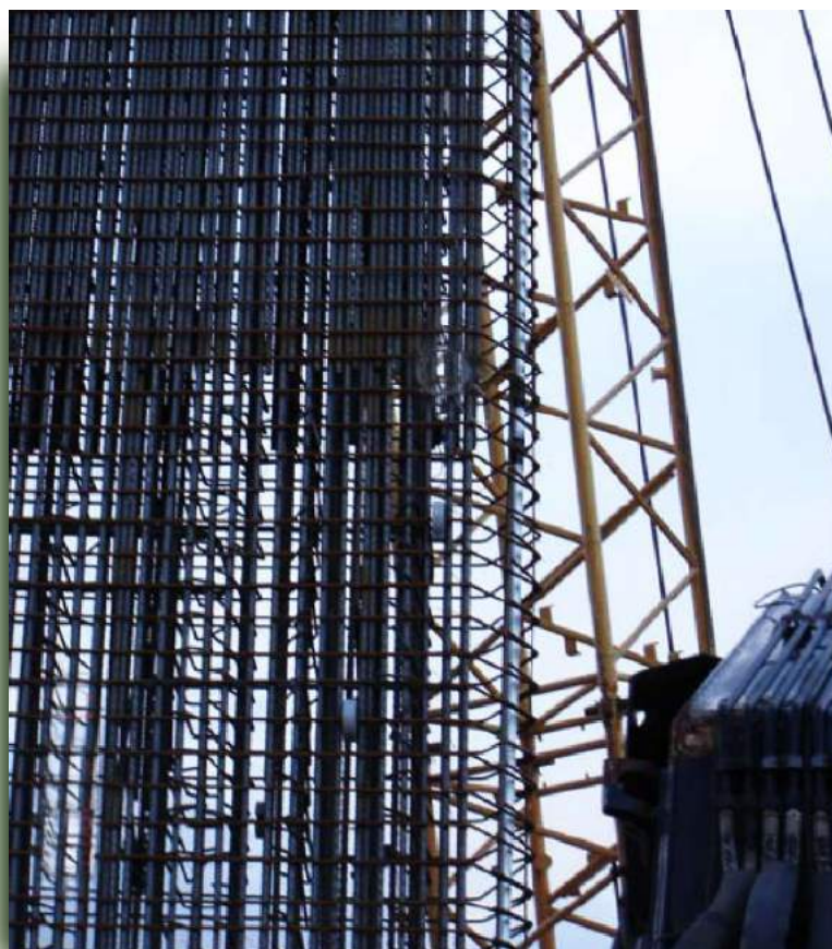
▲ Armadura de pantalla instrumentada (célula de presión total y tubería inclinométrica).
