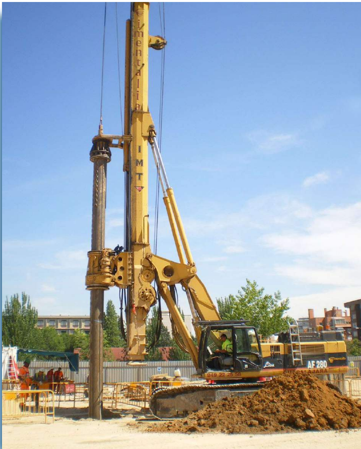
▲ Pilotes de Mortero en cabecero de estaciones (corralitos). Ejecución de columnas de mortero.
