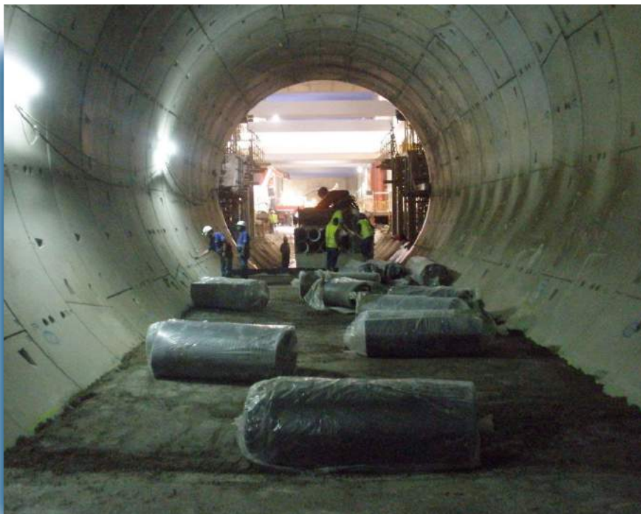
▲ Extendido de manta fonoabsorbente en túnel.
