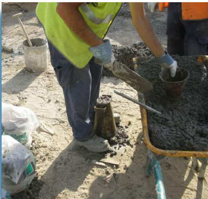
▲ Comprobación de la consistencia del hormigón.
