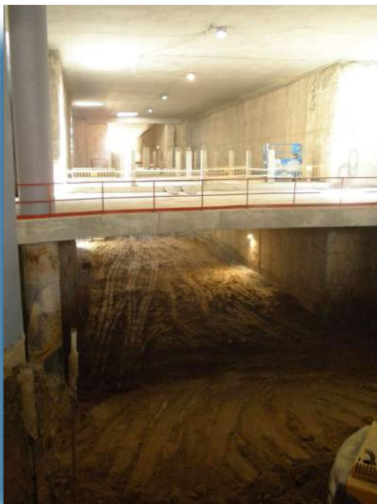
▲ Vaciado andén E-4.
