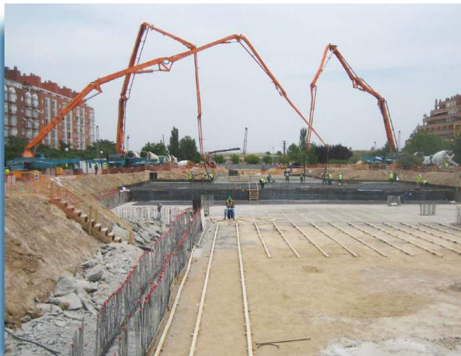
▲ Hormigonado losa cubierta E-4.
