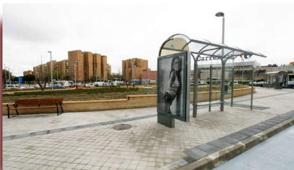
◀ Encaminamientos con losetas Podotáctiles.
