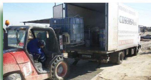
▲ A lo largo de la obra se han realizado trece retiradas de residuos peligrosos de los puntos limpios por gestor autorizado.
