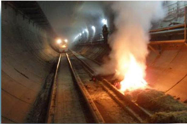
▲ Simulacro incendio túnel Fase I: Aviso de conato de incendio.
