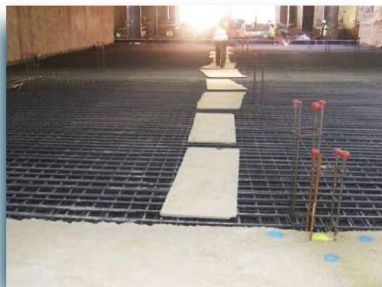
▲ Pasarela ligera para paso sobre armadura de losa de vestíbulo.
