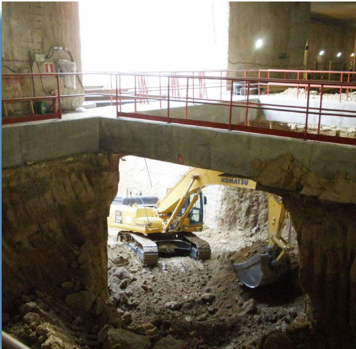
▲ Vaciado nivel andén E-3.
