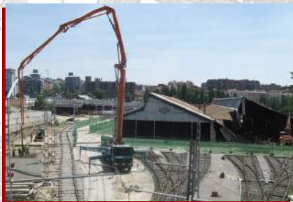
DEMOLICIÓN ANTIGUAS COCHERAS
