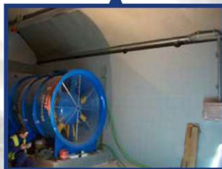
INSTALACIÓN VENTILADOR
