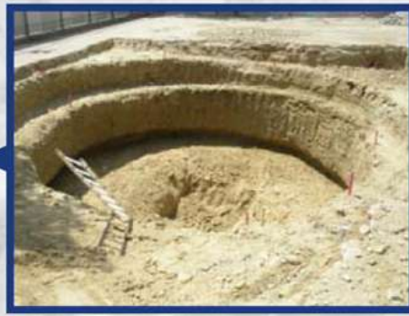
INICIO EJECUCIÓN POZOS
