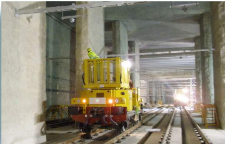
▲ Montaje de soportes para la instalación de catenaria mediante ferrocarril con castillete de elevación.
