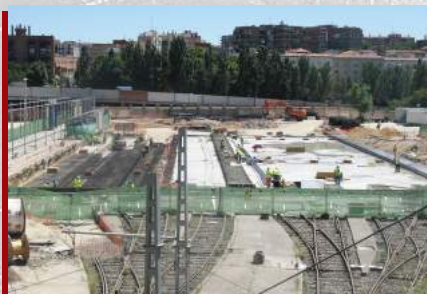
EJECUCIÓN CIMENTACIÓN Y LOSAS
