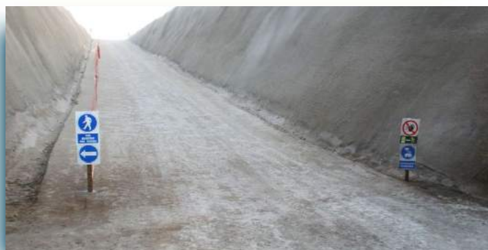
▲ Separación de circulación peatonal y vehículos mediante instalación de pasillos.
