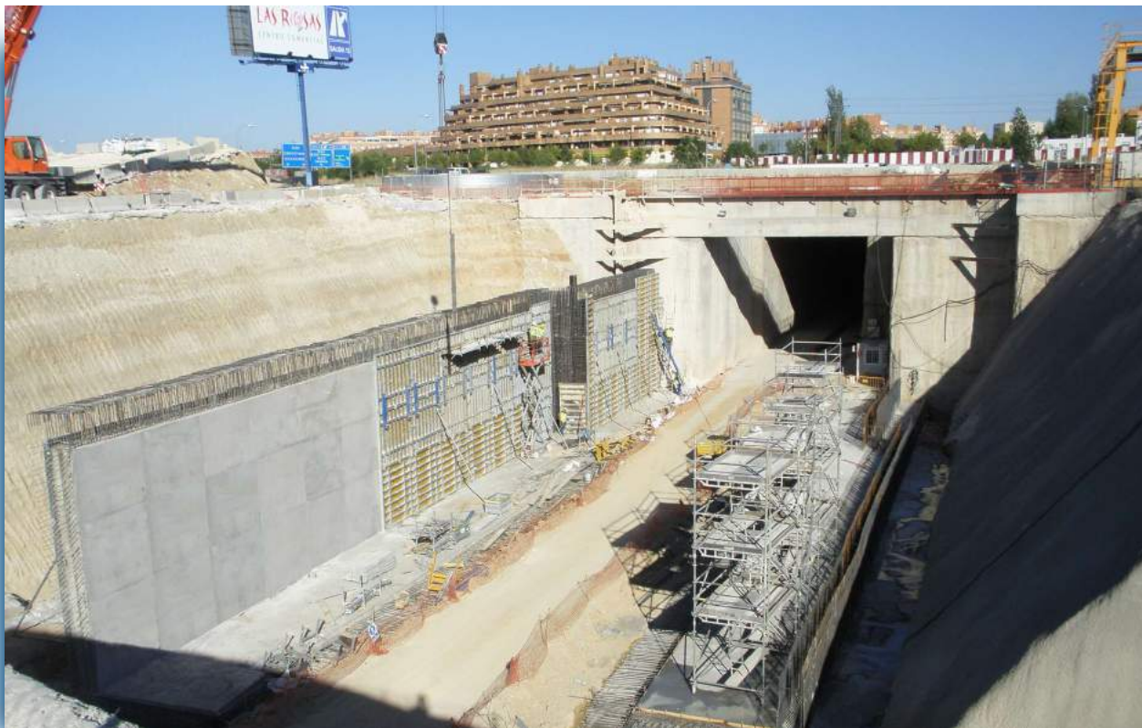
▲ Montaje de alzado de muros.
