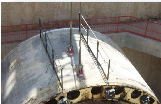
▲ Instalación previa de barandillas en cabeza de tuneladora para la ejecución posterior de trabajos en la misma. Las orejetas soldadas en obra son ensayadas (líquidos penetrantes) antes de su uso.
