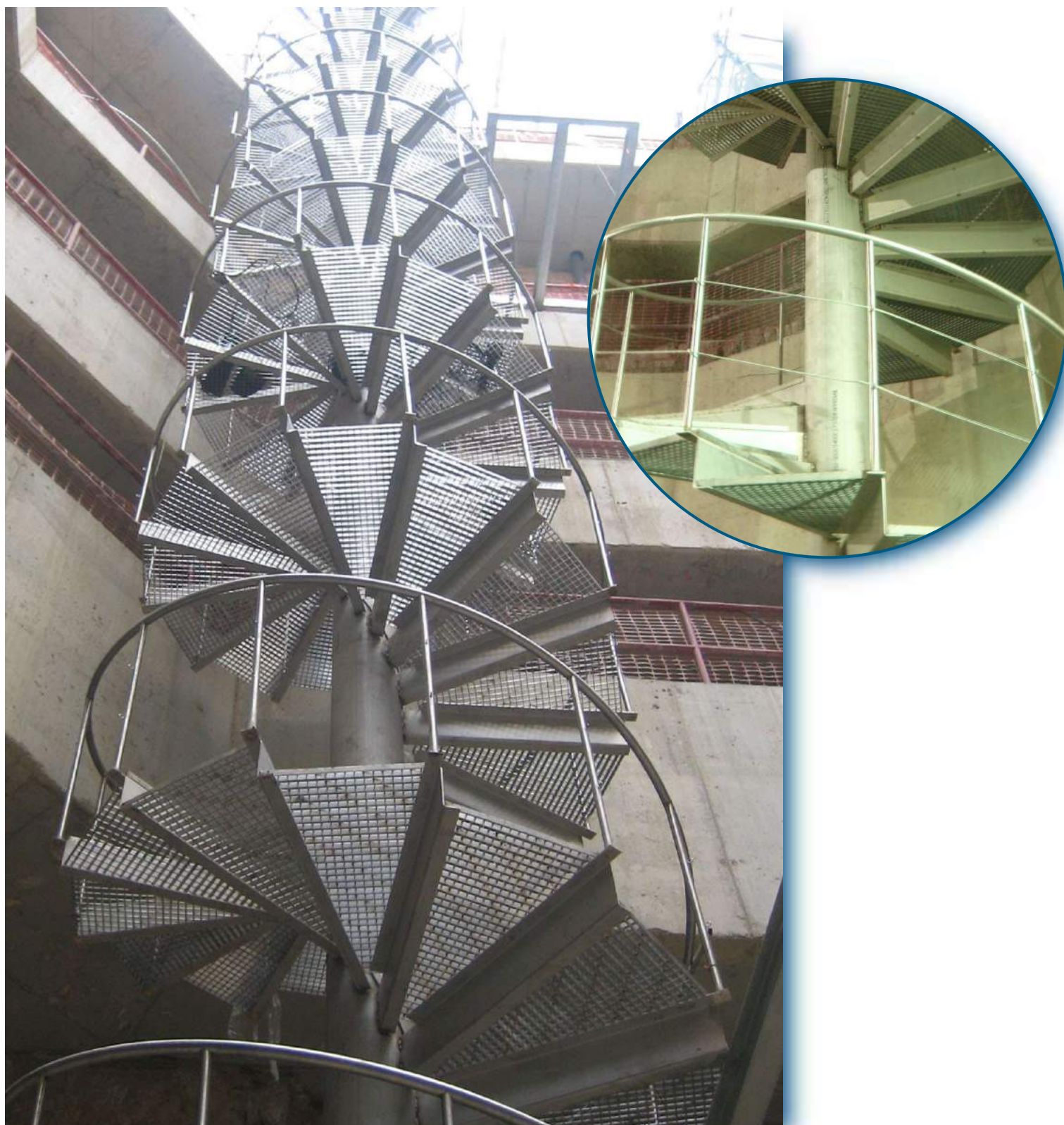
▲ Escalera de caracol y detalle de la barandilla.
