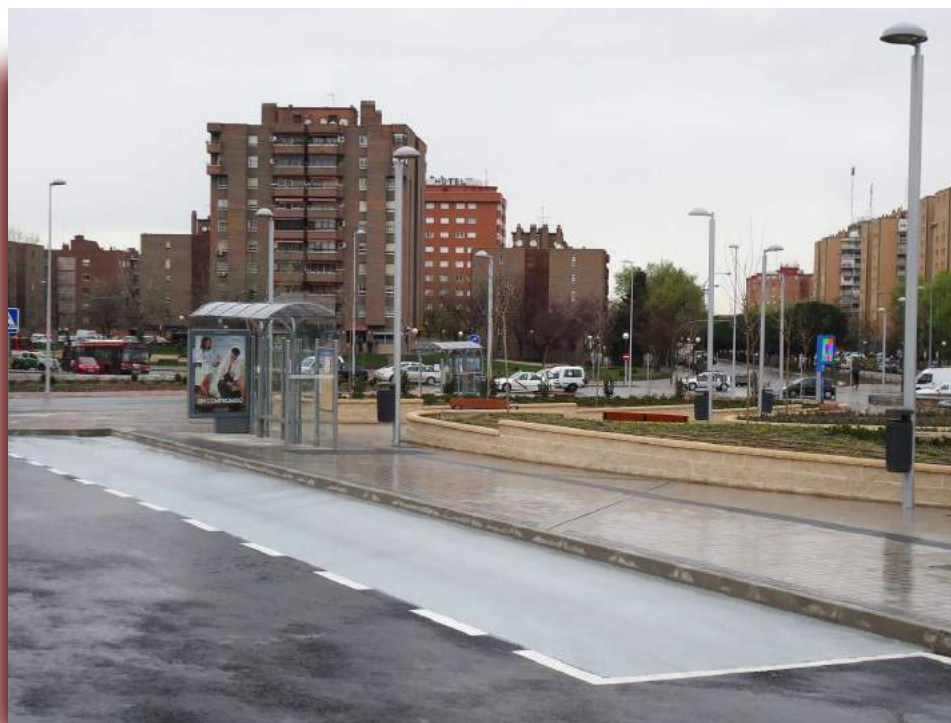
◀ Tratamiento de las Dársenas con Hormigón Impermeabilizante.
