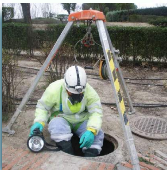
▲ Uso de EPI específicos para trabajos en colectores (consolidación de colectores previo al paso de la tuneladora).
