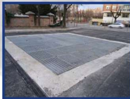
FINAL EJECUCIÓN POZOS
