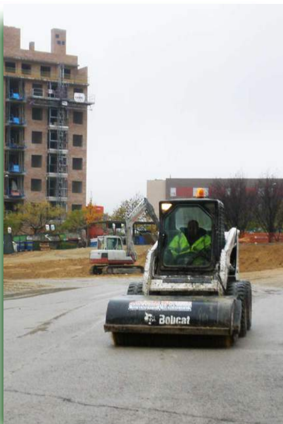
▲ Barredoras para disminuir la generación de polvo.
