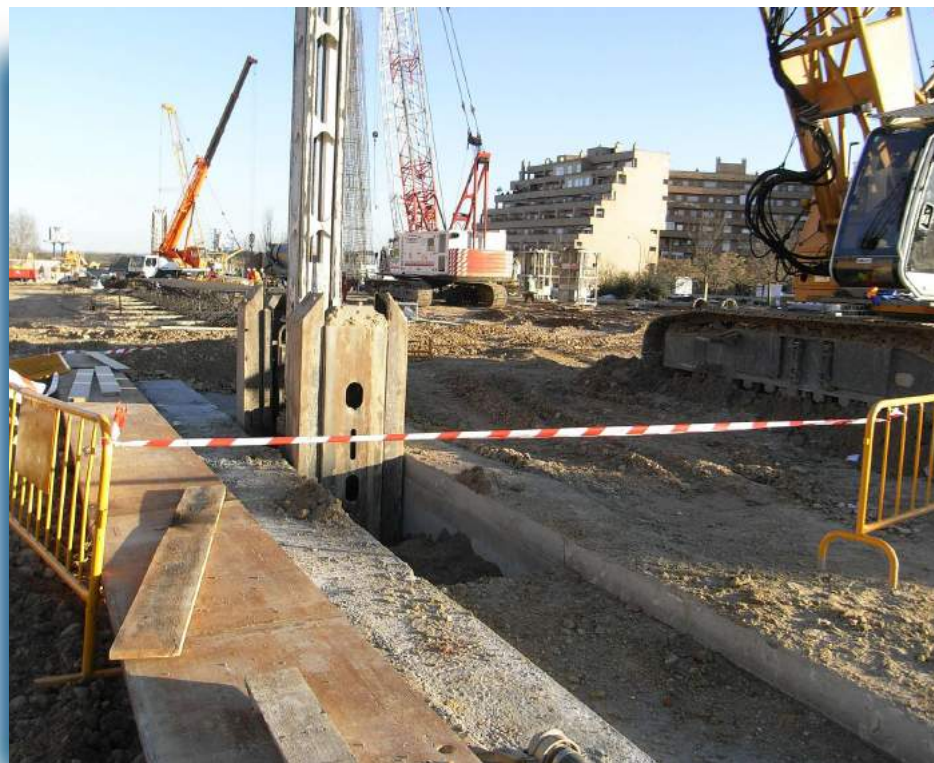
▲ Ejecución de pantallas E-4.
