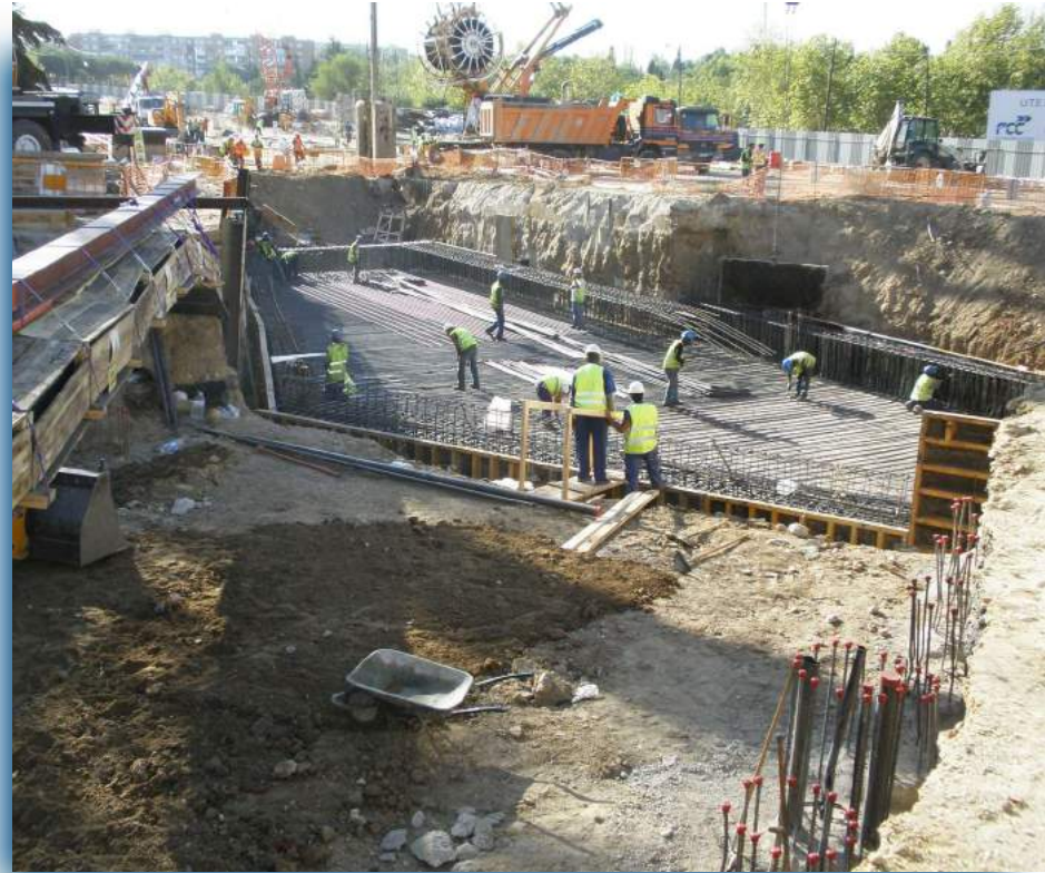
▲ Montaje losa cubierta acceso peatonal.
