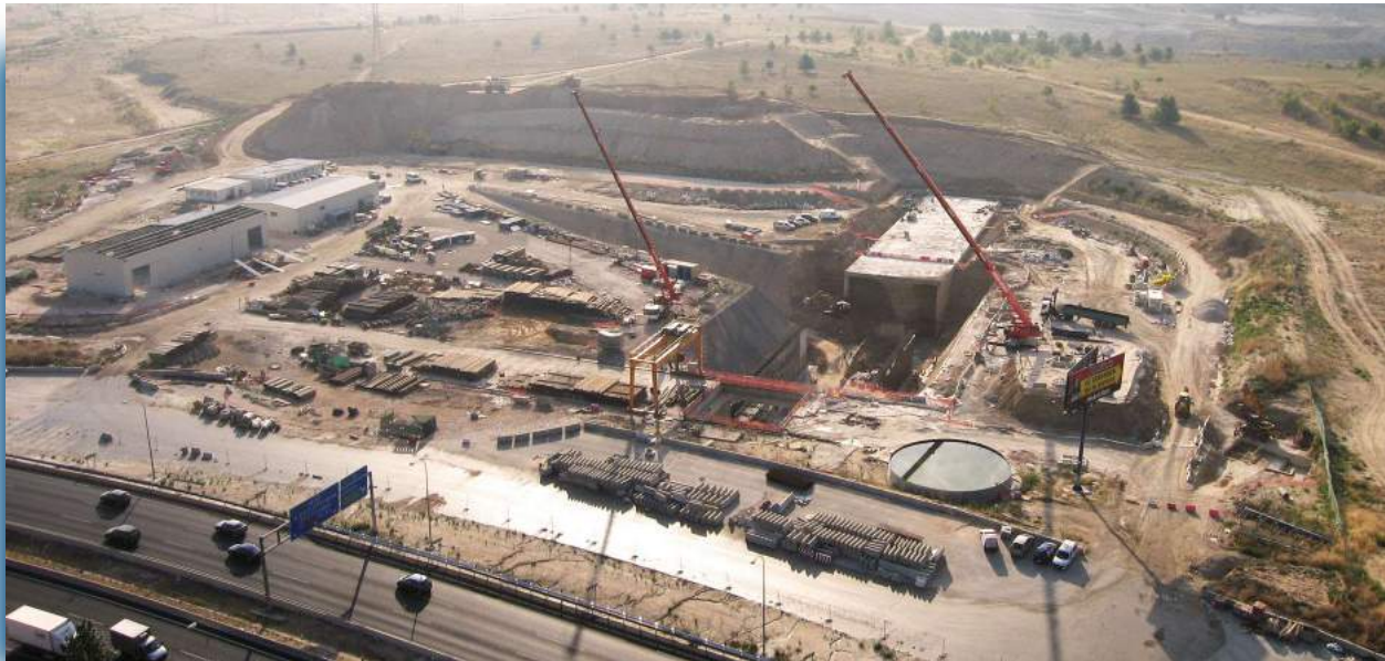
▲ Foto aérea estacionamiento Las Rosas.
