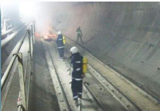
▲ Simulacro incendio túnel Fase III: Actuación de los equipos de primera intervención en el foco del incendio.
