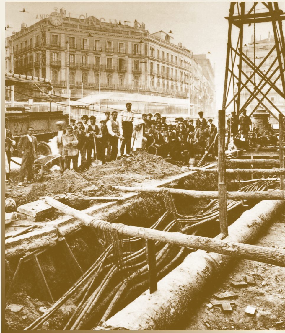
▲ La Compañía contaba inicialmente con su propia sección de construcción hasta 1926, fecha en que se iniciaría la colaboración con la empresa Agroman. (1)
