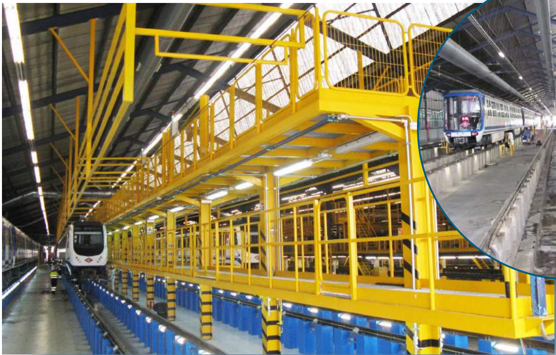
▲ Estado final cocheras Canillejas (derecha: estado inicial).
