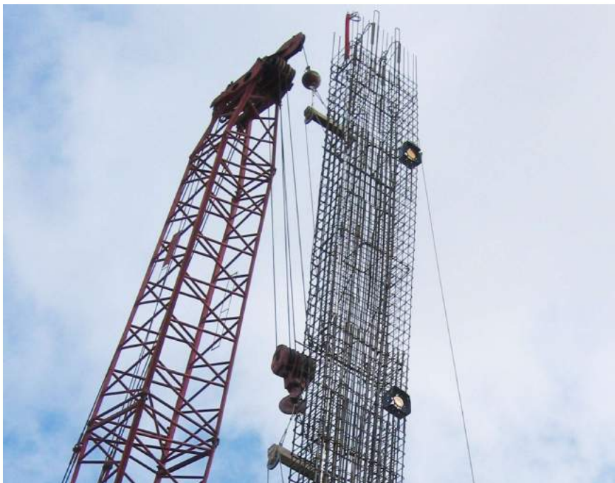
▲ Célula de presión en pantalla.
