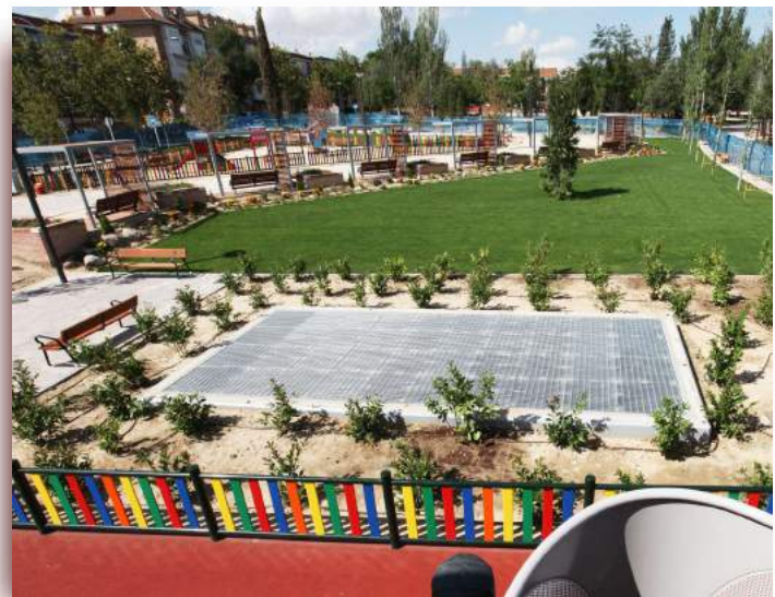
▲ Rejilla de ventilación integrada en el parque.
