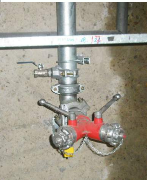
▲ Detalle boca siamesa de columna seca.
