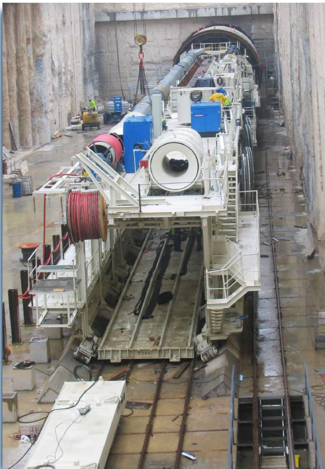
Montaje de la tuneladora ◀ en el pozo de ataque.
