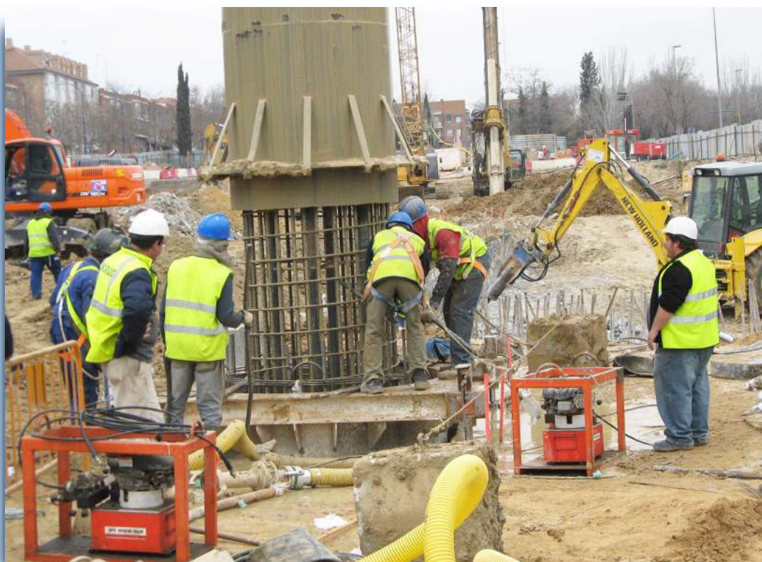
Ejecución de pilas-pilote. ◀
