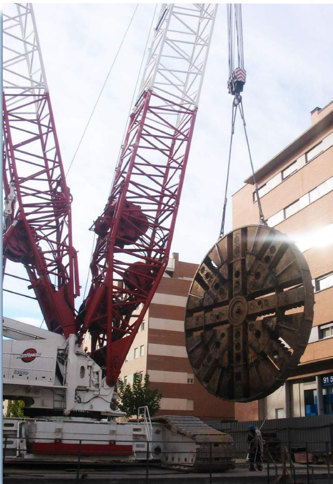
Extracción de la rueda de corte de la tuneladora. ◀
