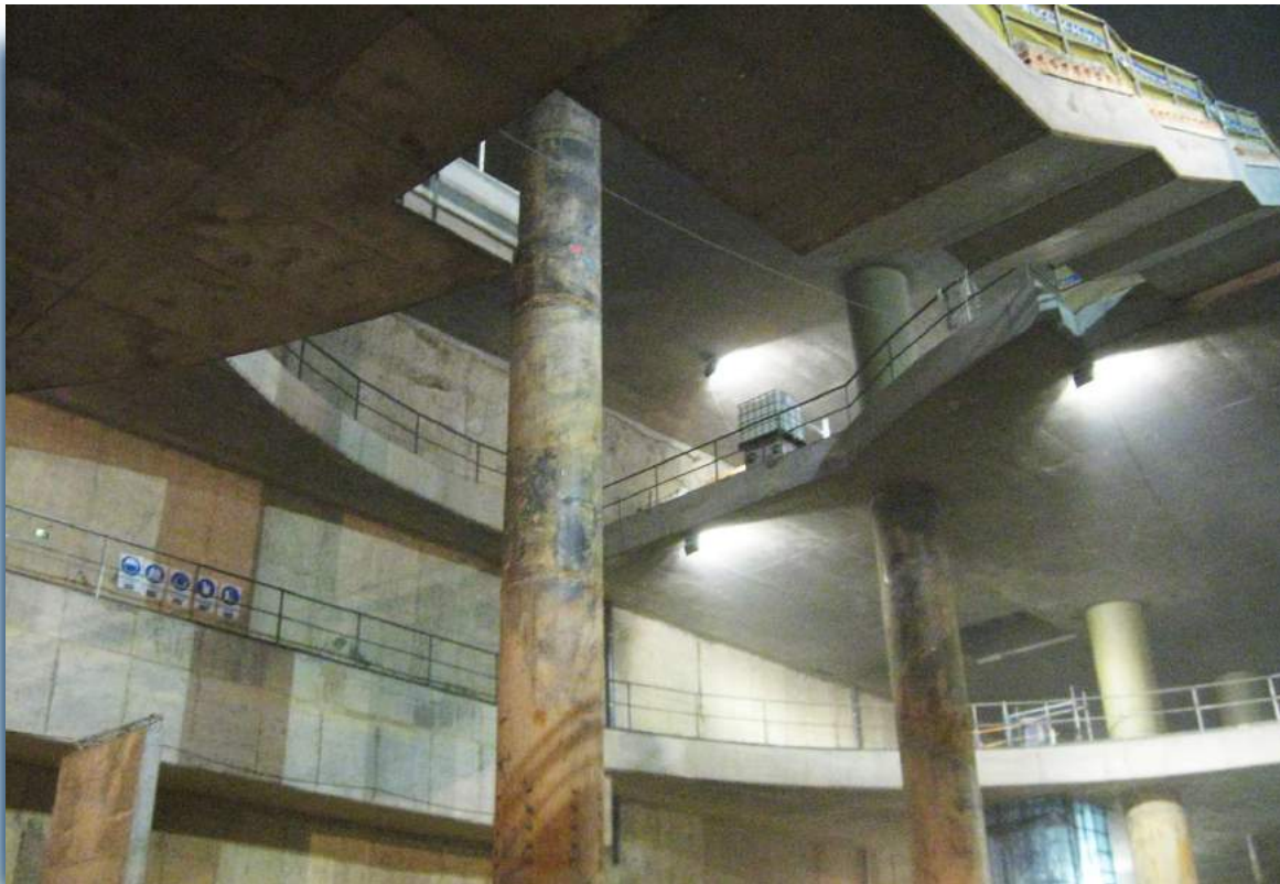
► Vista general de la obra civil.
