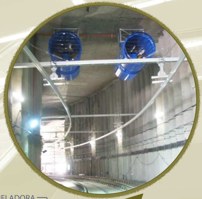
Detalle de jets en ramal a cocheras. ◀
