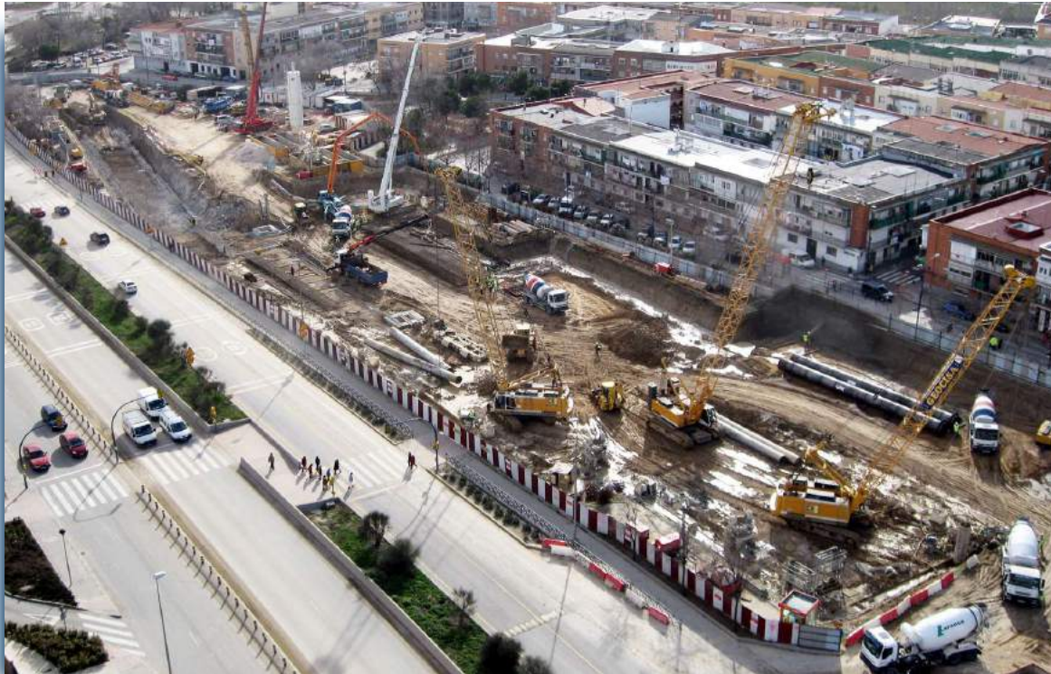
► Vista aérea de la estación en fase de ejecución de pantallas.
