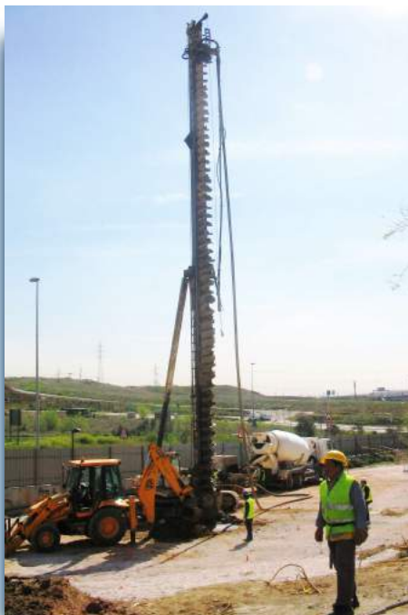
▲ Pantalla de pilotes para refuerzo de colectores.
