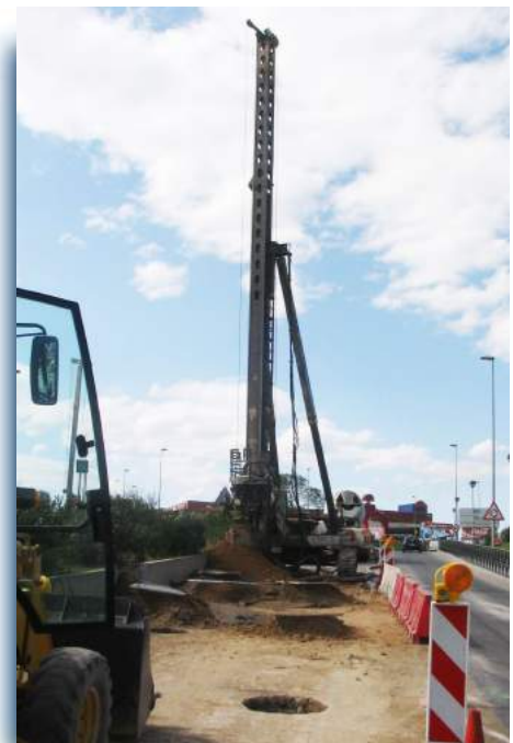
▲ Ejecución de columnas de mortero en la carretera M-411.
