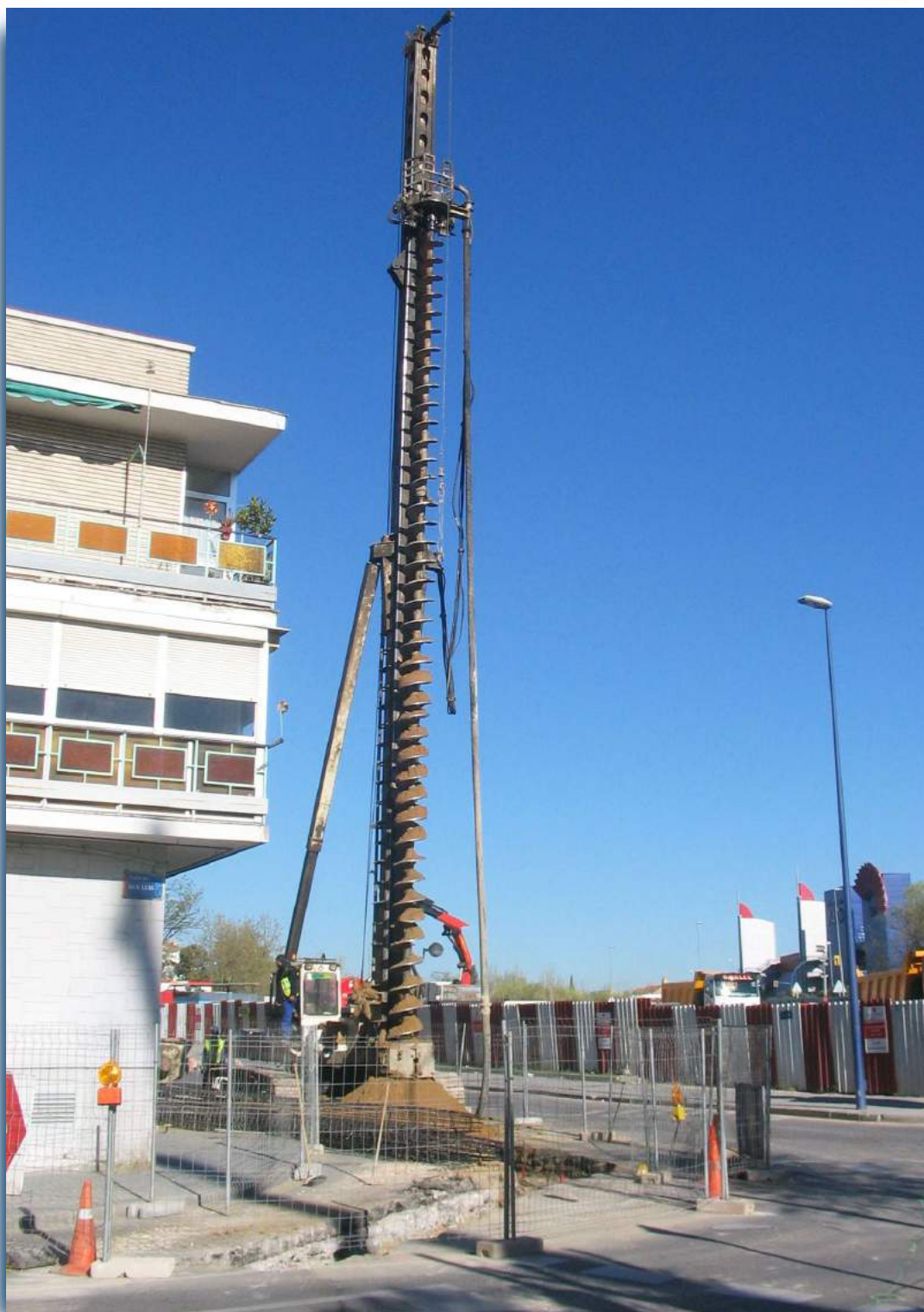
Pantalla de pilotes ◀ en calle San Luis de La Fortuna.
