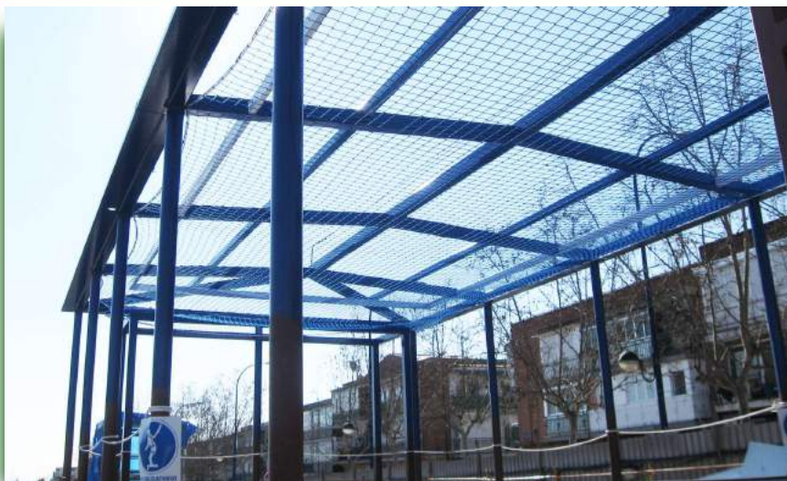
▲ Red horizontal de protección para la ejecución de trabajos en la cubierta del templete.
