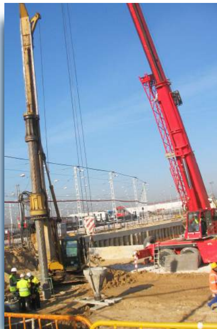
▲ Ejecución de pilotes de mortero en el emboquille del pozo de ataque.
