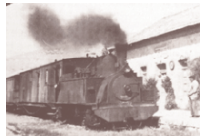
Estación de Perales de Tajuña
