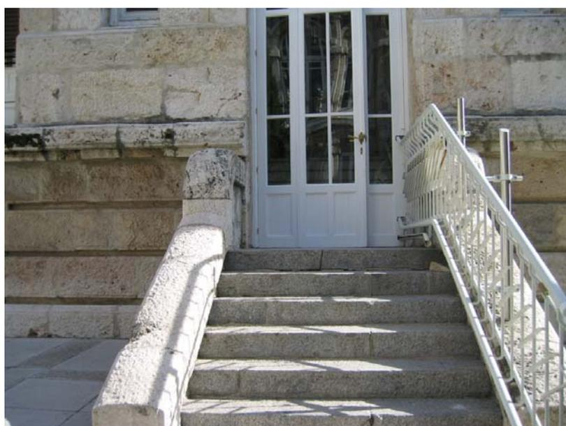
El rail de este aparato se fija a unos soportes de acero inoxidable en el tramo de escalera que queda a la intemperie, fijándose a la pared, y paralela a esta, en el tramo interior. FOTOS N° 14 y 15
