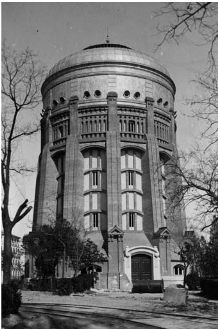
Primer Depósito Elevado del Canal de Isabel II
