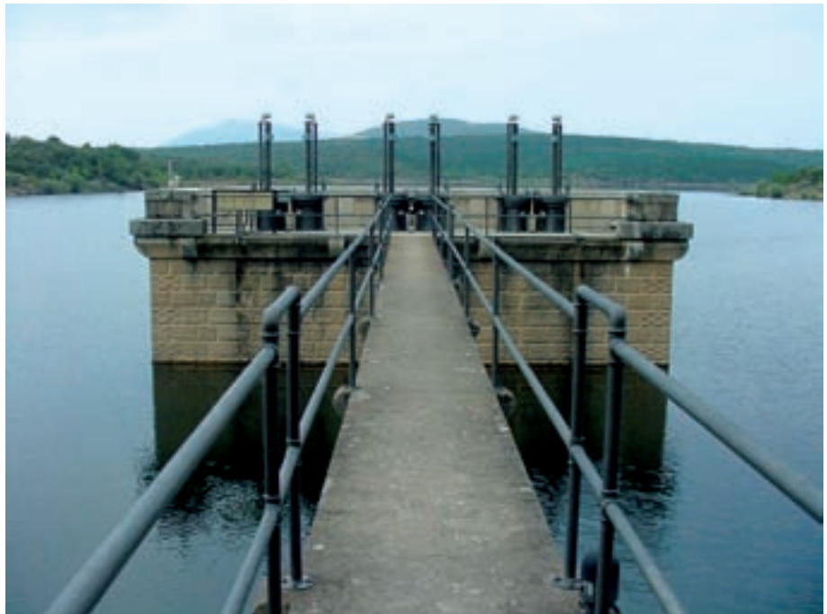
Presa de Puentes Viejas. Acceso compuertas de Puentes Viejas
