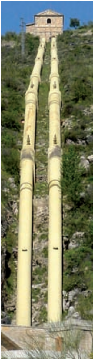
Sifón de El Pontón cruzando el Lozoya por encima del muro de la presa
