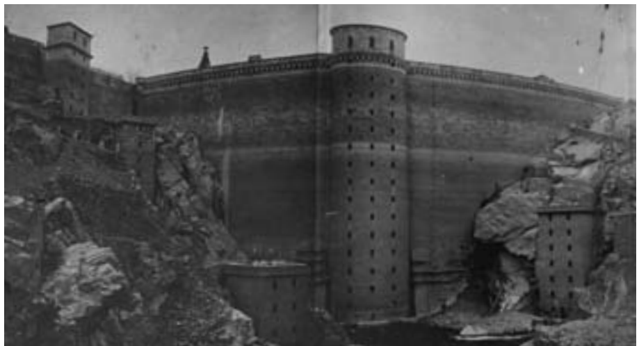
Presa de El Villar, aguas arriba
