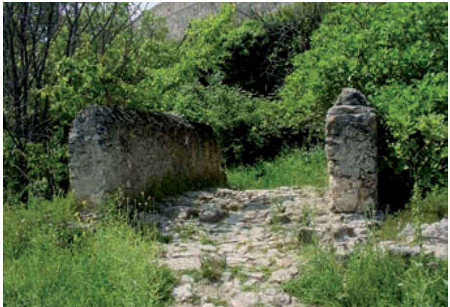
Primer plano del puente con empuje del canal de Cabarrús. Puentecillo sobre el canal de Cabarrús al pie del acueducto de Las Cuevas
