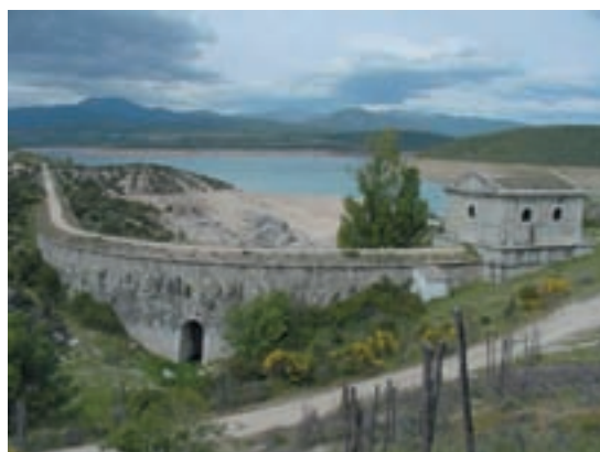
Canal de El Villar a la altura de la almenara de El Berrueco
