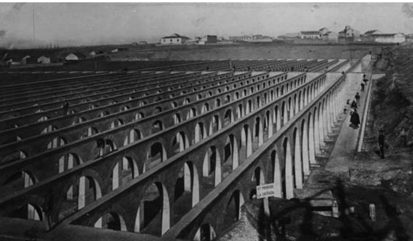
Obras de construcción del Tercer Depósito
