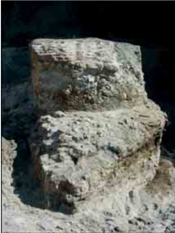
Figura 4. Vista de la pila 4 aguas arriba. Nótese la desviación del tajamar.
