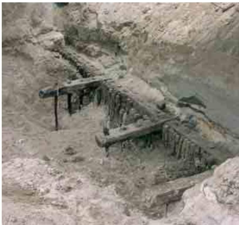
Figura 6. Sistema de anclaje del bordillo sur (exterior) mediante viga horizontal y pilotes verticales.
