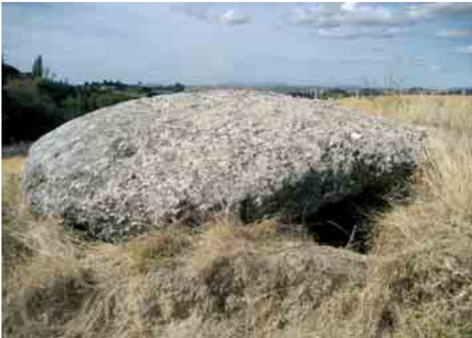
Bunker nº 1 con cubierta hexagonal de hormigón en la Fuente del Cura.
