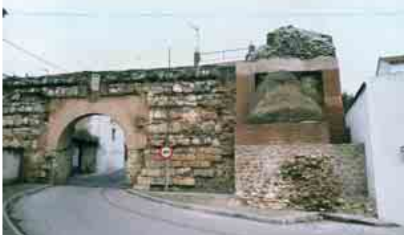
Figuras 10a y 10b. Talamanca de Jarama. Actuación de consolidación de los restos de una torre de flanqueo en la puerta de la Tostonera: estado inicial y final.
