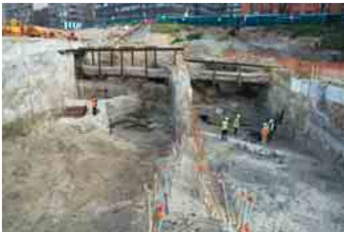
Figura 3. Vista de los restos de la Cabecera y arranque del Canal en los túneles de la M-30.
