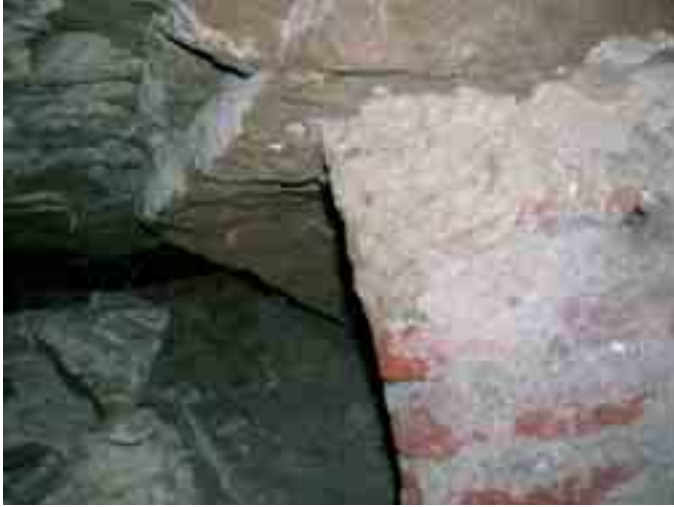
Figura 3. Interior del túnel.
