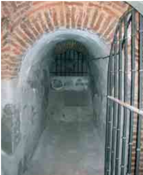
Figura 6. Interior del túnel del sótano de la Casa de Lope de Vega, que emboca con el documentado en el solar de Cervantes 20, justo enfrente, al otro lado de la calle.
