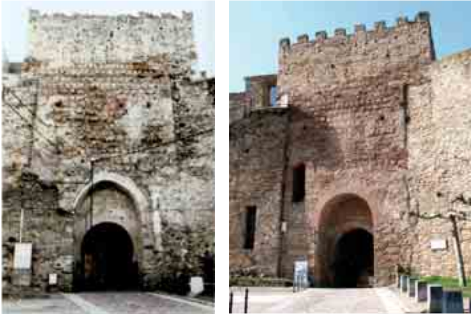
Figuras 8a y 8b. Buitrago del Lozoya: fachada oriental de la Torre del Reloj, antes y después de su restauración.
