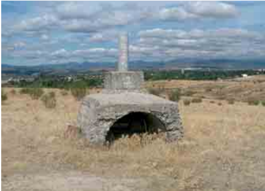
Bunker nº 6 del Vértice Cumbre.
