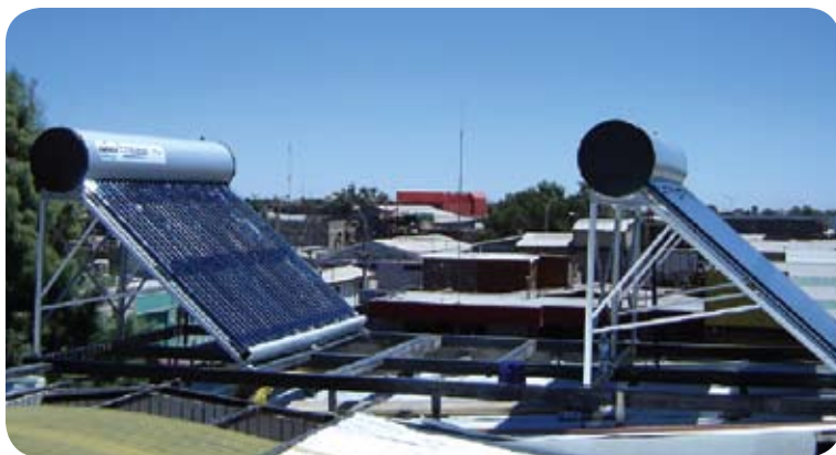
Los colectores solares permiten aprovechar la energía del sol para producir calor
