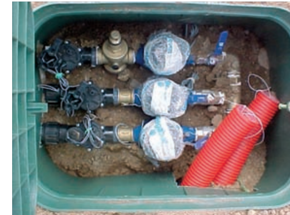
Figura 27. Imagen de una arqueta tras la colocación
