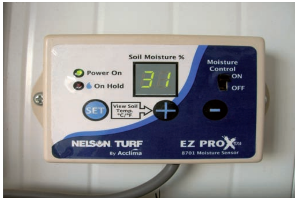
Figura R. Controlador marca "Nelson"
