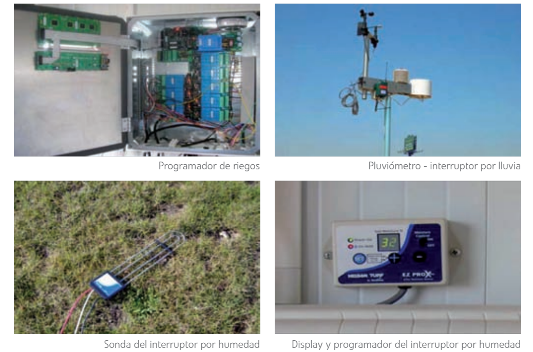
Figura 6. Programador, pluviómetro e interruptor por humedad
