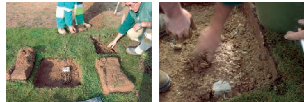
Figura 26. Instalación de sensor de humedad
