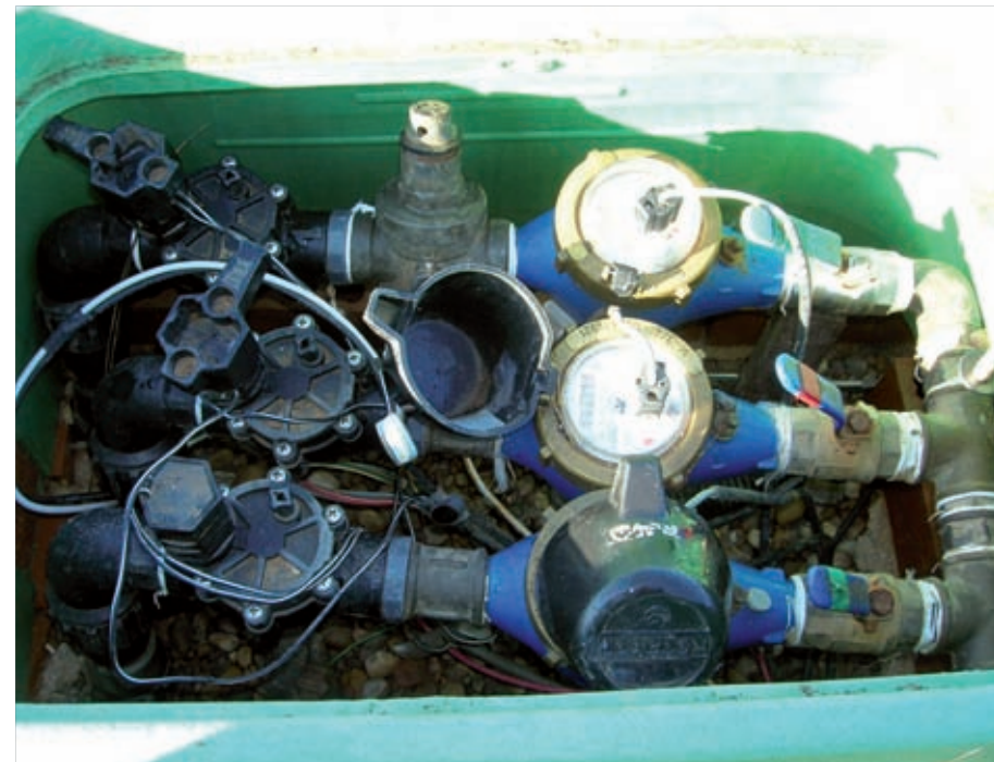
Figura U. Contador de agua y electroválvula
