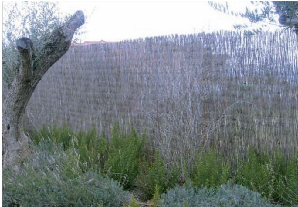
Figura F. Cerramiento de brezo
