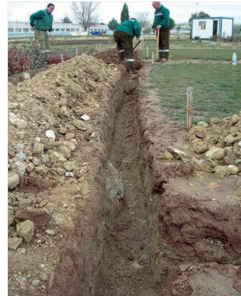
Figura K. Realización de drenajes en el parque piloto
