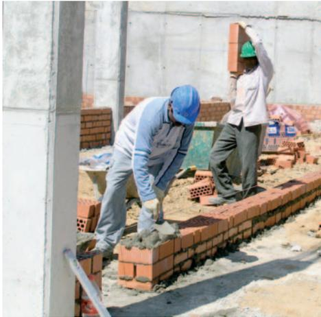
*Figura 027. Utilización de guantes al manejar una carga agresiva, aunque con un manejo inadecuado de la carga.*
