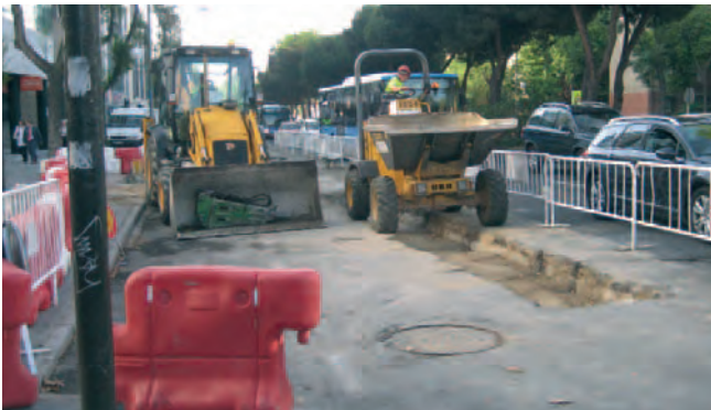
Figura 060. Circulación de maquinaria por zona inadecuada, con posibilidad de vuelco y sin utilizar cinturón de seguridad.
