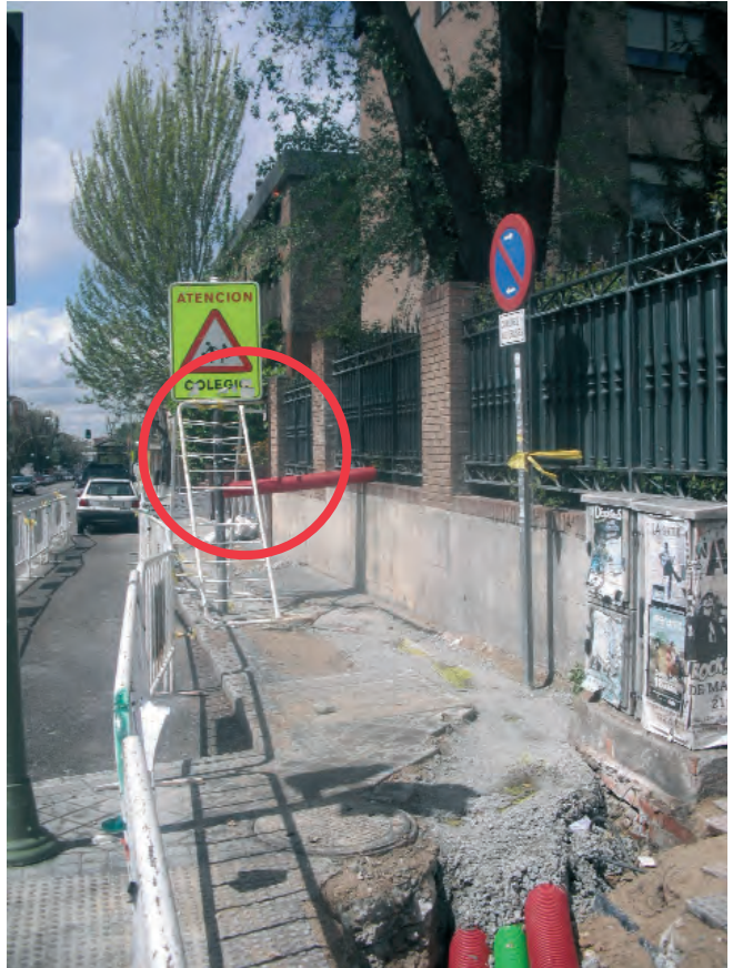
Figura 027. Sujeción improvisada de señalización.
