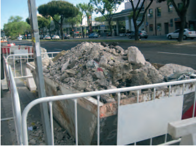
Figura 088. Contenedor sobrecargado.
