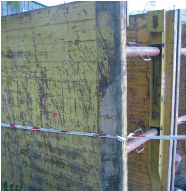
Figura 103. Sistema de entibación prefabricado. Debe estar en obra antes del comienzo de los trabajos.
