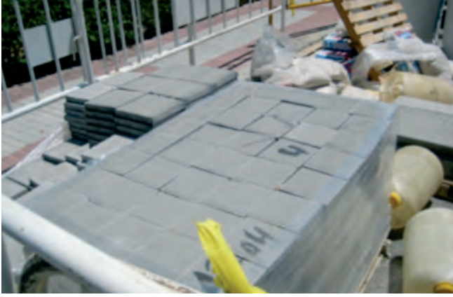
Figura 021. Palets de baldosas.
