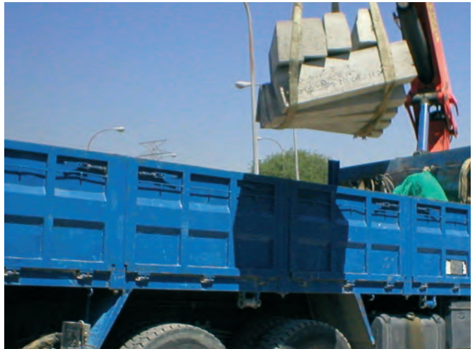
Figura 161. Maniobra de descarga incorrecta; materiales sueltos, elevación bordillos con pluma sin paletizar.
