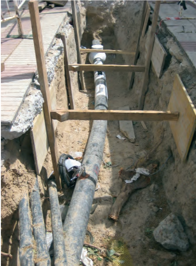
Figura 078. Conducción de gas antigua.
