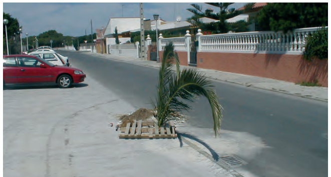
Figura 008. Hueco con protección inadecuada y sin señalizar.
