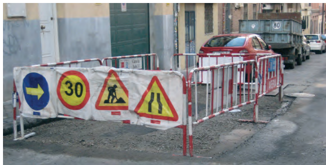
Figura 002. Vallado y señalización de zona de trabajo.
