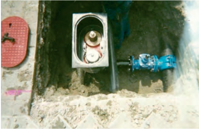
Figura 037. Hidrante para uso de bomberos.
