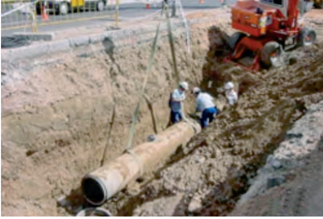
Figura 092. Taluzado de las paredes de la zanja.
