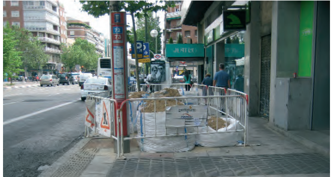
Figura 007. Acopio de material en acera adecuadamente acotado.
