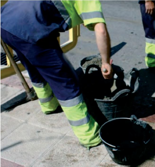
Figura 181. Preparación de mortero a mano.
