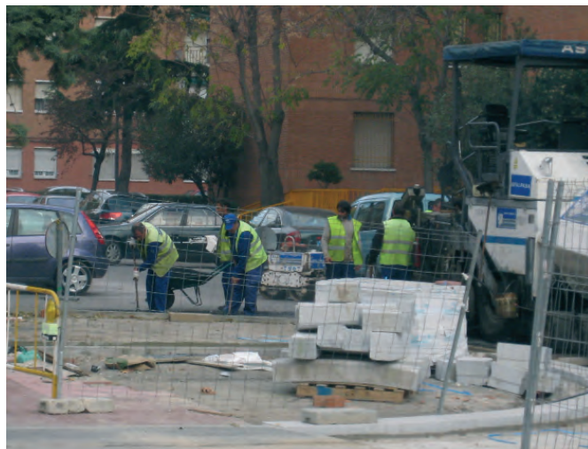
Figura 160. Operaciones de asfaltado. Vertido y extendido a mano en zona de difícil acceso para la extendidora.
