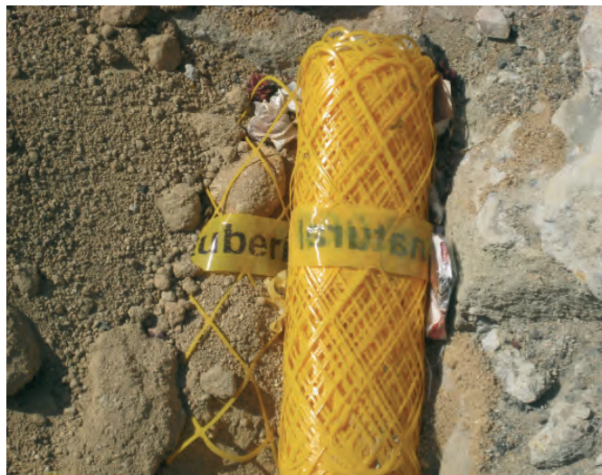
Figura 133. Cinta de señalización de gas.
