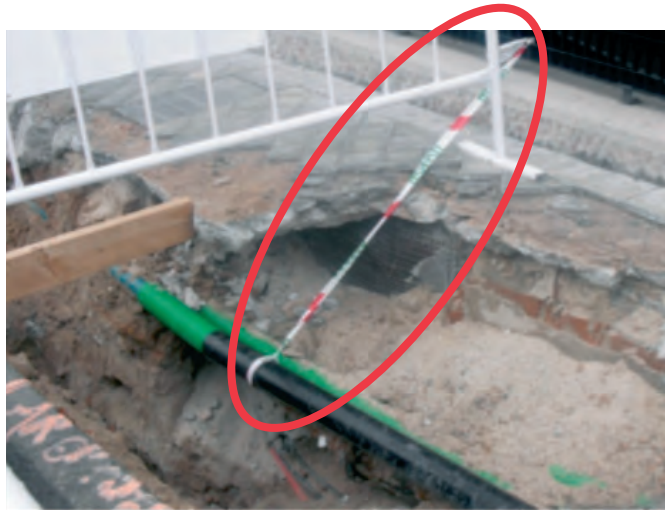
Figura 074. Evitar improvisaciones en el apeo de conductos cuando queden descolgados.
