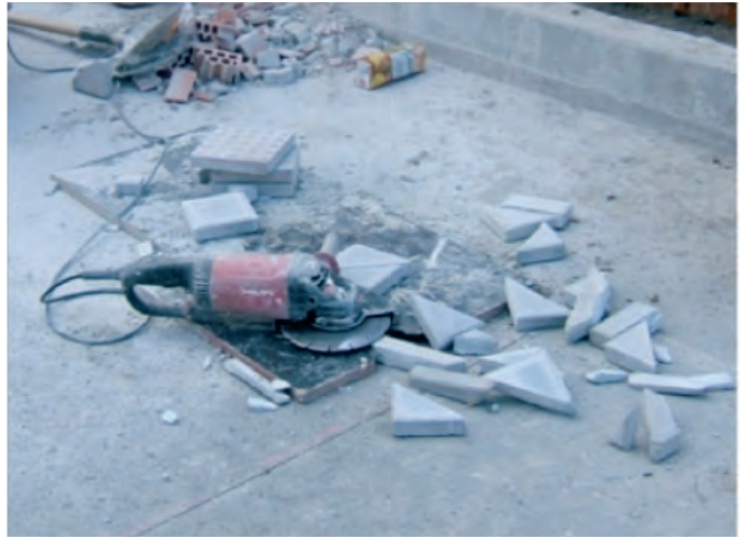
Figura 179. Radial abandonada en medio de la acera.
