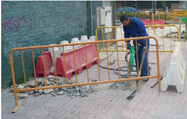
Figura 041. Se guarda distancia evitando la adición de dos fuentes ruidosas.
