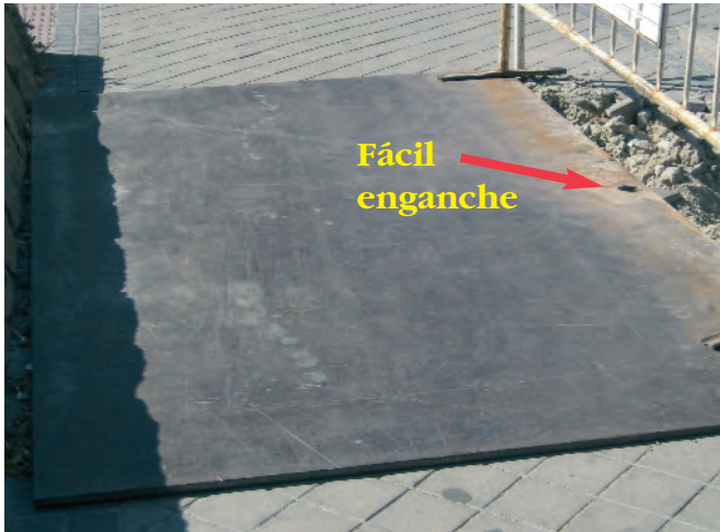
Figura 146. Chapón con orificio, en un extremo, para su manejo.
