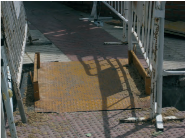
Figura 016. Pasarela peatonal y barandilla.
