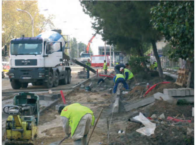
Figura 154. Vertido de bormigón con canaleta.
