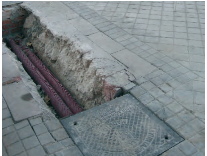
Figura 129. Canalización de regulación de tráfico.
