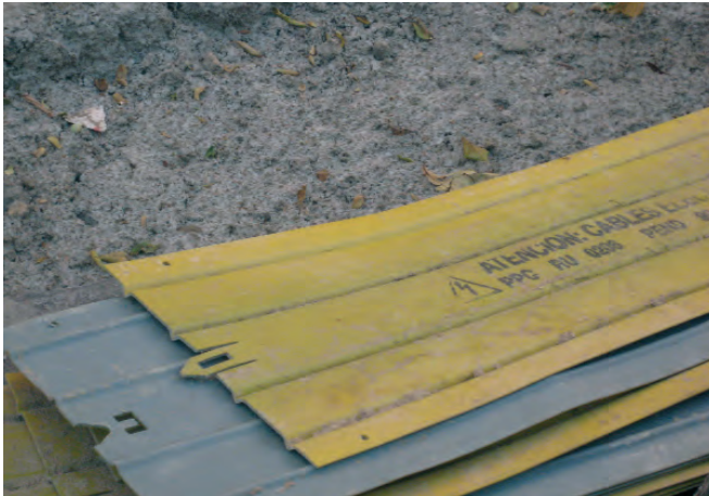
Figura 118. Protección rígida para cables desnudos.
