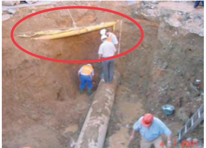
Figura 075. Sujeción de conductos.
