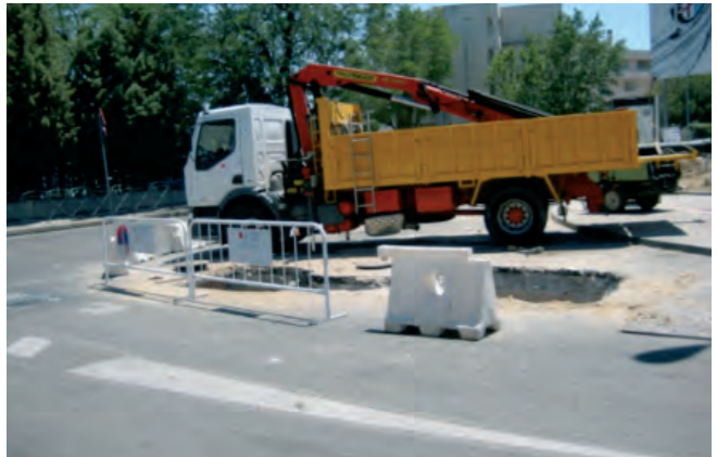
Figura 019. Camión con grúa.
