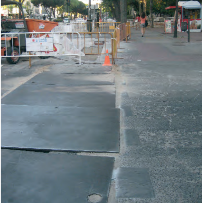
Figuras 026. Ejemplo de excavación en calzada.
