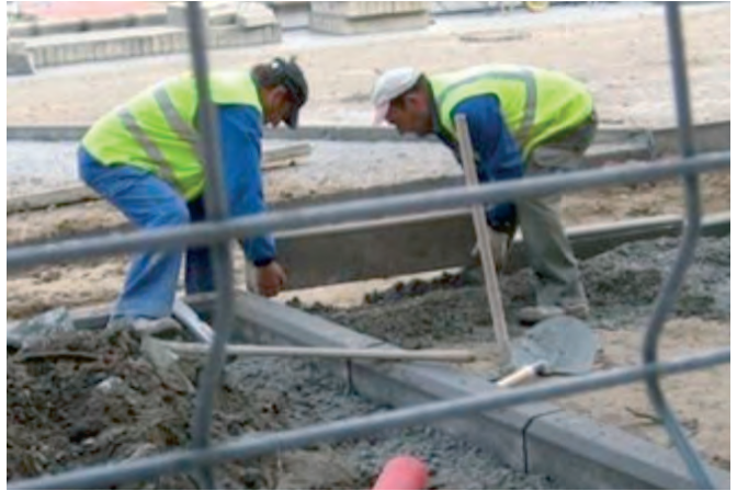
Figura 166. Trabajadores flexionando las rodillas durante la manipulación del bordillo, reducen el esfuerzo transmitido a la espalda.. El movimiento conjunto requiere una buena coordinación.
