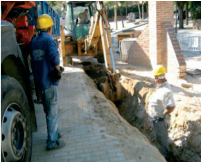
Figura 051. El trabajador no debe estar dentro de la zanja mientras trabaja la máquina.
