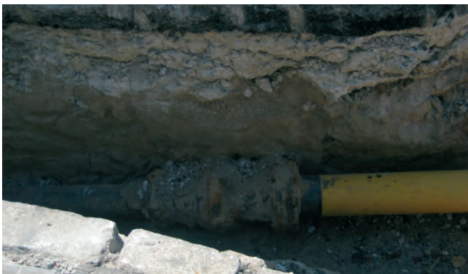
Figura 079. Reparación de conducción antigua de gas con tubo moderno de color amarillo.
