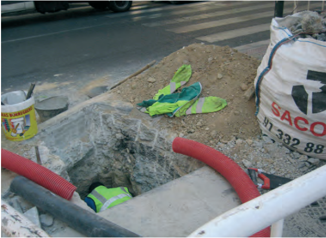
Figura 031. Cala para reparación de un servicio.
