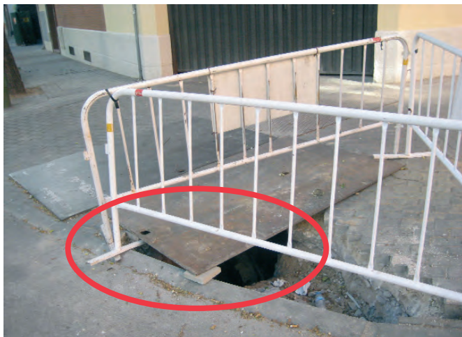
Figura 144. Apoyo inestable de la chapa.
