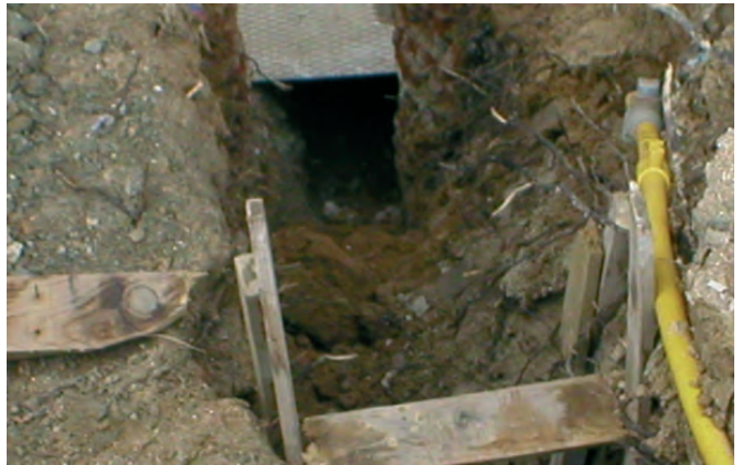
Figura 100. Solución incorrecta e improvisada que no otorga ninguna garantía. El personal que lo realice debe disponer de formación y experiencia contrastada.
