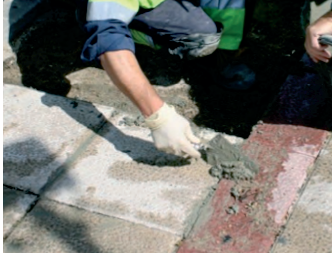
Figura 184. Colocación de baldosas.
