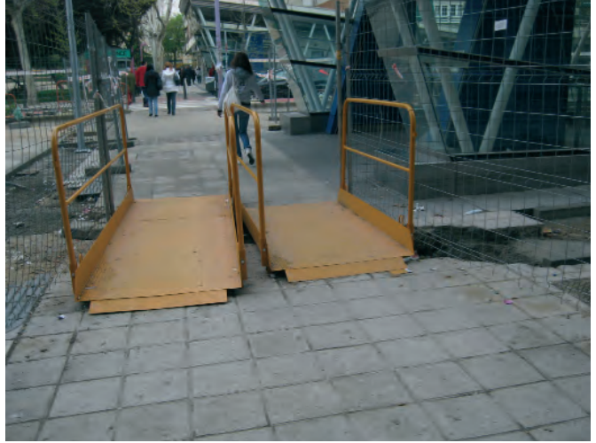
Figura 136. Doble pasarela peatonal.
