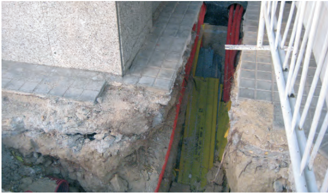
Figura 076. Conductores eléctricos al descubierto.
