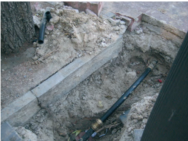
Figura 032. Acometida de agua.
