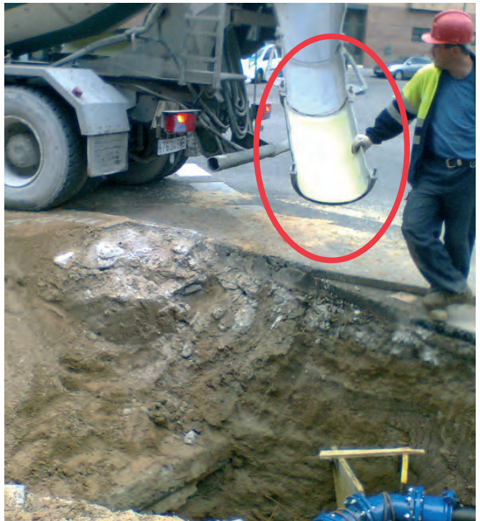
Figura 156. Precaución con el despliegue de la canaleta; asir desde la zona establecida para ello.
