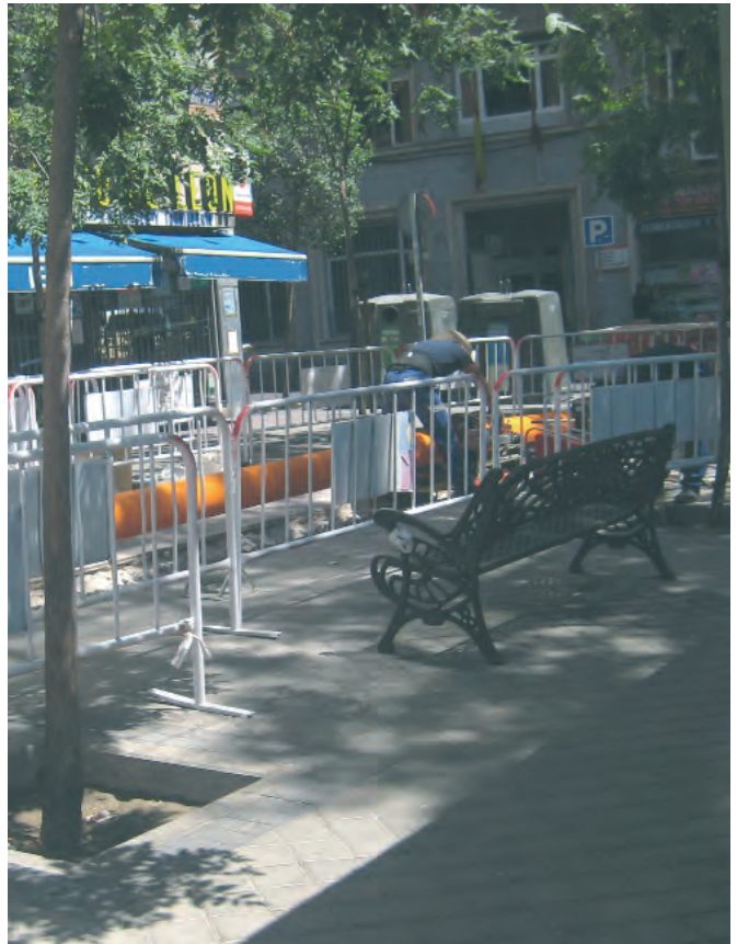
Figura 124. Ejemplos de tendido de conductos de gas, material PE , con uniones soldadas.
