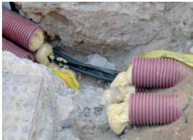
Figura 122. Sellado de tubos de protección.
