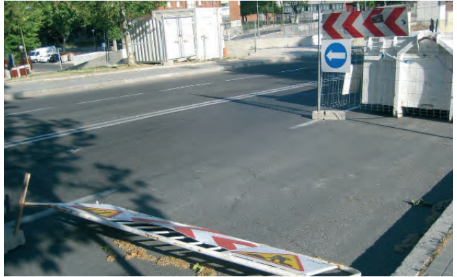
Figura 009. Inadecuada fijación del vallado.
