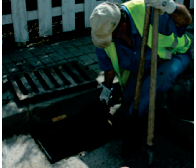
Figura 190. Limpieza de imbornal.
