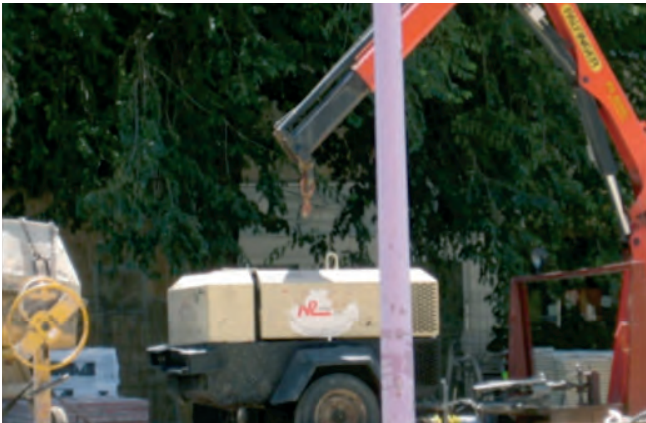
Figura 022. Descarga de un compresor.
