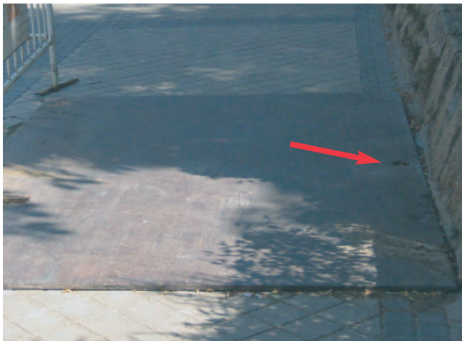
Figura 147. Chapón con orificio para su manejo, pero mal posicionado, lo que hace difícil su enganche.
