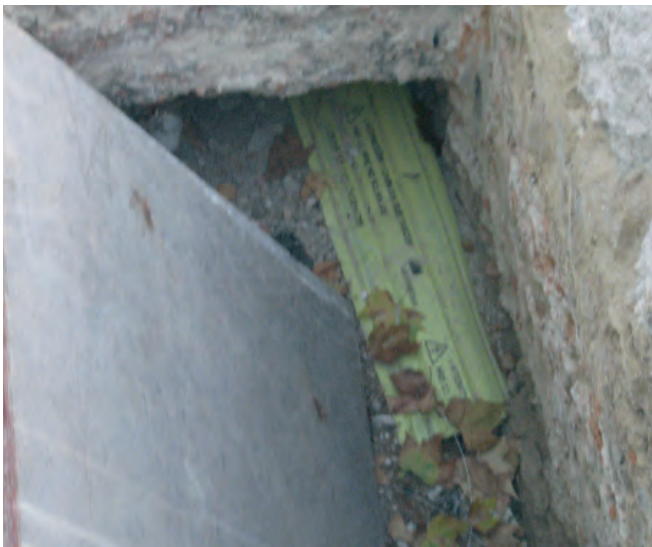
Figura 119. Cables protegidos con placas cubrecables
