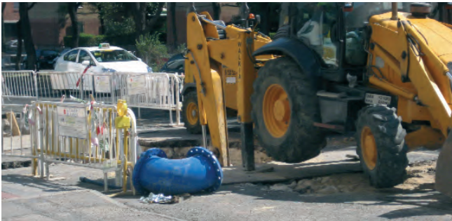
Figura 059. Apoyo sobre "chapon"; debe comprobarse la resistencia del apoyo.
