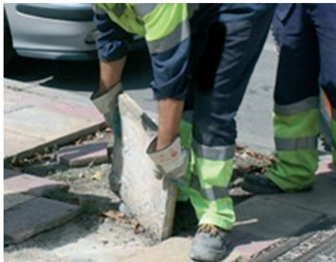
Figura 174. Levantamiento de baldosas a mano.
