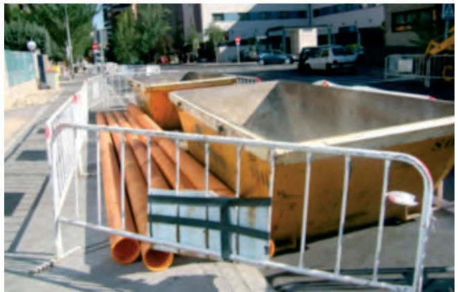
Figura 020. Contenedores y tuberías.
