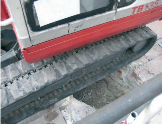
Figura 062. Apoyo de máquina sobre zanja.
