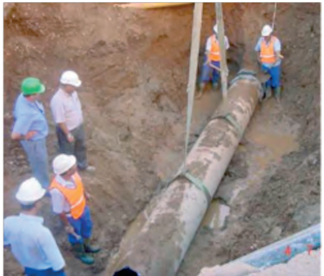
Figura 114. Manipulación de tubos aborcándolos con eslinga.
