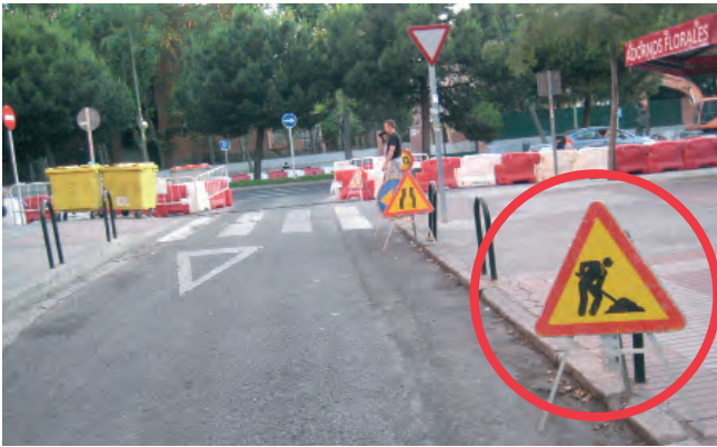
Figura 005. Señal de “peligro obras” en la calzada.
