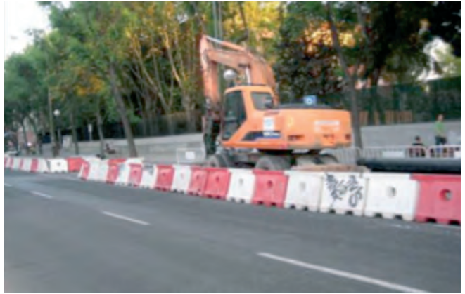
Figura 038. Demolición de acera.
