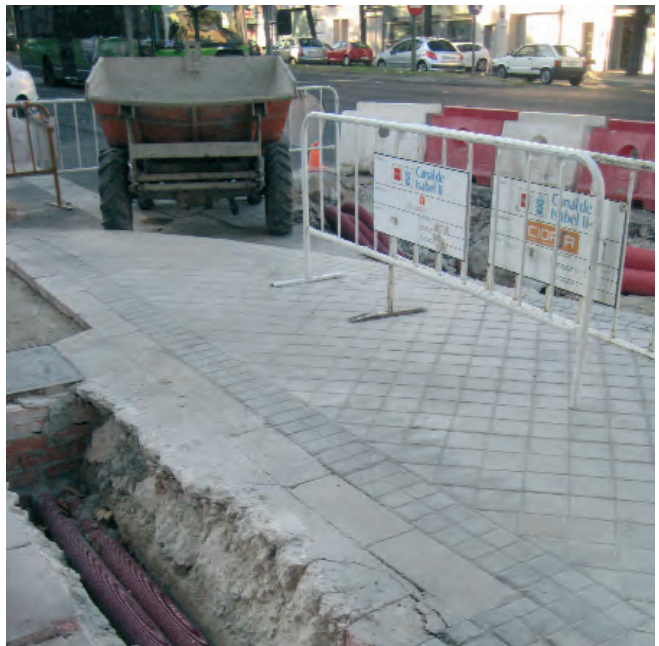
Figuras 025. Ejemplo de excavación en acera.
