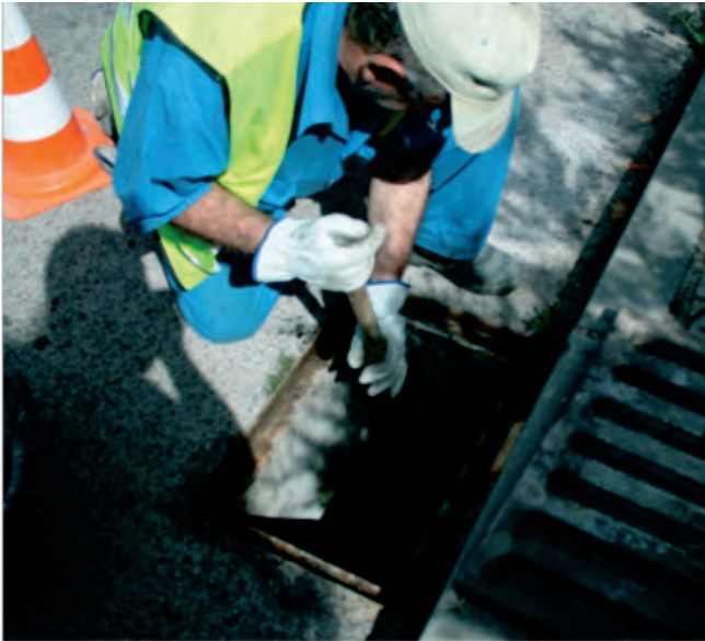
Figura 189. Limpieza de imbornal.
