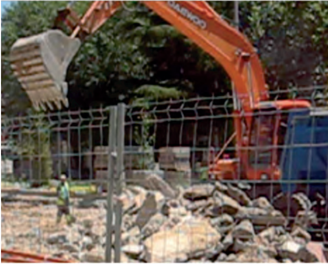
Figura 050. El operario mantiene inicialmente la distancia; pero cuando el maquinista inicia la descarga se introduce en la zona de excavación sin conocerlo el maquinista.
