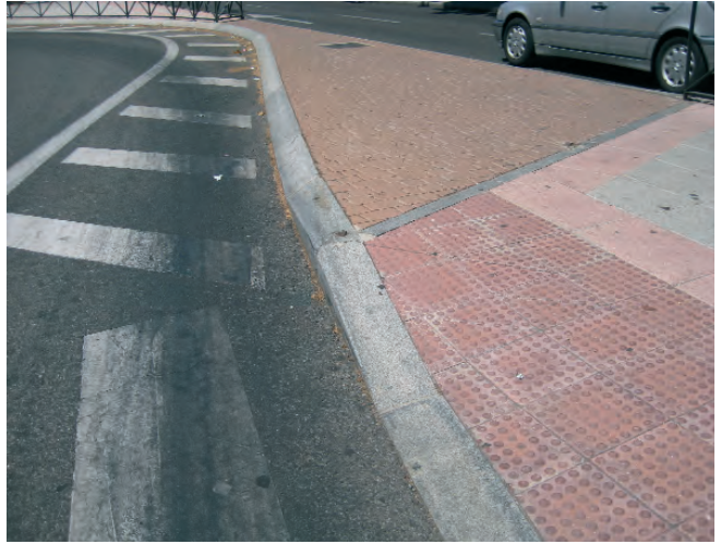
Figura 036. Modificación bordillos en pasos de peatones.
