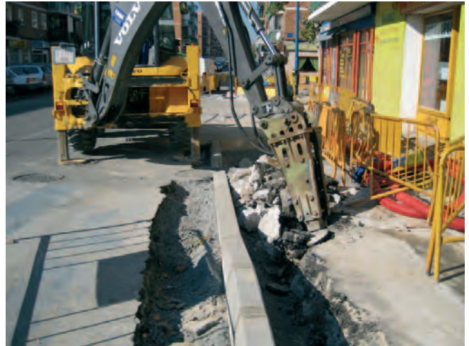
Figura 043. El tipo de terreno sobre el que se trabaja modifica los valores de exposición a vibraciones y ruido.
