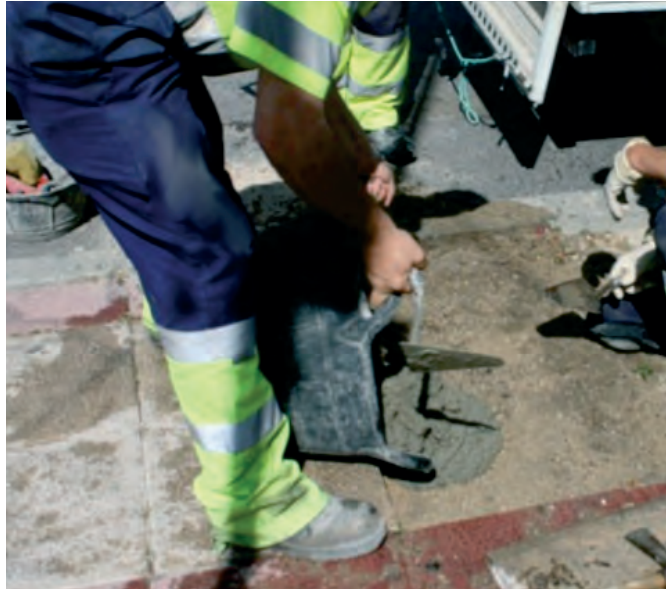
Figura 182. Vertido de mortero sin guantes de protección.
