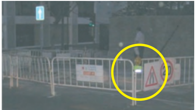
Figura 013. Luz ámbar intermitente, ubicada en el ángulo saliente.
