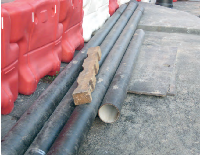
Figura 112. Emplear piezas facilitadas por el suministrador que permiten mantener los tubos en posición estable.
