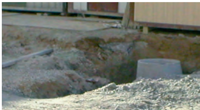
Figura 108. Acceso a zanja mediante rampa.
