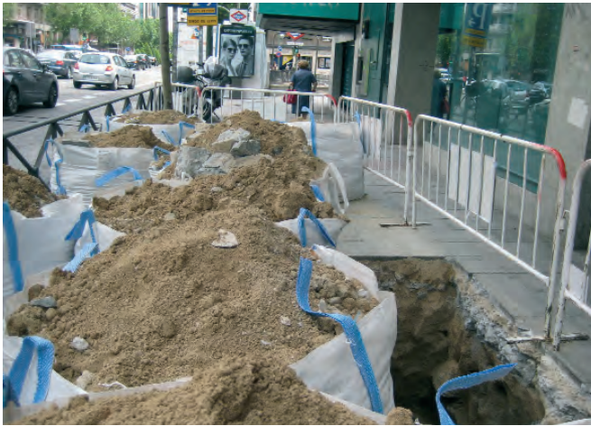
Figura 085. Productos de la excavación retirados en bolsas big-bag, pero colocados al borde de la zanja provocando una sobrecarga estática.
