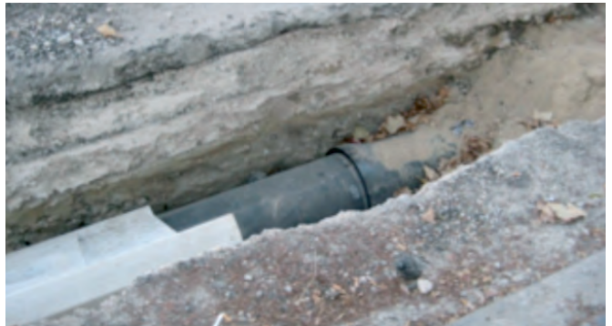
Figura 077. Tubería de agua potable.
