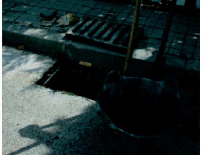
Figura 187. Retirada de rejilla.
