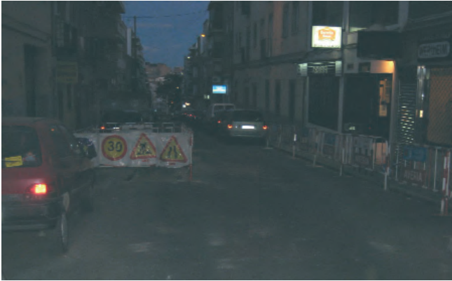
Figura 011. Señalización de obra, señales no reflectantes.
