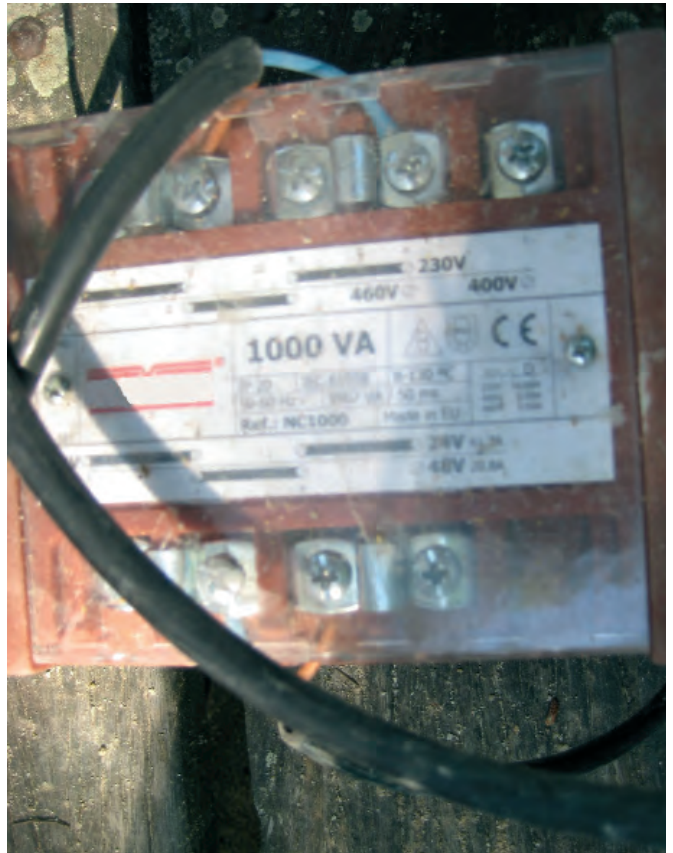
Figura 091. Transformador de separación de circuitos, que garantiza con la tensión de salida que la gravedad en caso de contacto eléctrico sea tolerable.
