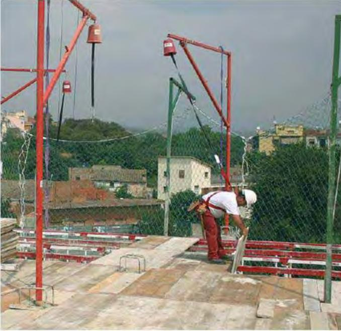
Fig. 57 - Sistema de percha para utilización de arnés de seguridad
