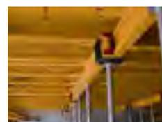
Sistema de unión entre puntales y vigas riostras en encofrado de forjados
