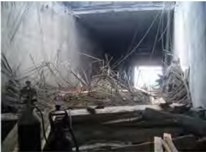
*Fig. 15 -Desplome de cimbra y encofrado de losa superior de falso túnel.*
