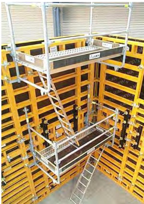
Fig. 81 – Ejemplo de plataforma de trabajo con acceso integrado.
