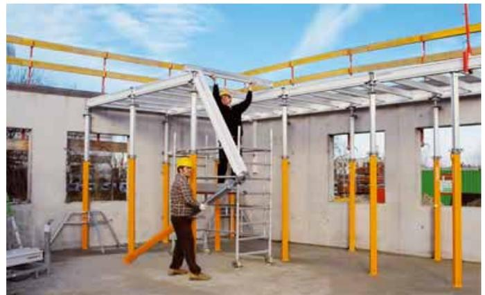
Fig. 63 - Andamios empleados en montaje de elementos de soporte de forjados unidireccionales.
