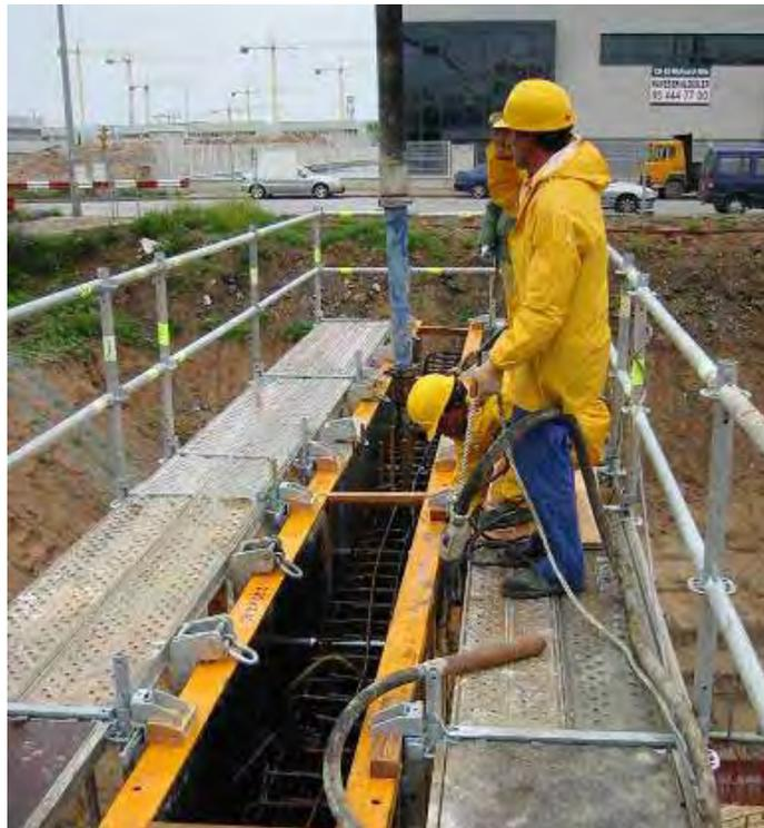
Fig. 79 Hormigonado y vibrado con plataformas a ambos lados de coronación del encofrado.
