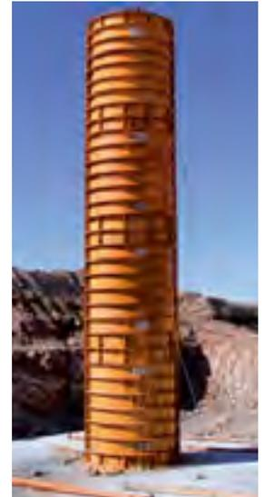
Fig. 35 – Encofrado de pilar cuadrado y circular.
