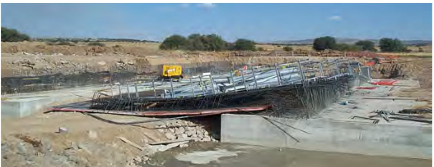
Fig. 13 - Desplome de encofrado y armadura con andamio en ejecución de muro.
