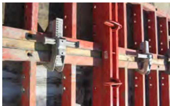
Fig. 9 - Ganchos para arnés de seguridad. Taladros en las costillas de paneles de encofrado.
