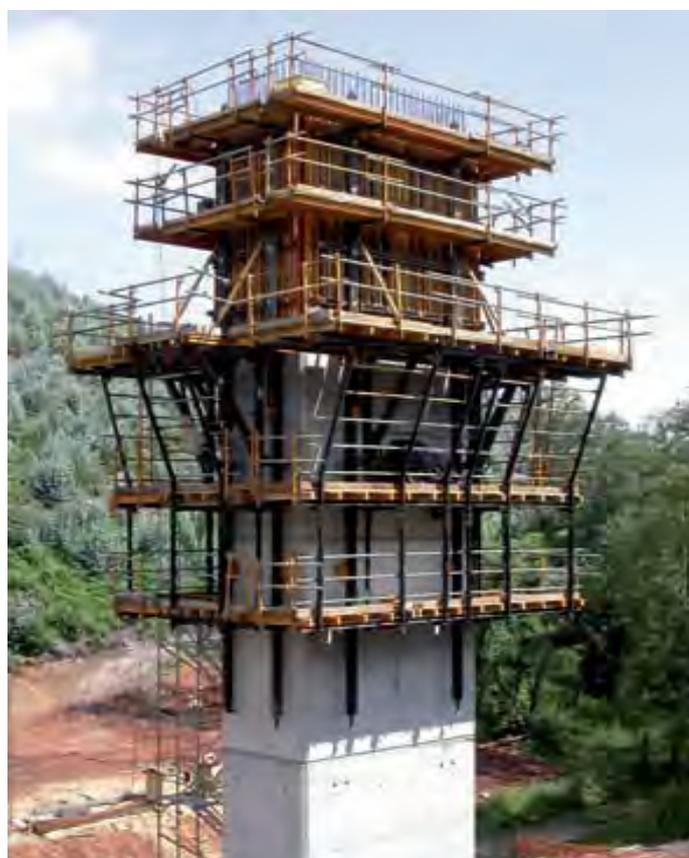
Fig. 39 – Encofrado autotrepante: esquema y construcción de pila de viaducto (ULMA)
