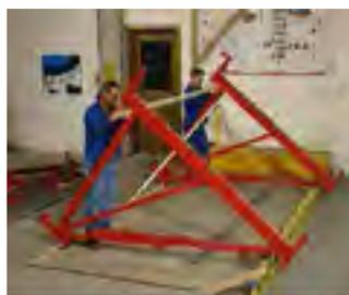
5. Colocar los tubos de arriostamiento entre consolas, uniéndolos con las grapas de unión.
