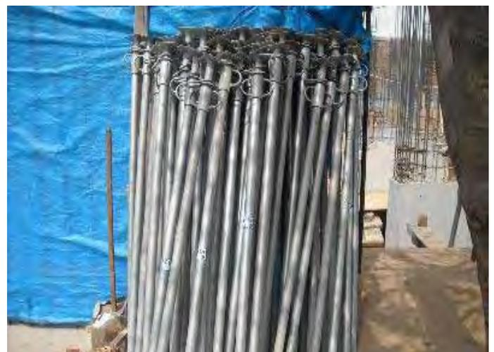
Fig. 80 – Acopio inadecuado de puntales una vez realizado el desencofrado.
