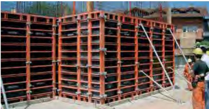
Fig. 34 – Encofrado de muro a dos caras.
