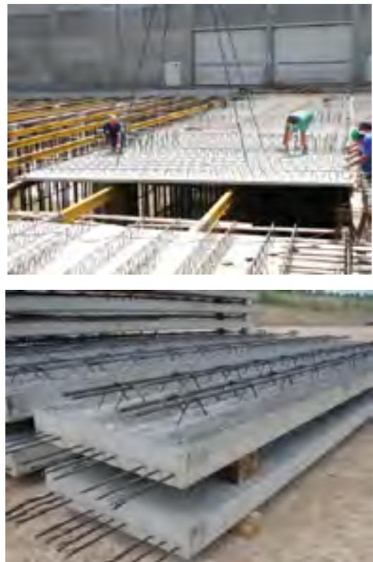
Fig. 18 - Sistema de encofrado de mediante semilosa prefabricada. Detalle de semilosa prefabricada.
