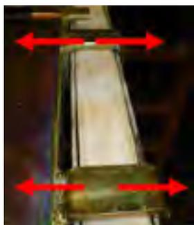
La colocación de la plataforma de trabajo se realizará apoyándola en sus extremos sobre las consolas de trabajo. El movimiento relativo entre plataforma y consola, quedará impedido en su sentido longitudinal gracias a los enganches en forma de U con que cuentan las plataformas.
