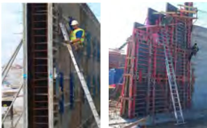
Fig. 8 - Trabajo de montaje de elementos auxiliares en encofrados verticales desde escalera de mano y con empleo de arnés de seguridad.
