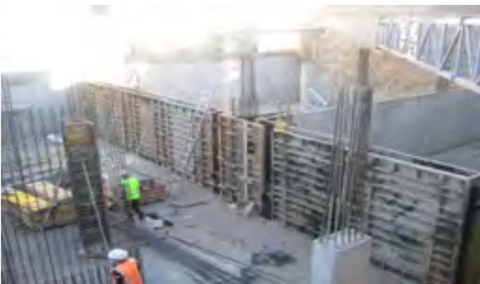
Fig. 4 - Paneles de encofrados verticales en muros de edificación.
