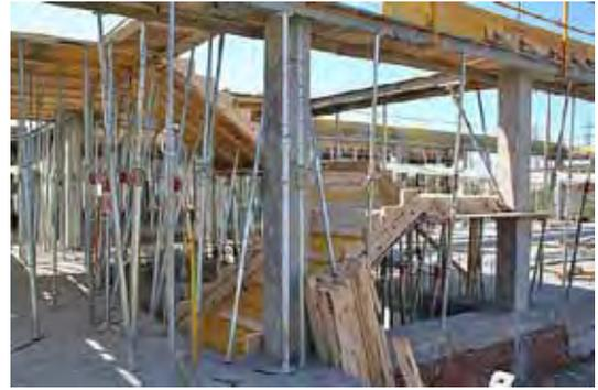
Fig. 67 Encofrado simultáneo de escaleras de acceso entre forjados
