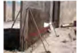
*Apeo deficiente de la primera cara del encofrado mediante puntales tradicionales*
