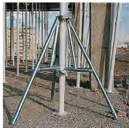
Fig. 64 - Trípodes de estabilización de puntales
