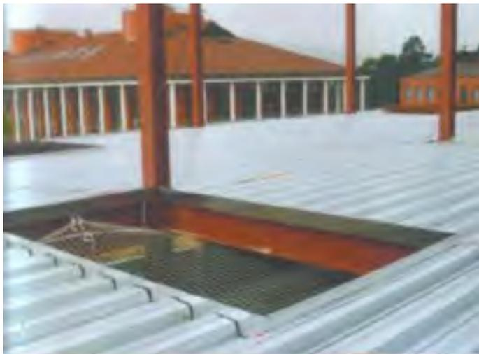
Fig. 29 – Encofrado con chapa colaborante en estructura metálica.
