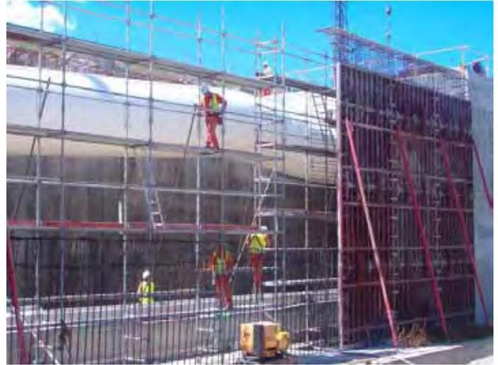
Fig. 74 – Andamio en intrados para montaje de armadura.
