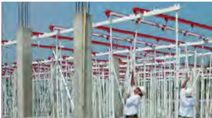
Fig. 24 – Sistema de encofrado para realizar forjados reticulares
