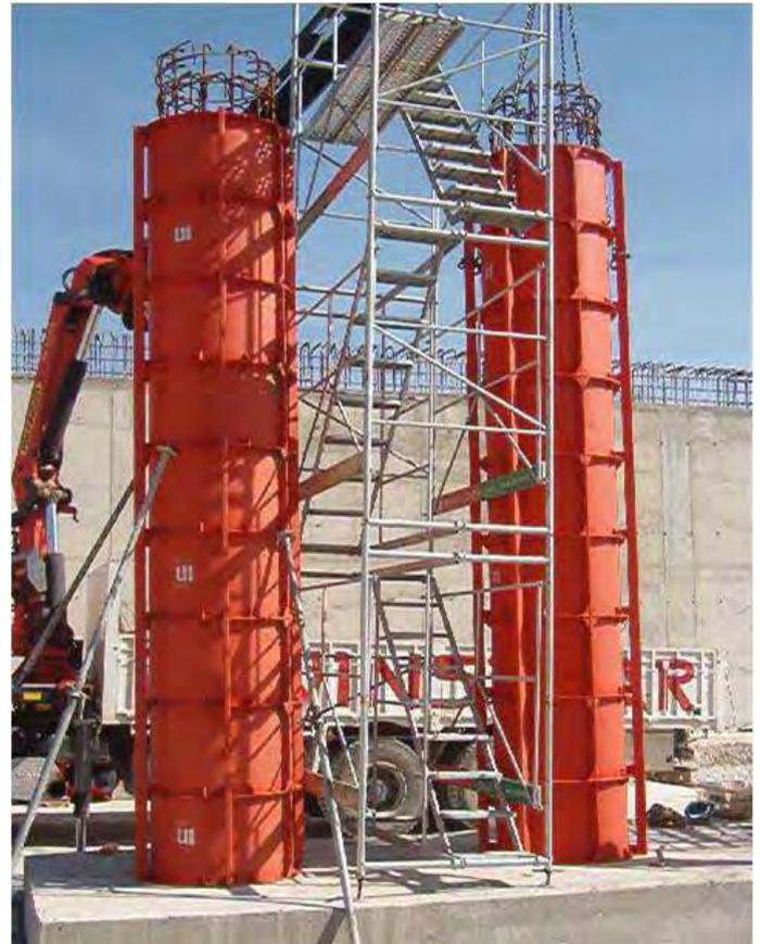
Fig. 77 Encofrados estándar metálicos de pilas
