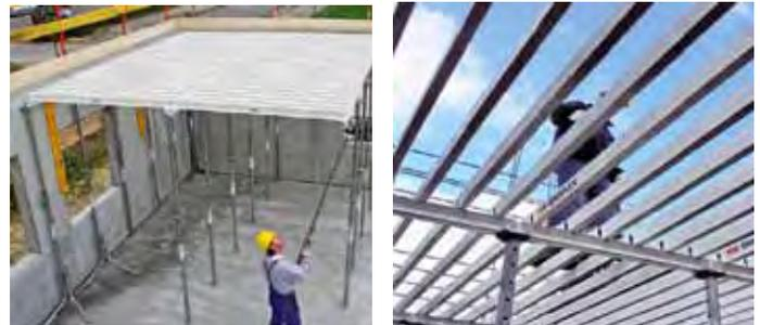
Fig. 70 – Secuencia del montaje del forjado desde el nivel anterior.
