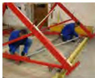
6. Sobre las consolas prefabricadas, situamos en su sitio el primer tablón o viga PERI para realizar la plataforma de trabajo. Estas vigas o tablonos se unen a la consola, mediante tirafondos 8/80.
