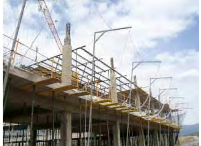
Fig. 53 - Redes tipo horca en forjados de edificación
