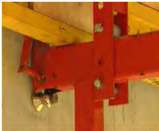
3. Montar el panel de encofrado sobre la consola y fijarlo a los puntos de unión (según tipo de encofrado ver información específica)
