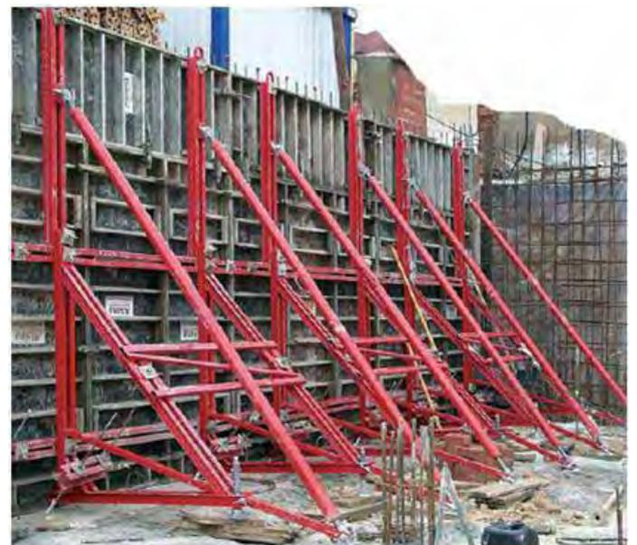
*Fig. 78 Apeos y arriostramiento en encofrados a una cara. El primero está constituido con puntales tradicionales, los cuales no garantizan la transmisión de cargas. El segundo corresponde a las tornapuntas de un sistema de encofrado.*
