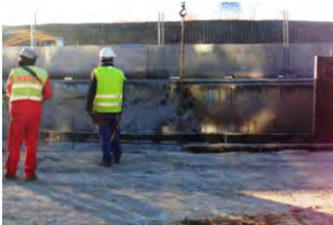
Fig. 3 - Desmontaje de paneles de encofrado.
