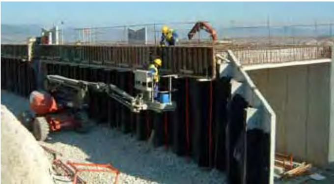
Fig. 76 - Utilización de PEMP en el montaje de encofrado de losa de paso inferior de carretera.
