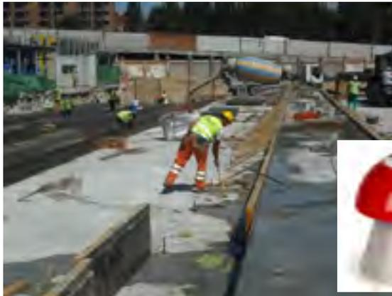
*Fig. 11 - Barras de tetracero introducidas en el hormigón de limpieza para apuntalamiento y atirantamiento de encofrados. Seta de protección para esperas de armadura.*
