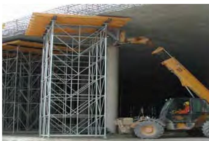
Fig. 68 – Ejemplos de mesas de encofrado
