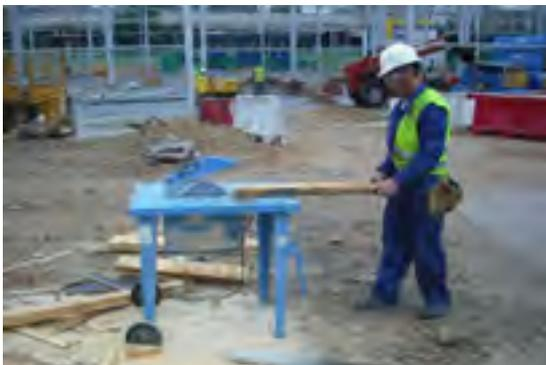
Fig.6 - Utilización de mesa de corte.
