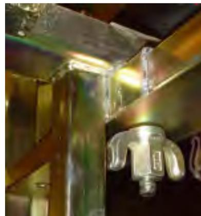
*Detalle de montaje de la consola de trabajo sobre el panel. Utilización de pasador y tuerca.*
