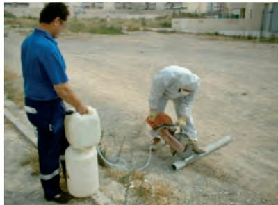
Por último, en la figura 087 podemos ver a dos trabajadores con manga y pantalón corto, con ropa de trabajo, con calzado ordinario, utilizando una cortadora radial y sin vía húmeda.
