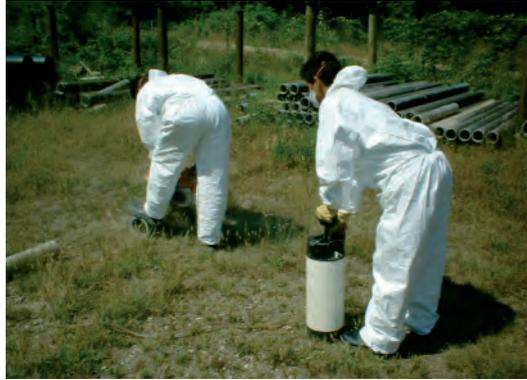
Para los casos de retirada de cubiertas o trabajos que no impliquen tareas de corte ni perforación y con materiales poco friables, deberemos rociar siempre la zona de trabajo, previamente al inicio de nuestro trabajo. (figura 039).
