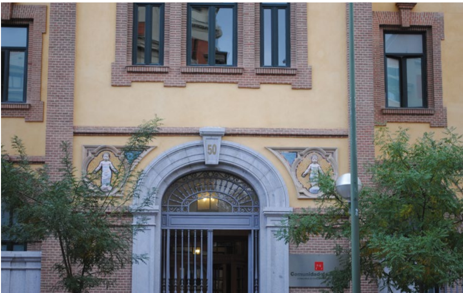
Vista actual de la puerta principal del edificio de la calle O'Donnell 50.
